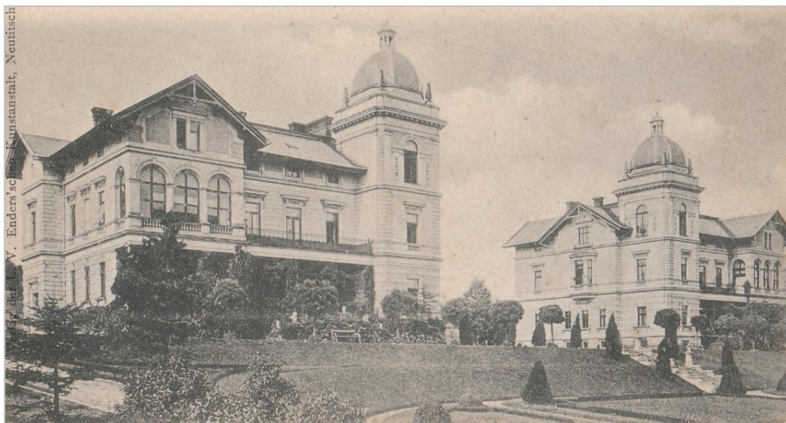
1920, pohled od východu
