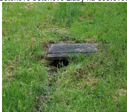
kontrolní šachta dešťové kanalizace
