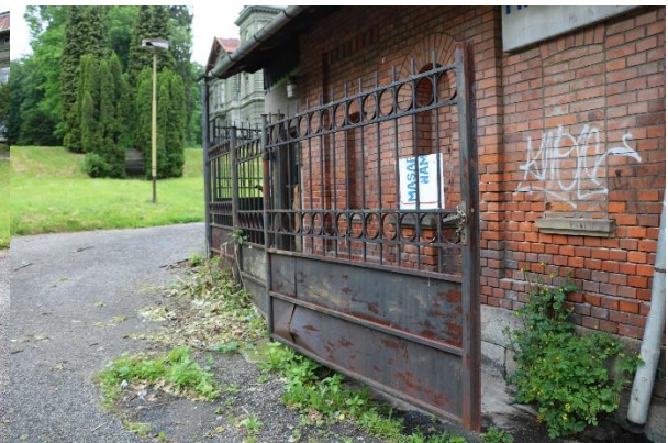
nová brána s kovovým sloupkem (pravé křídlo)
