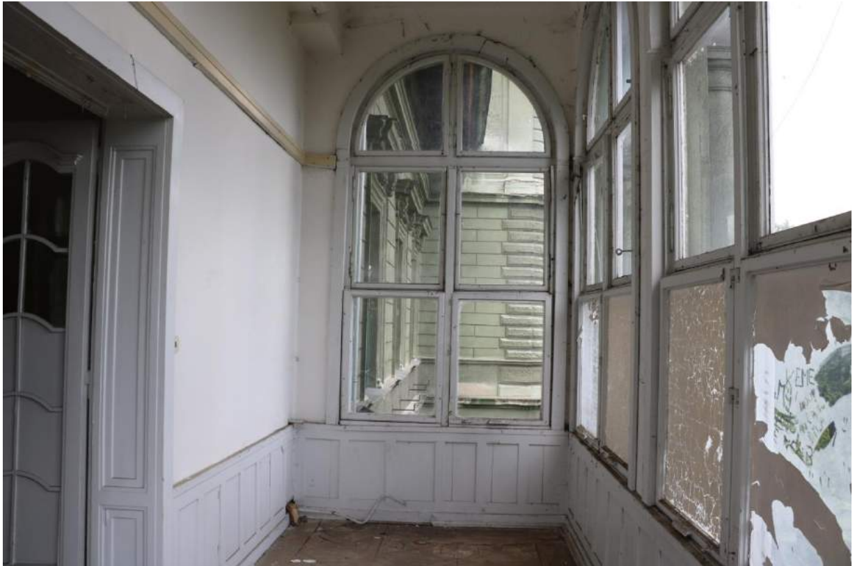
Lodžie – dřevěná okna, kazetové obklady, vlevo vstupní dveře z velkého pokoje
