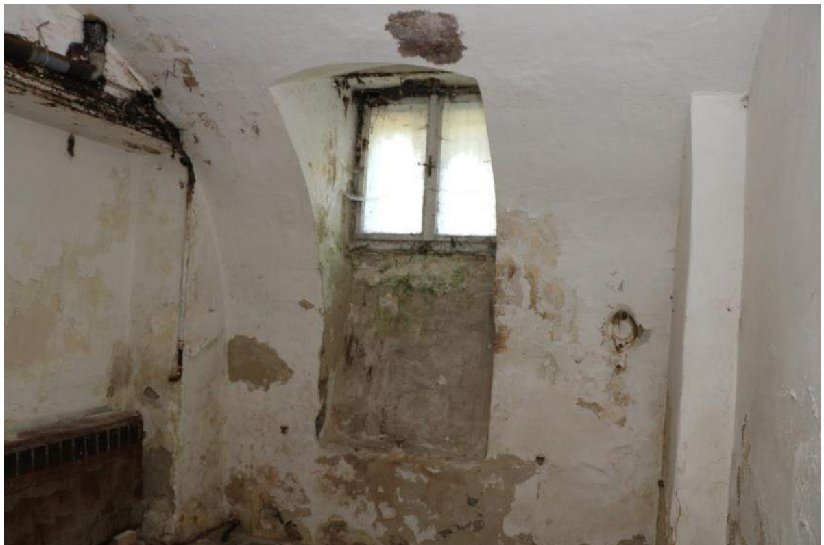
Zaklenutá místnost vedle sl.schodiště
