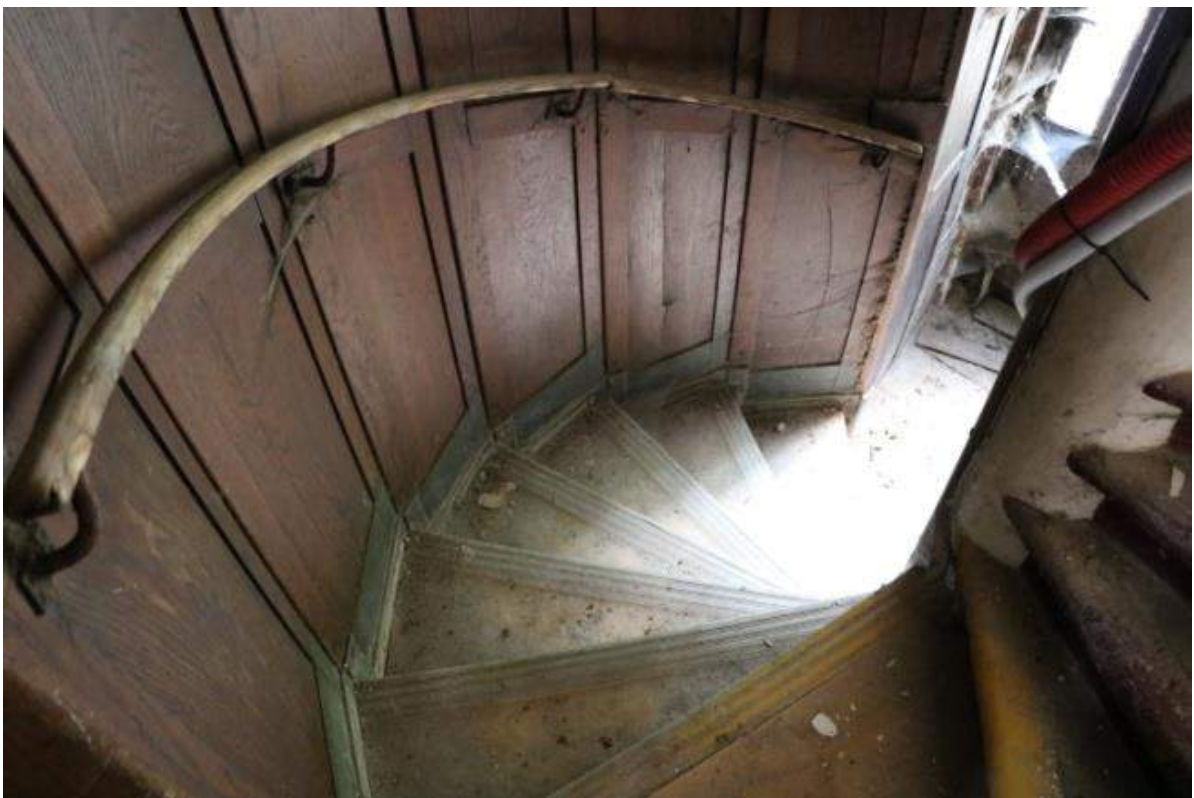
Okno ze dvora dřevěný obklady ve spodní části
