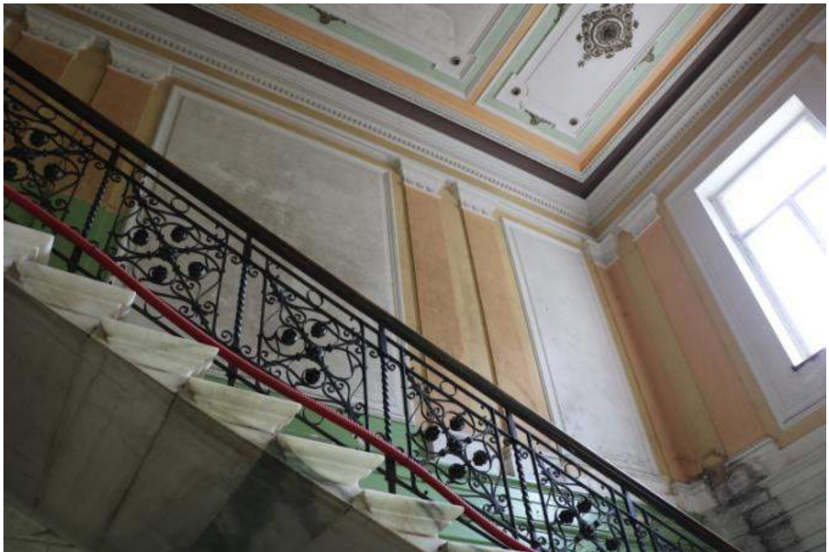
Schodiště v úrovni 2.NP - mramorový obklady – pilastry leseny
