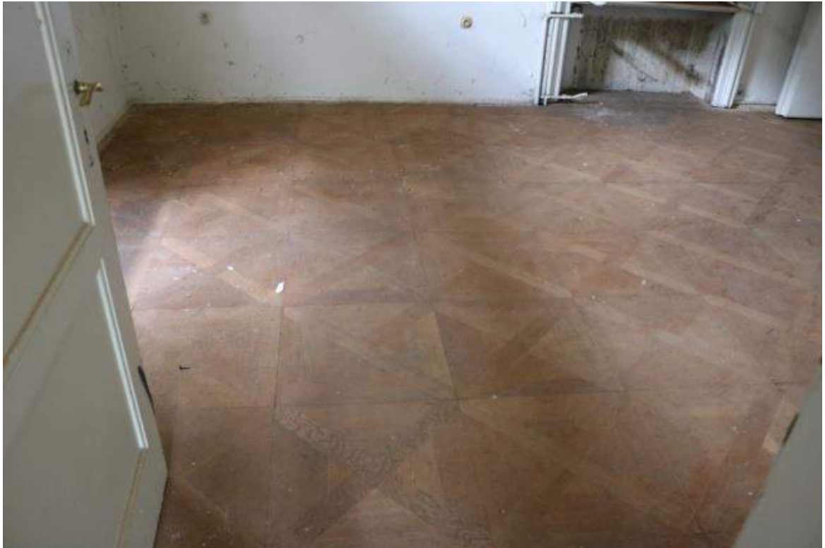
Přístavba obývací pokoj - parkety
