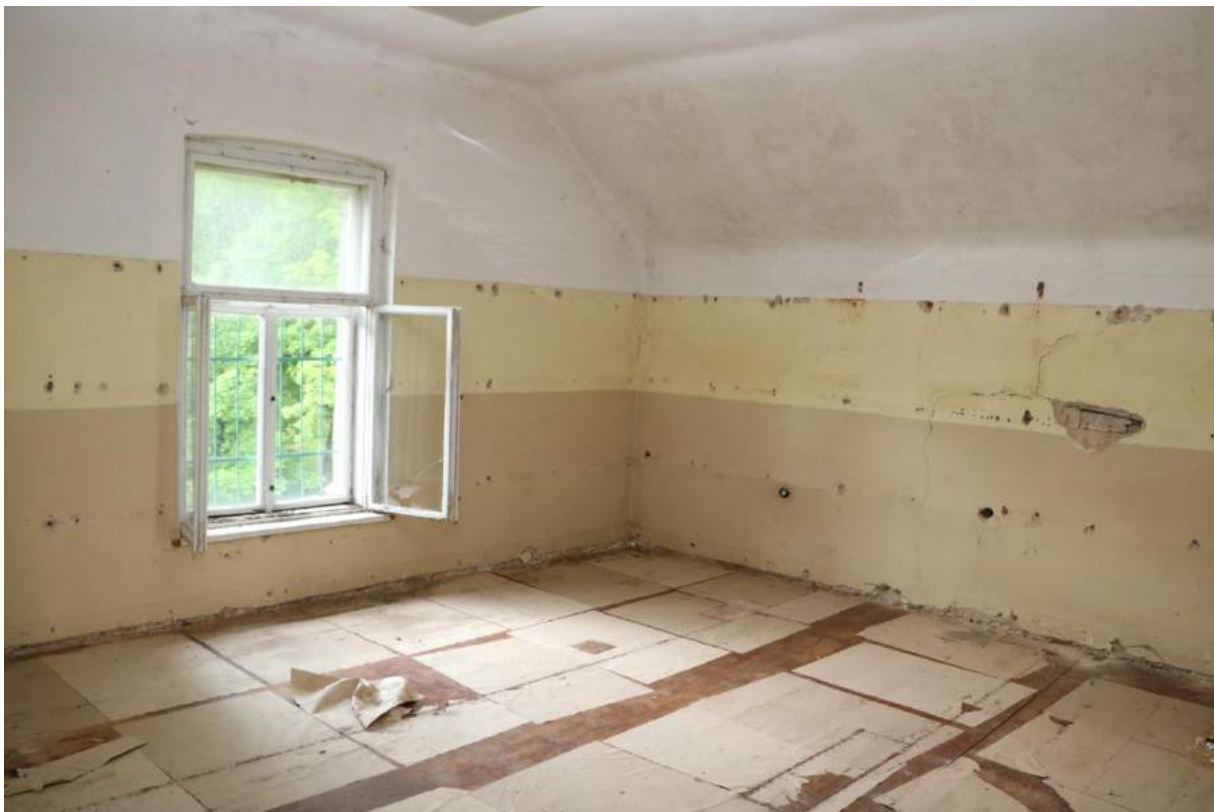
Rohový pokoj (Z), okno do štítu, noviny na prkenné podlaze jako podklad linolea z r.1947
