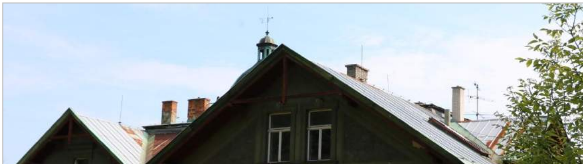
Komínové hlavy nad plechovou střešní krytinou, vpravo nový komín z bílých cihel
