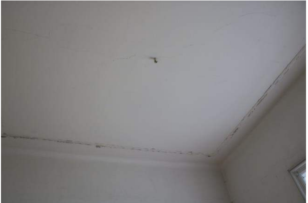
Rohový pokoj (S) - dřevěná lišta na stropě
