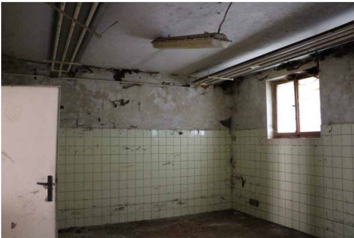
Přístavba - Šatna s rozvody nové kachličky
