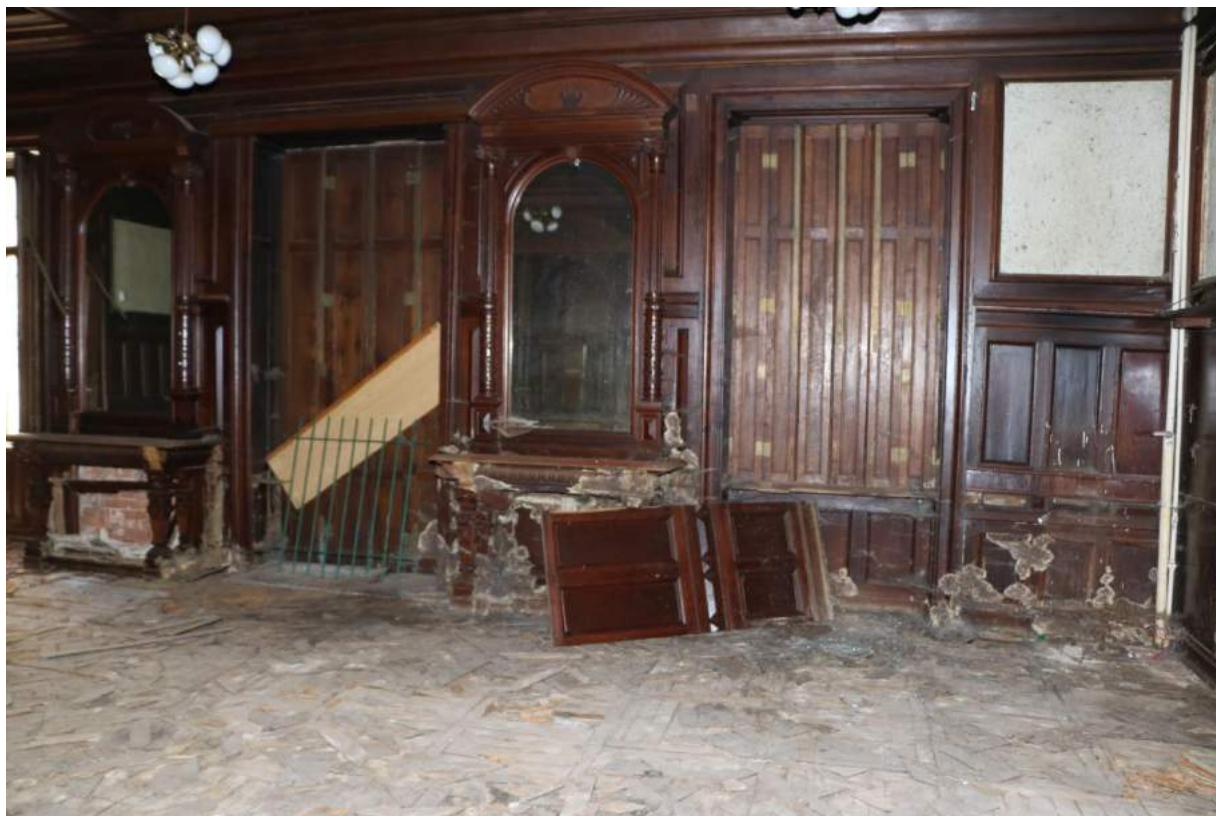
Jídelna – balkonové dveře a okna s okenicemi, mezi nimi zrcadla Parketová podlaha Všechno napadeno dřevomorkou
