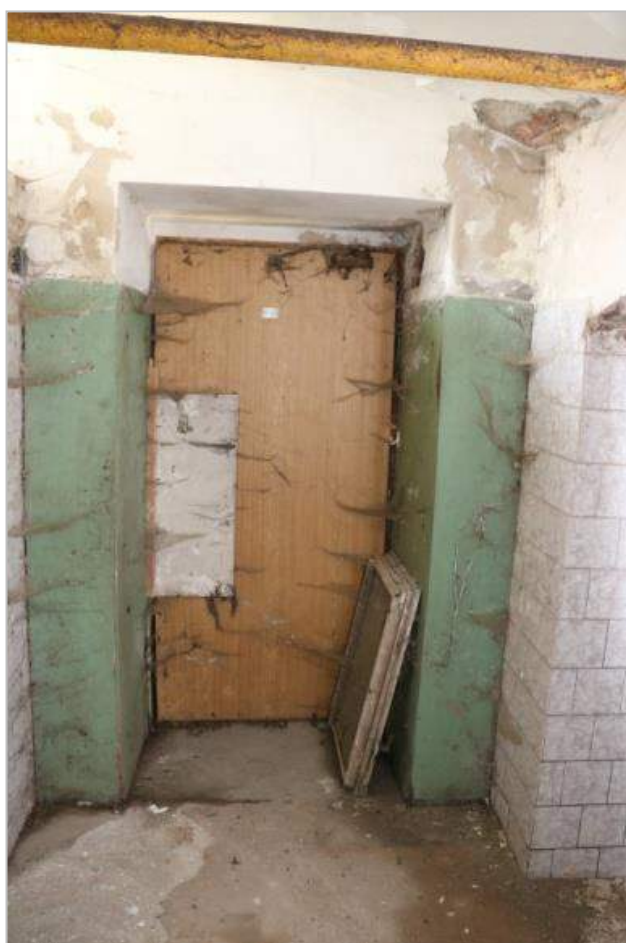
Chodbička (SV) s novými dveřmi k rampě
