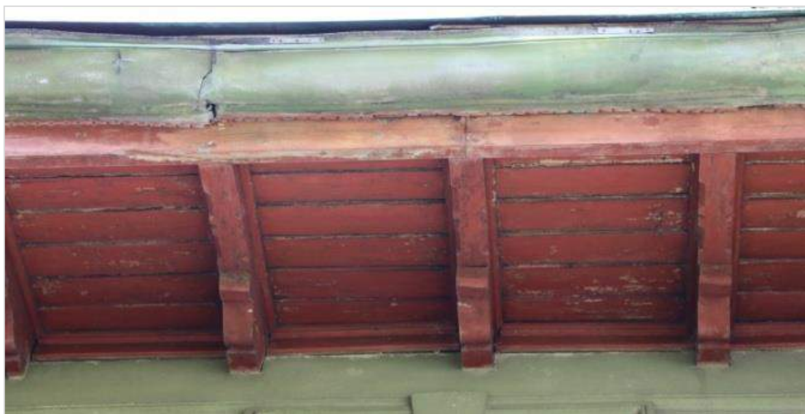
Podbití a okapový žlab překrytý plechem
