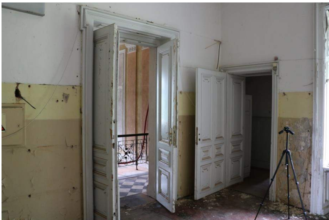
Hala se vstupem do přístavby
