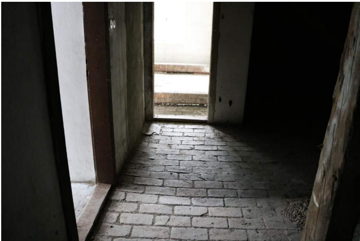
Půda (J) – vlevo vstup k výlezu na střechu
