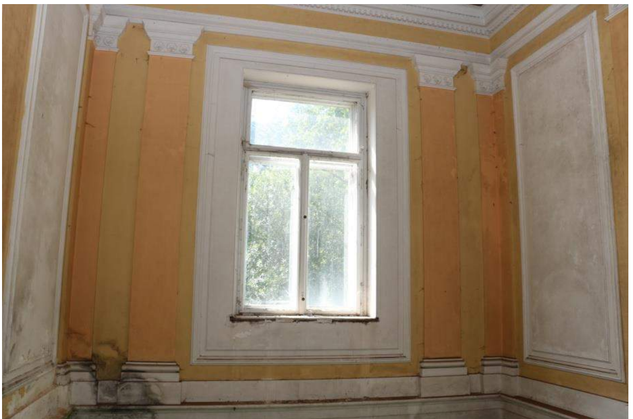
Okno osvětlující schodiště
