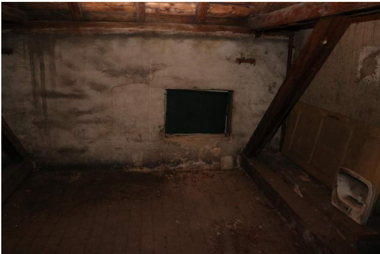
Půda (JZ) - krov, zakryté okno
