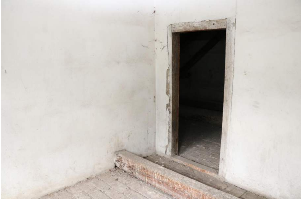
Půda (J) - vchod – východ
