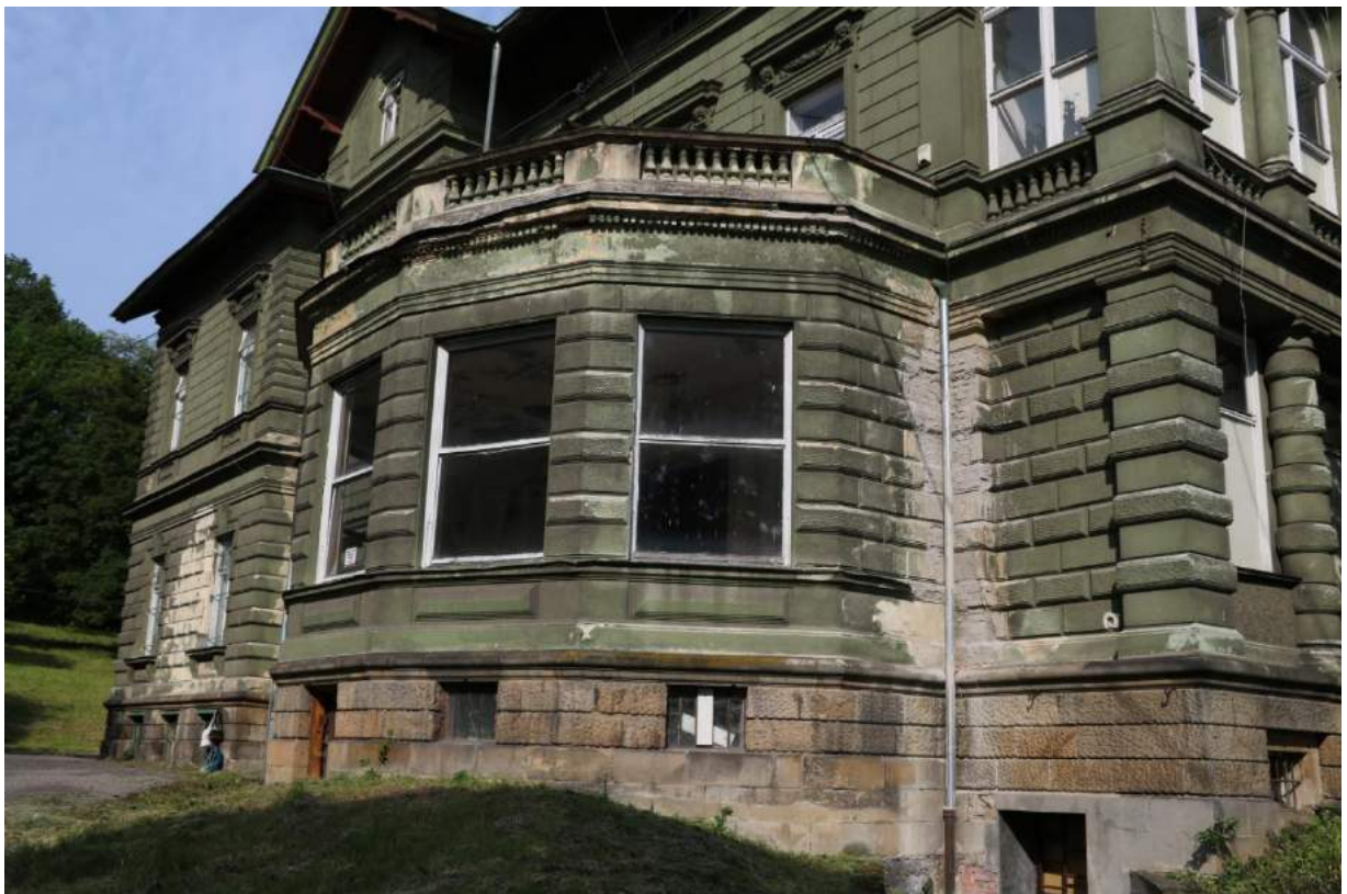
Přistavěná veranda s terasou Okna stahovací, terasové zábradlí zdobené polokuželkami
