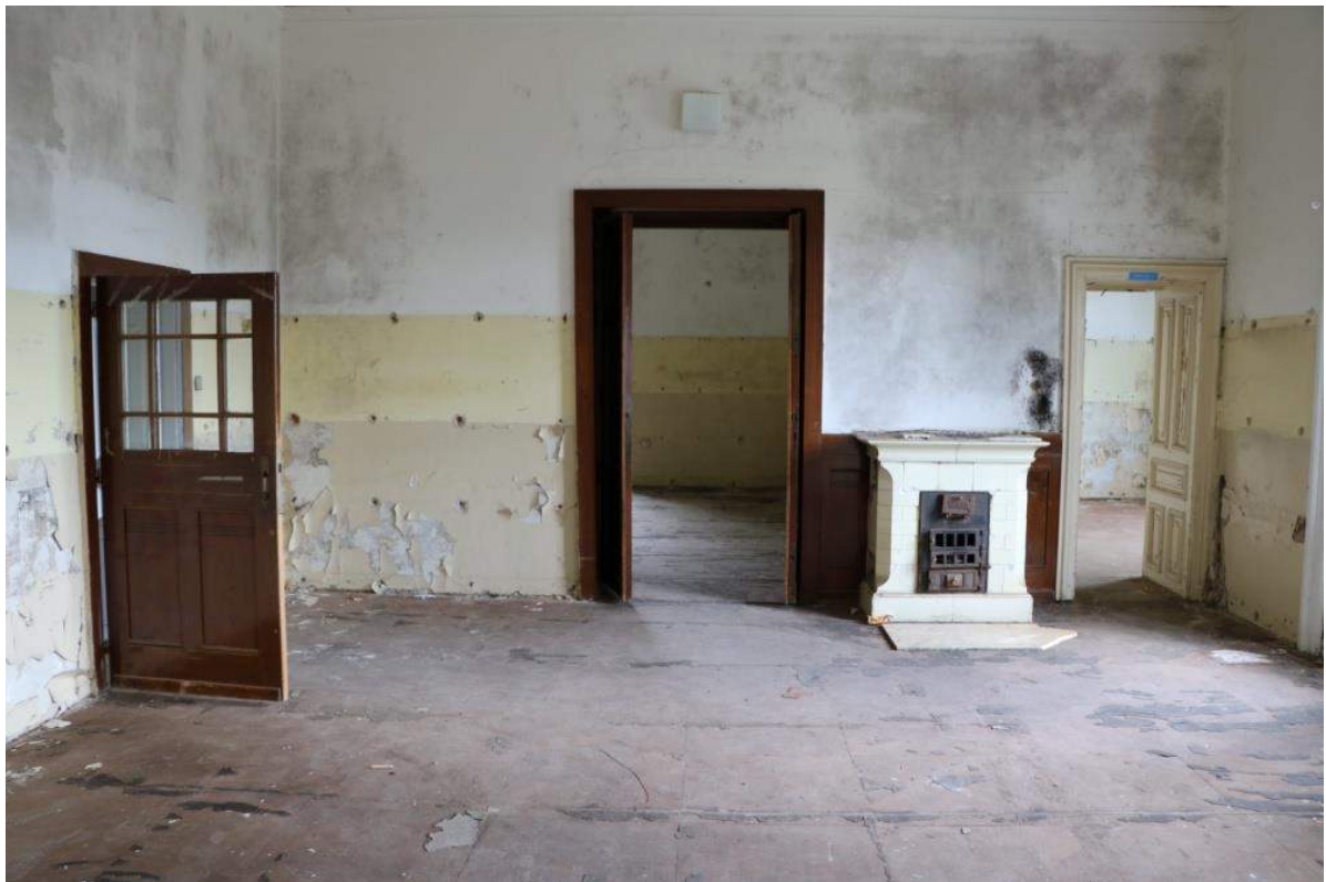
Velký pokoj (SV) - hnědé malé dveře do chodby, malé bílé dveře do tělocvičny
