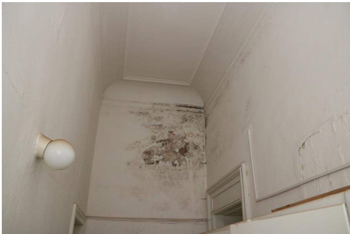
Přístavba – šatna se vstupem do koupelny, dřevěným obložením, štukovým stropem
