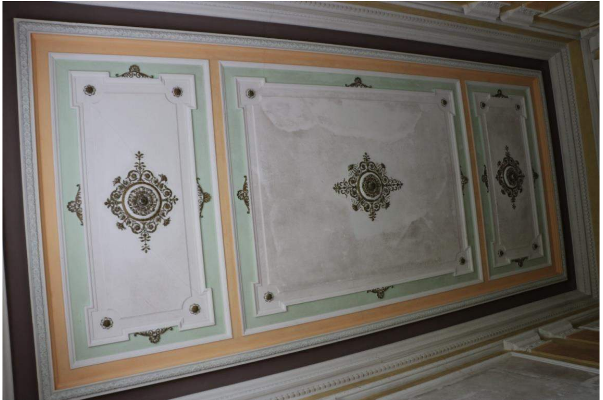
strop nad schodištěm
