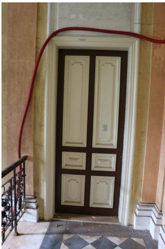
Vstup do přístavby z podesty 2.NP
