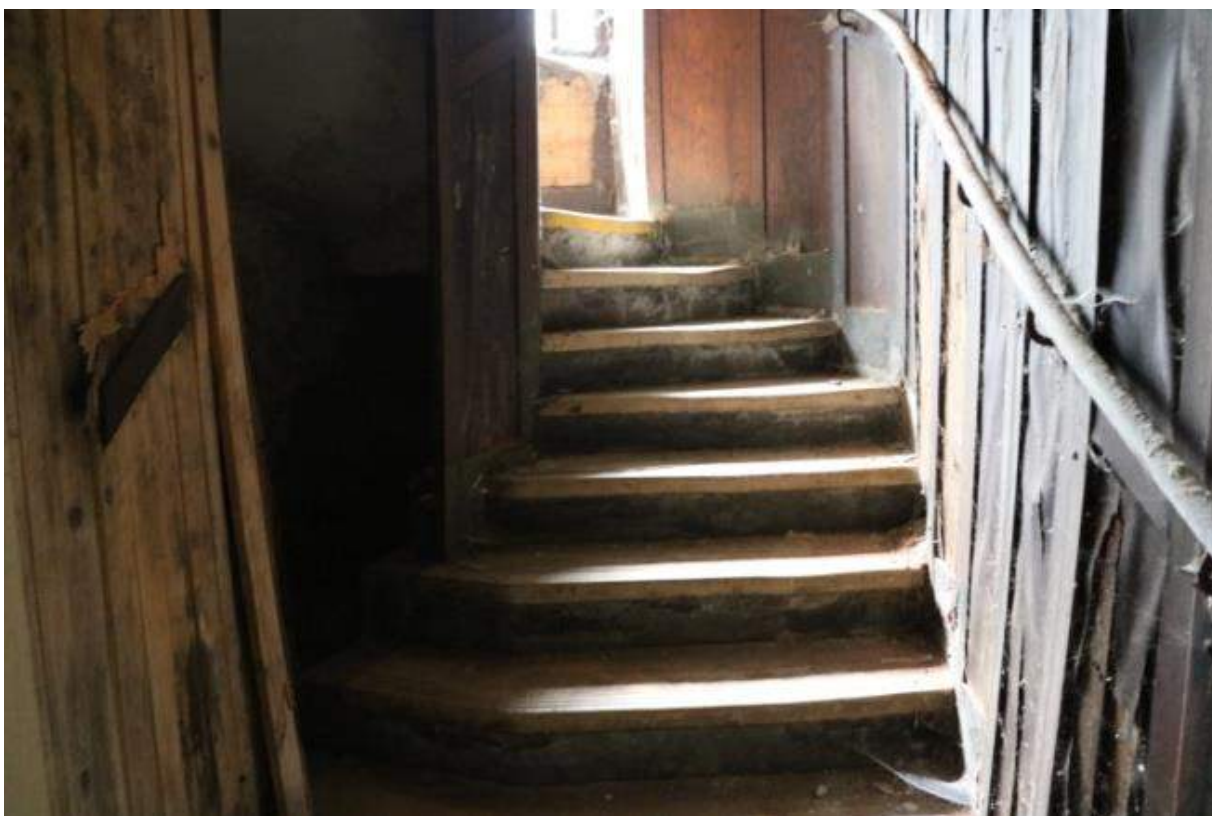
Dřevěné kazetové obložení mezi sklepem a 1.NP.
