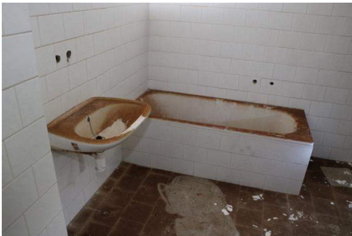
Místnost vedle sl.schodiště - -koupelna nové zařízení
