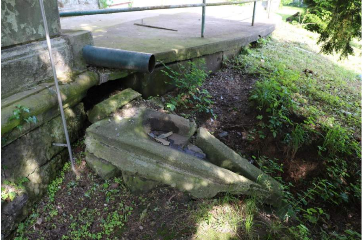
Odvod dešťové vody u terasy
