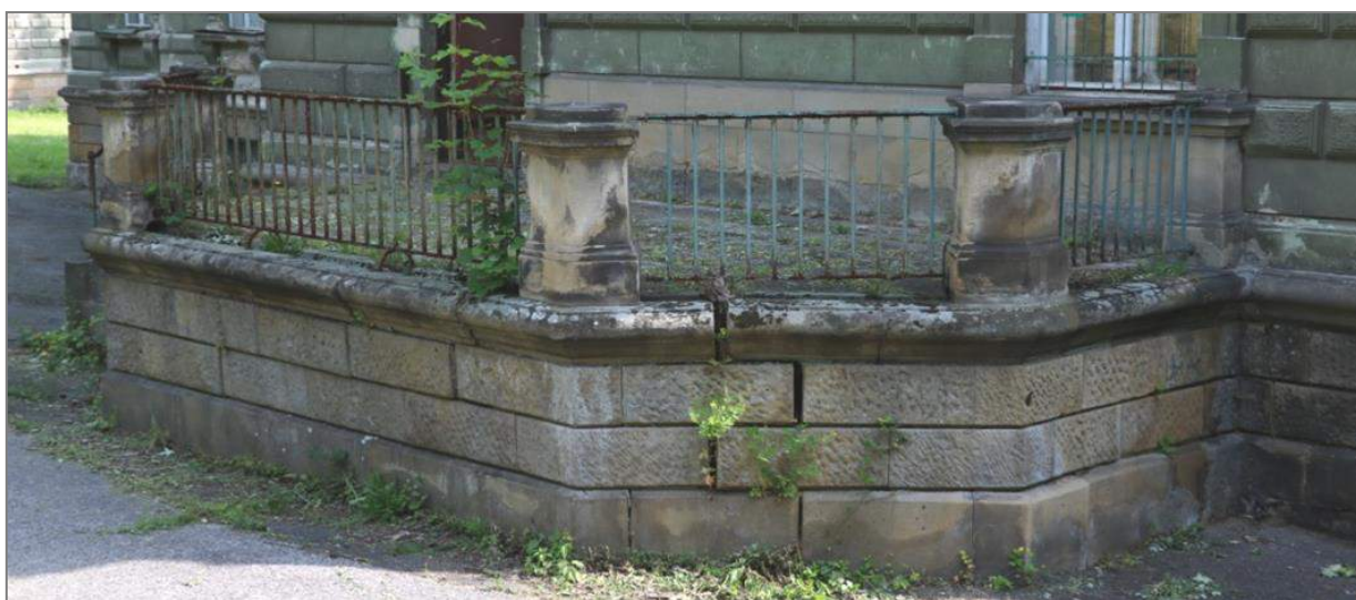
Zahradní terasa se schodištěm pod sloupky i po okraji terasy je odvodňovací žlab
