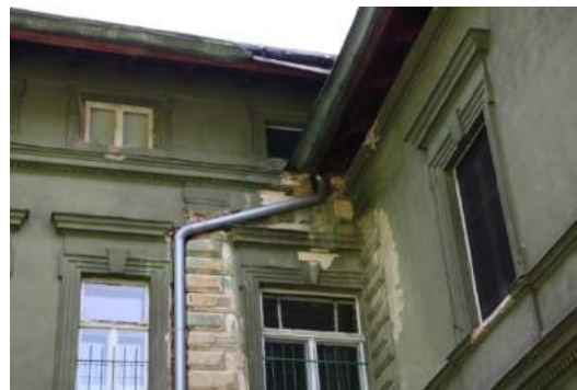
napojení přístavby k původní budově
