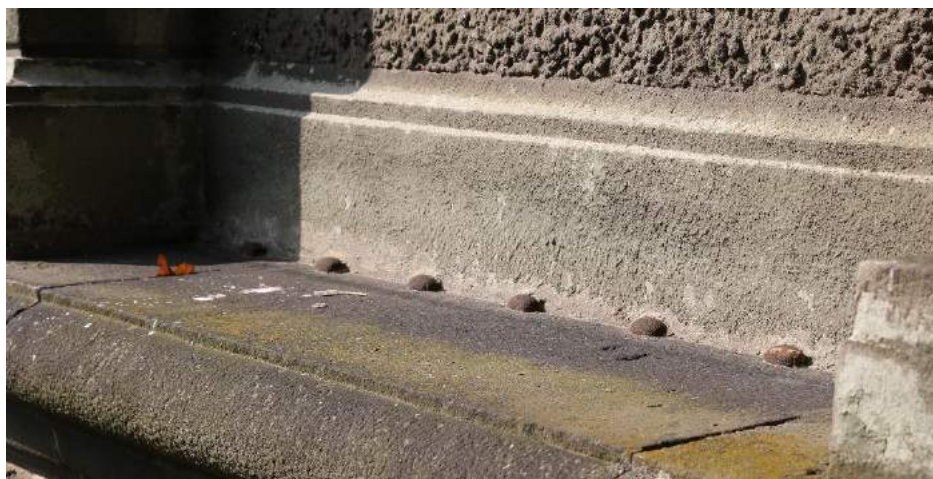
Sklepní okno pod lodžii – vložené železné koule
