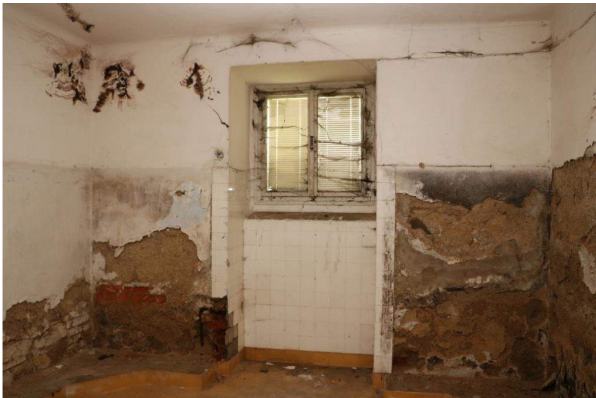
Rohová místnost v podvěží – okno, betonové podstavce
