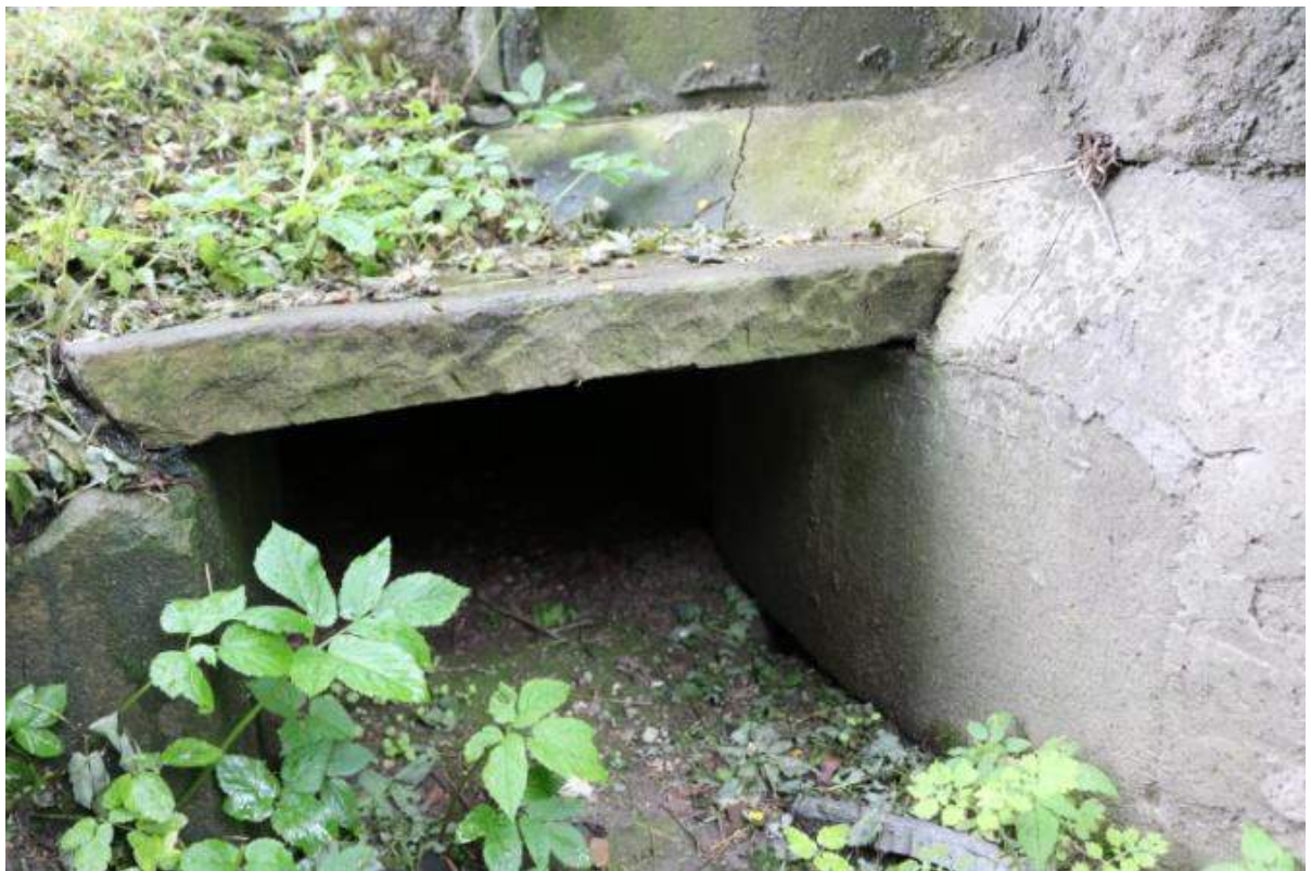
Kanál na dešťovou vodu pod terasou
