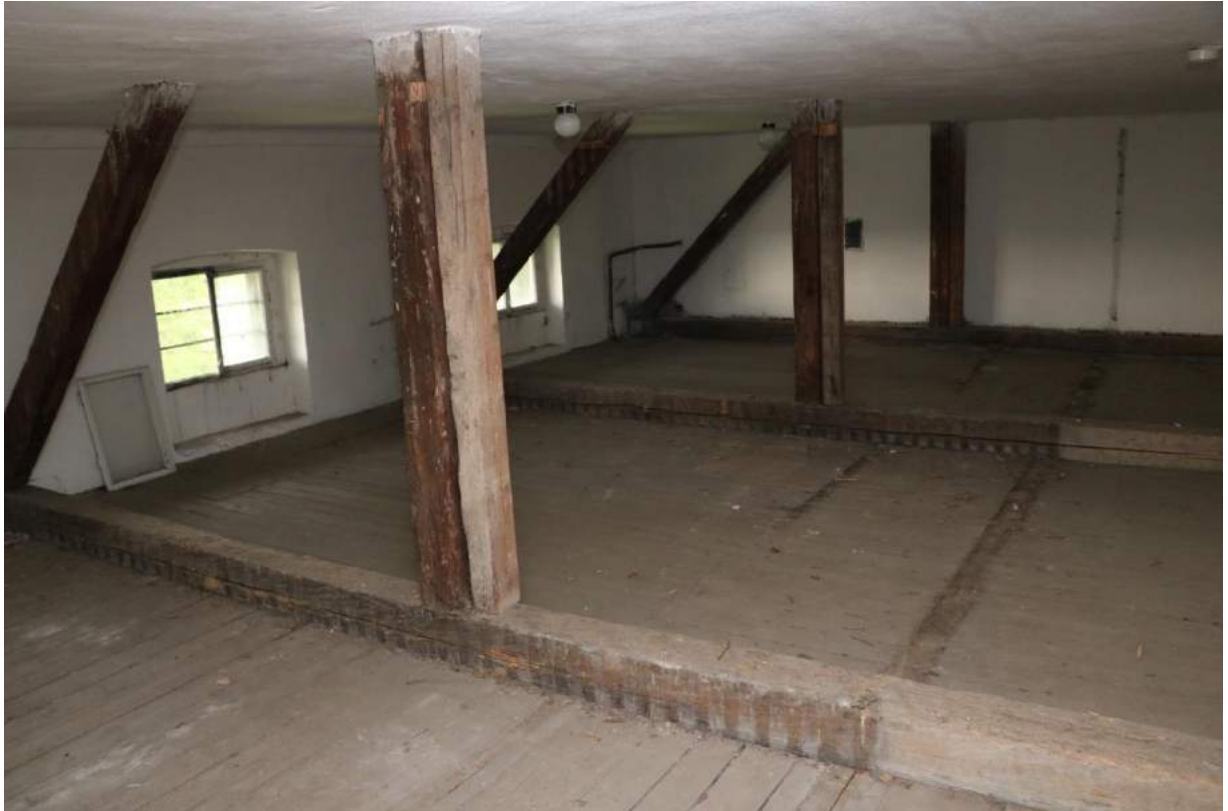
Půda (SV) – krov, dvoukřídlá okna, prkenná podlaha
