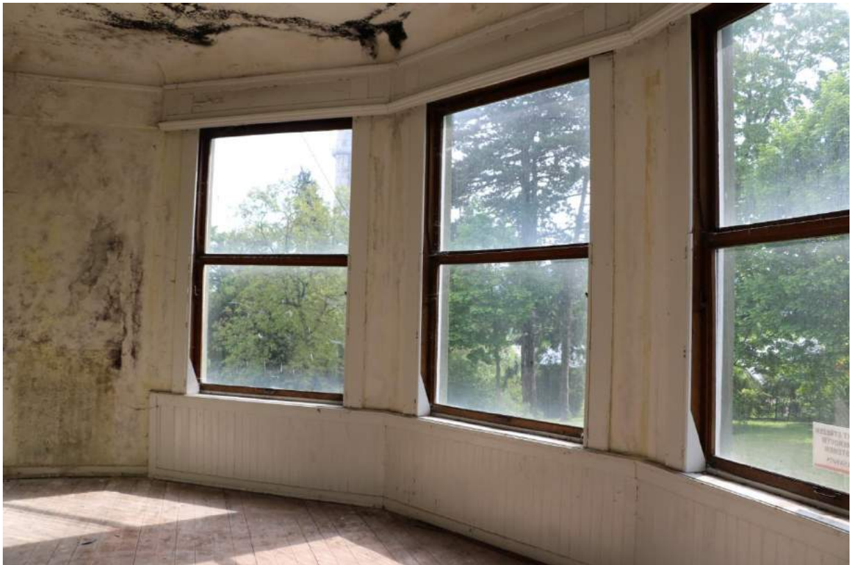
Veranda prkenná podlaha, anglická stahovací okna s dřevěným obkladem a parapetem
