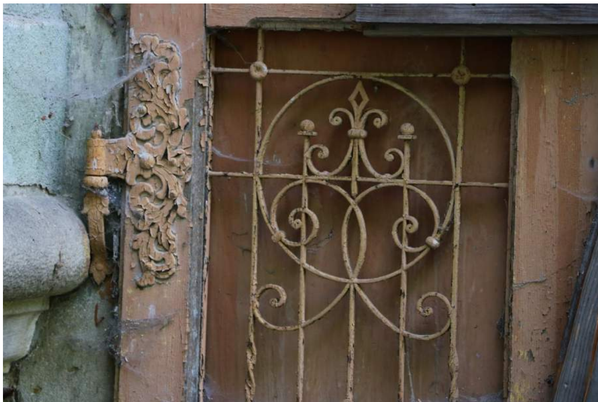
Kování a mříž na dveřích do sklepa (detail)
