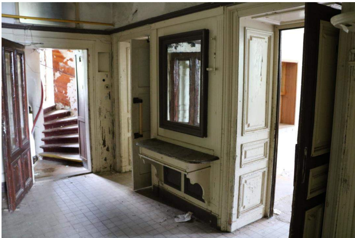
Chodba se vstupy na sl.schodiště do přípravný a do kabinetu, toaletní stolek
