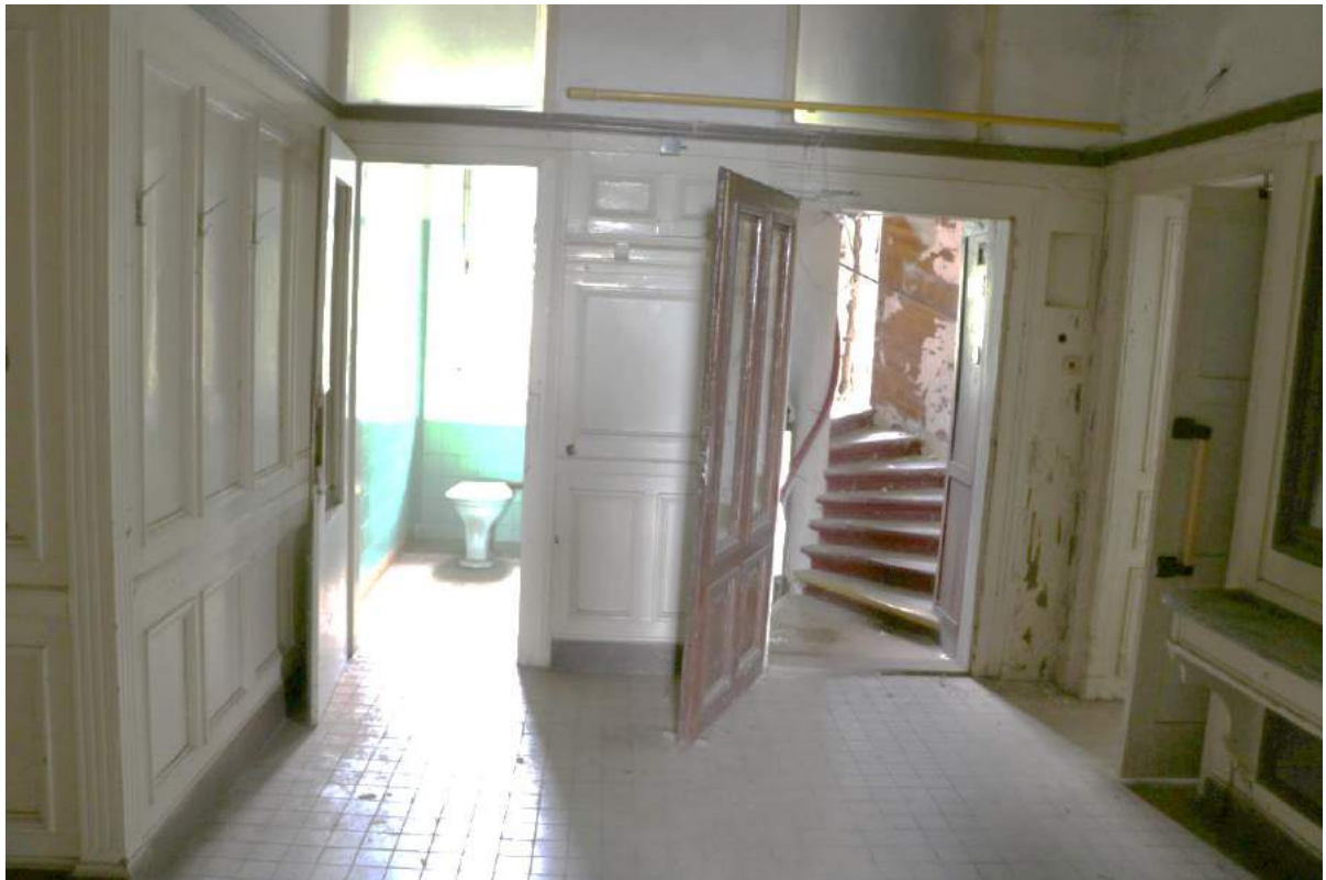
Chodba – záchod a vstup na schodiště
