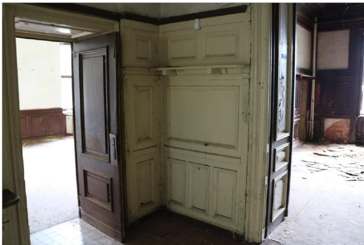
Dřevěný obklad stěn u jídelny a velkého kabinetu
