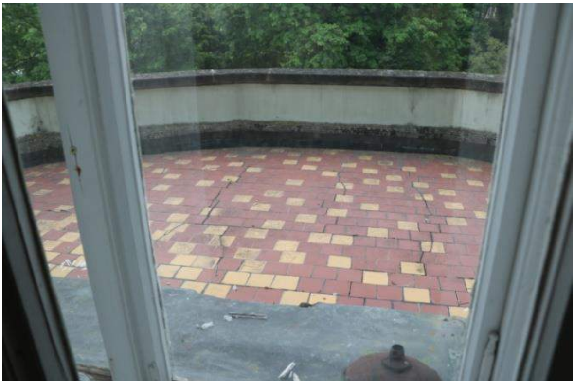
Terasa verandy – nová dlažba
