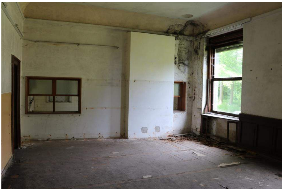
Nová výdajová okna a vestavěný výtah
