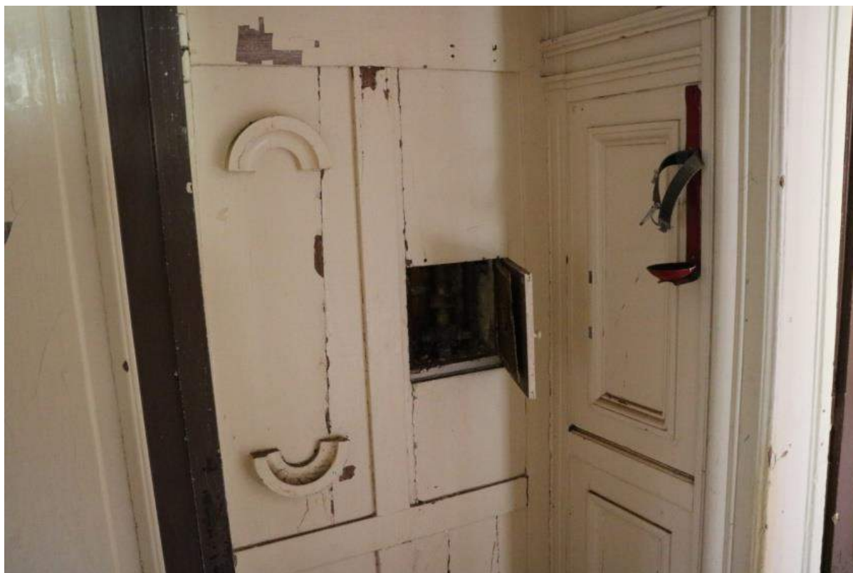
Chodba - skříňka v obkladu
