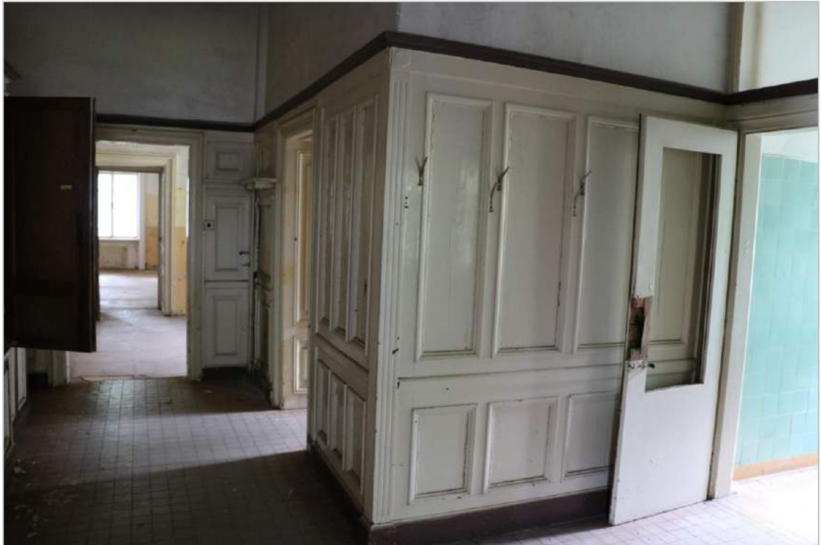
Chodba - obložení stěn
