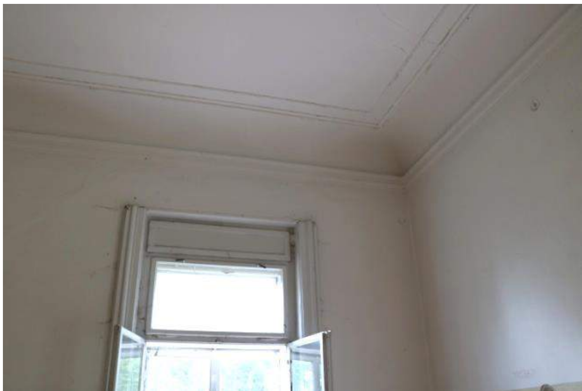
Přístavba Ložnice – štukový fabionový strop
