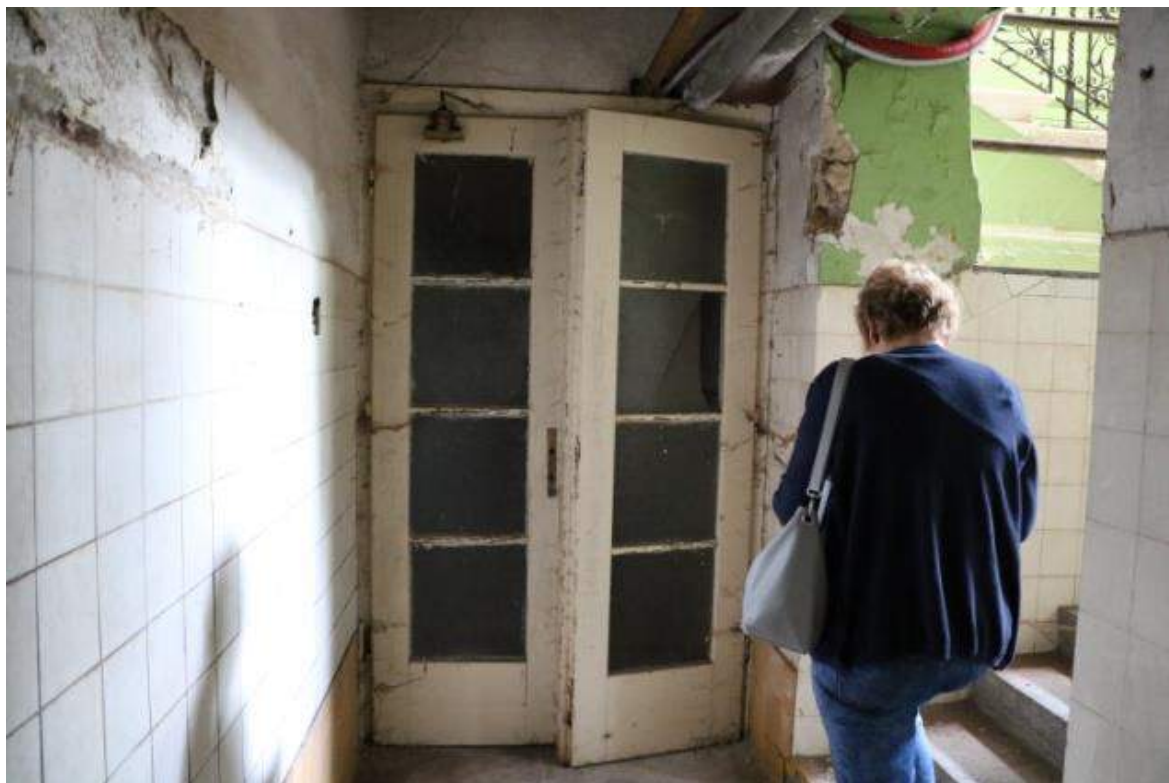
Dvře do původního sklepního prostoru a schody k hlavnímu vstupu do budovy
