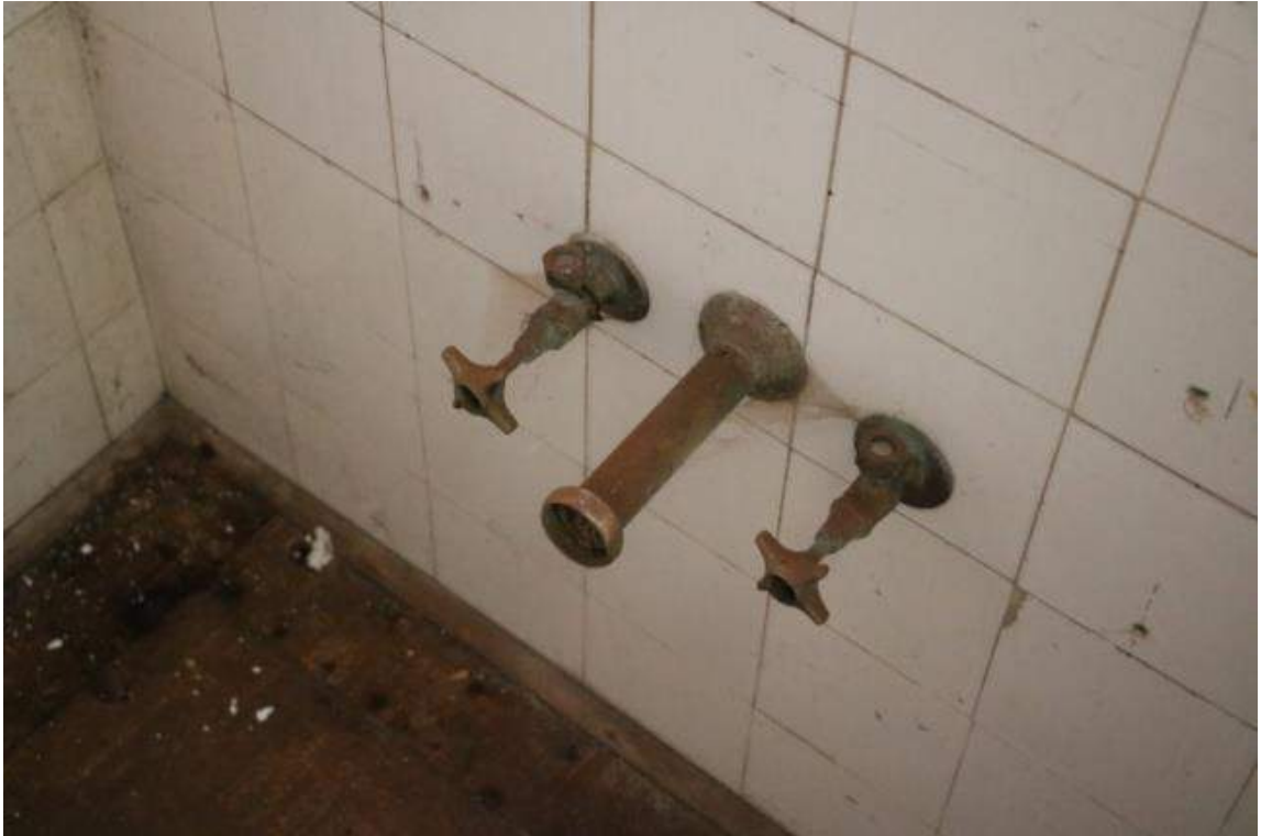
Původní obklad přívod vody v umyárně
