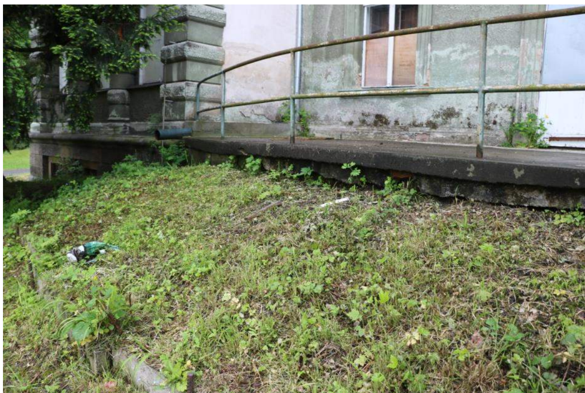
Terasa - zeminou zavezené původní schodiště
