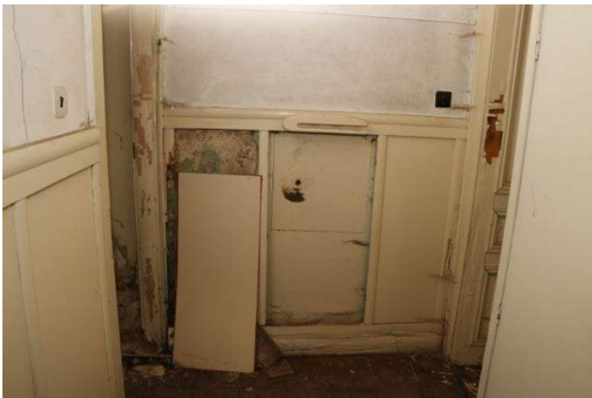
Přístavba - šatna s dřevěným obkladem
