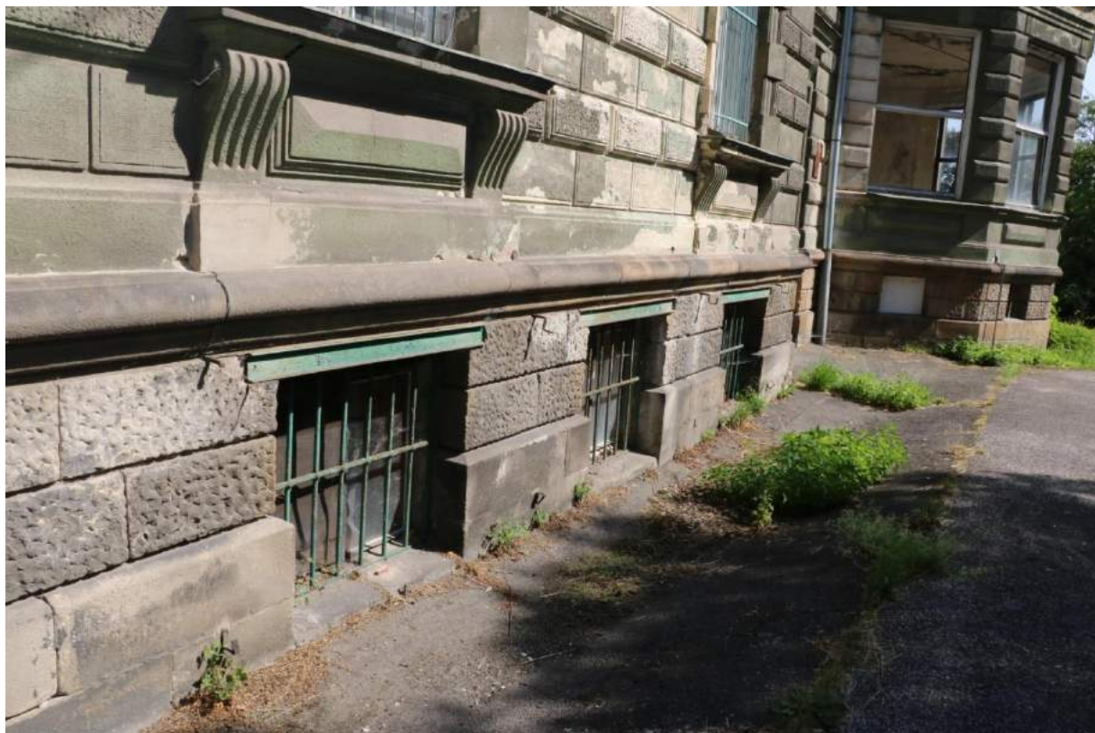
Sklepní okna a kovové háky na treláže
