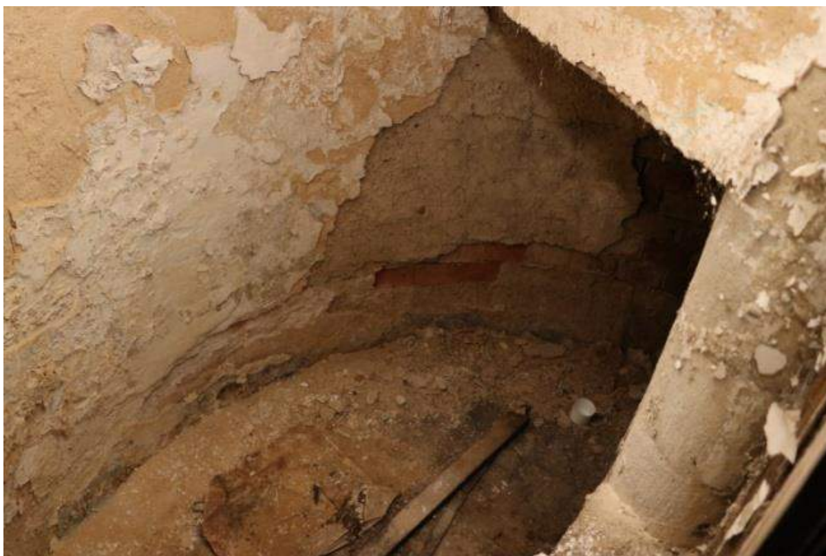
Spodní část schodiště ve sklepě
