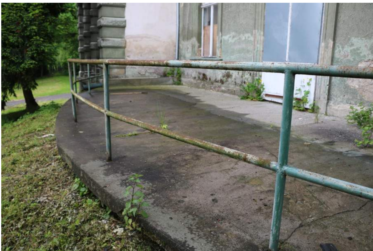
Rozšířená terasa s trubkovým zábradlím, Zazděná původně otevřená lodžie
