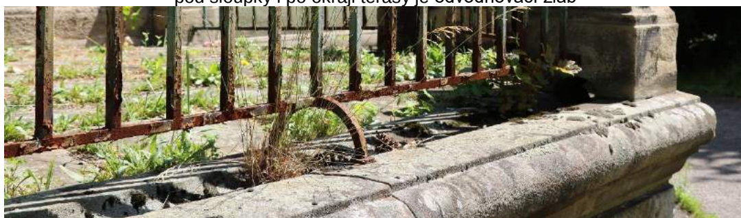
Zahradní terasa se schodištěm pod sloupky i po okraji terasy je odvodňovací žlab
