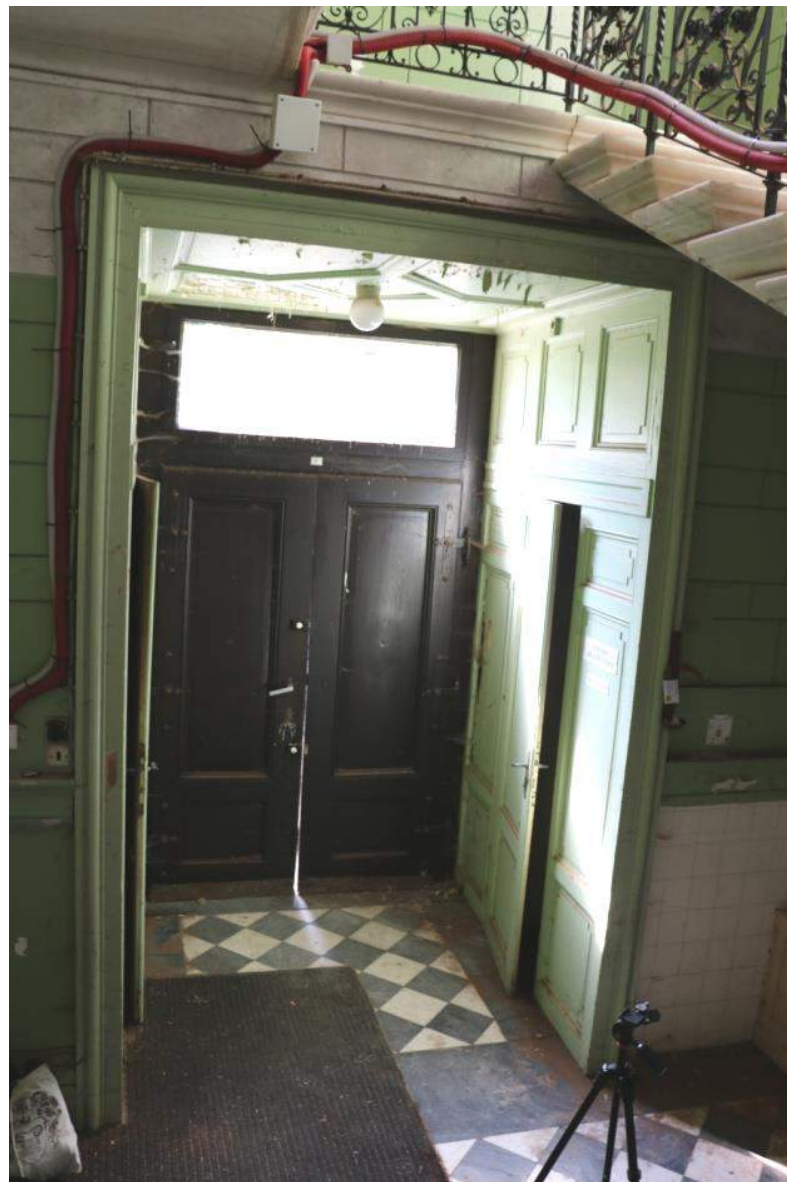
Vstupní prostor (předsíň) – deštění, dveře s nadsvětlíkem, vlevo šatna, vpravo umývárna
