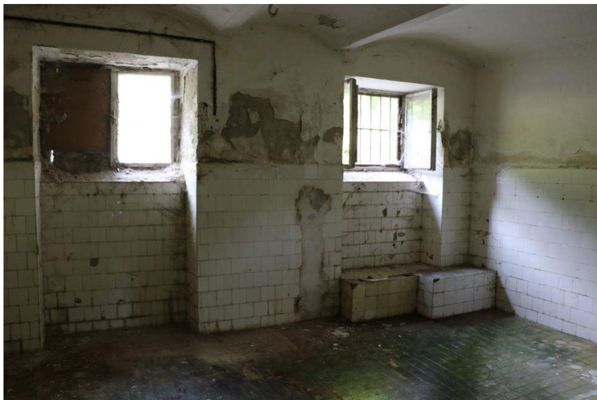
Rhová místnost (Z) příprava – původní okna, nové obklady a dlažba
