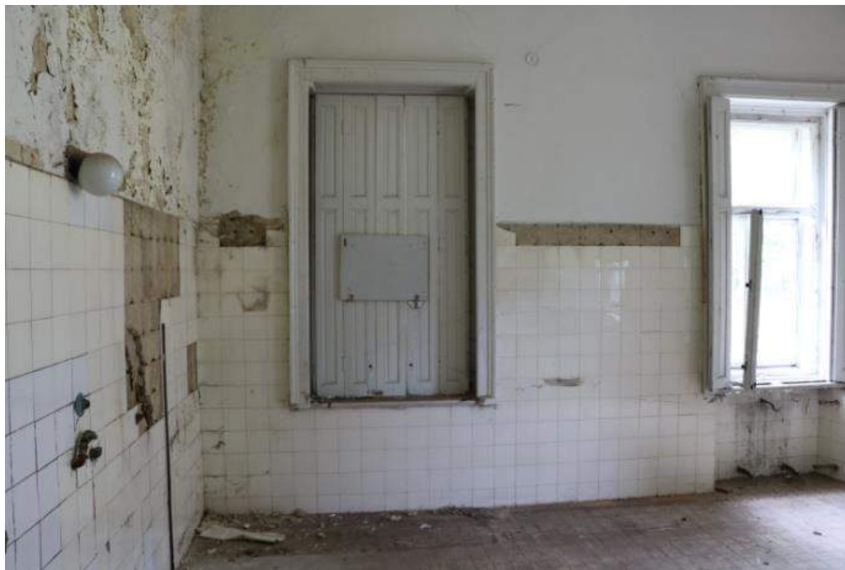
Přípravna - nový obklad a dlažba
