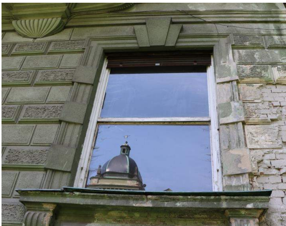
1.NP - anglické okno kabinetu (SZ) s dřevěnou roletou
