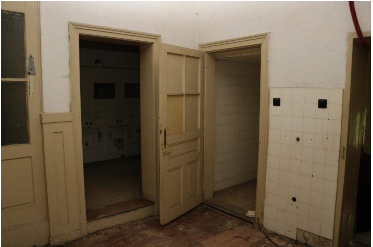
Hala Dřevěné obložení umývárna a záchod
