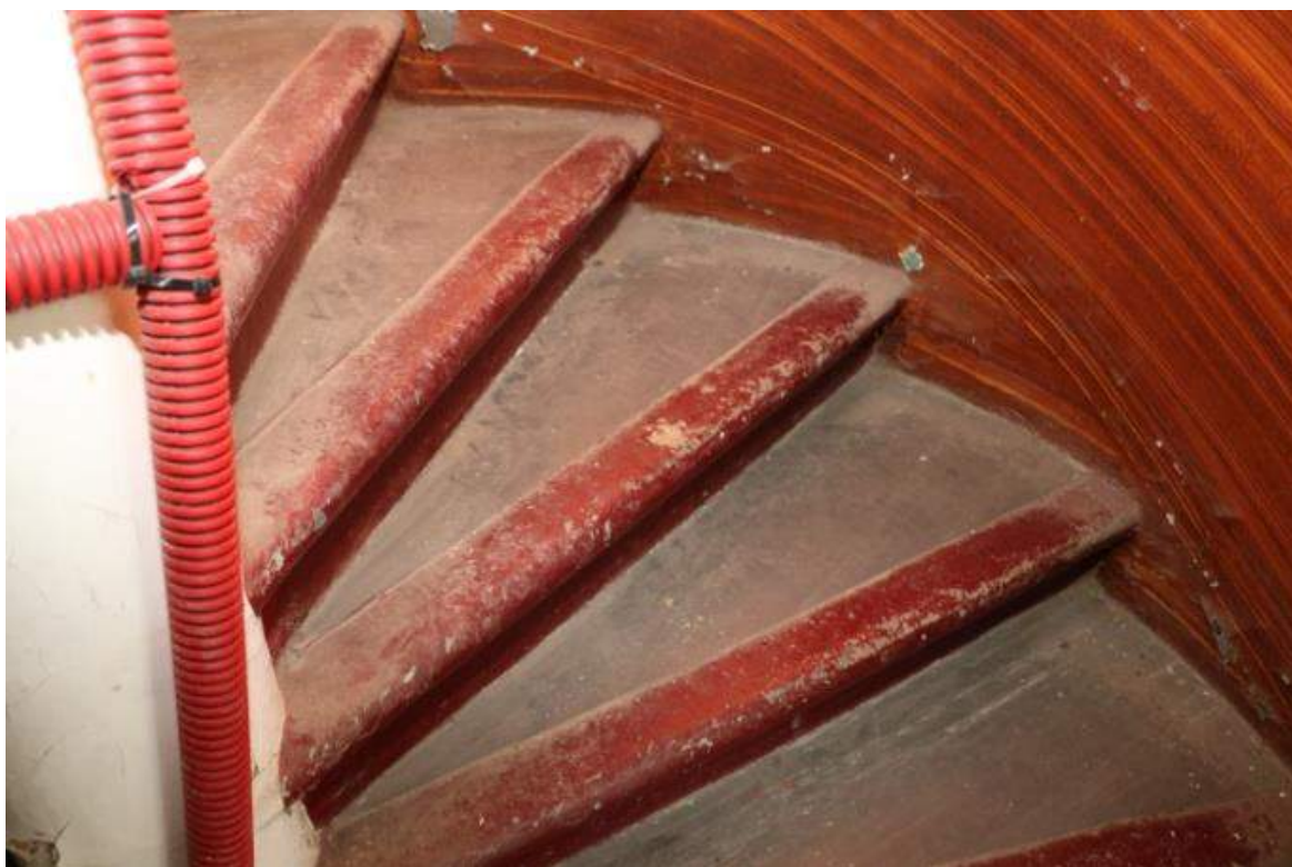
Fládrované stěny v horní části
