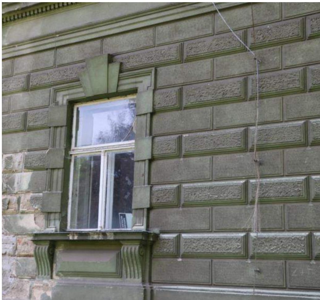
okna v 1.NP s volutovým parapetem
