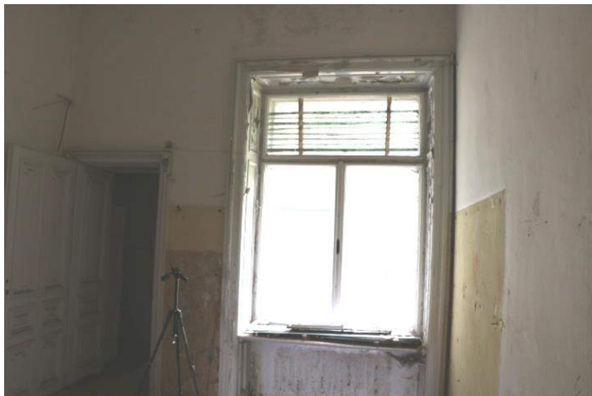
Hala – okno osvětlující halu
