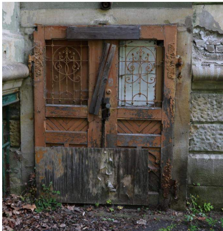
Secesní dveře do sklepa s kovanými panty a zdobnou mříží
