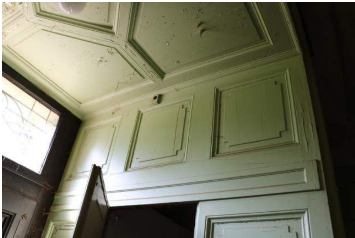
Kazetové bednění předsíně
