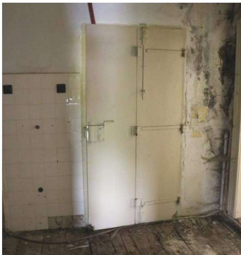
Prosklené a protipožární dveře do podkroví
