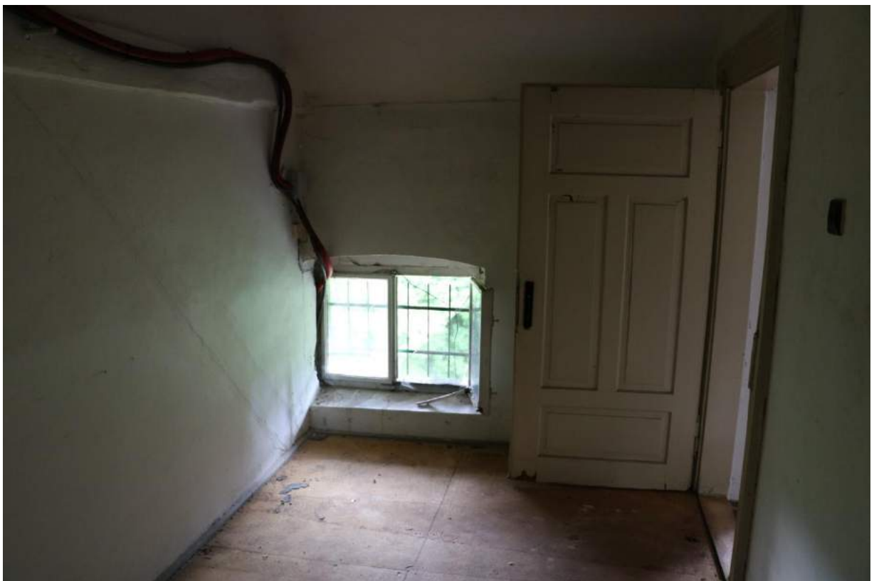
Chodba – okno na JV, vstup do pokojíku k J
