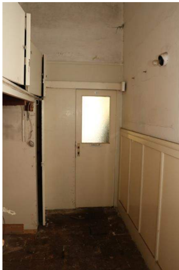
přístavba – šatna s dřevěným obložením a vestavěnými skříněmi a vstupem do koupelny
