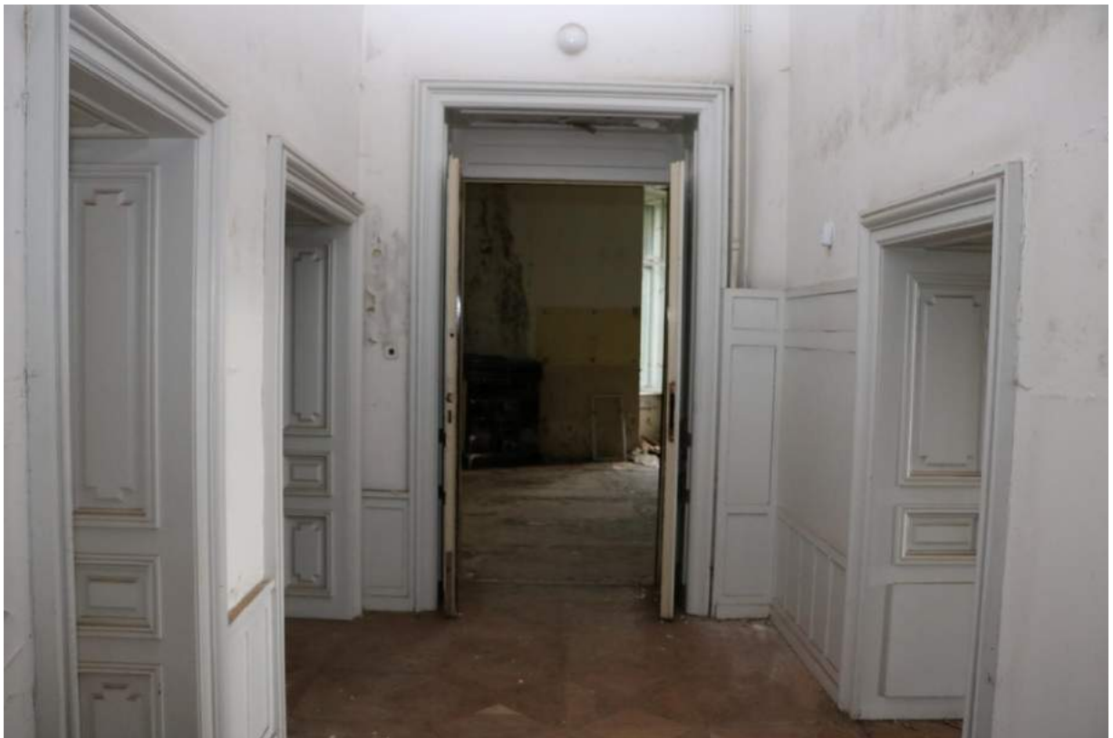
Chodba se vstupy do umývárny, sl.schodiště, arkýř.pokoje, velkého pokoje
