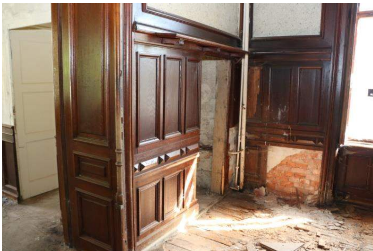
Jídelna - vlevo dvře do velkého kabinetu, vpravo mezi obkladem dveře do malého kabinetu
