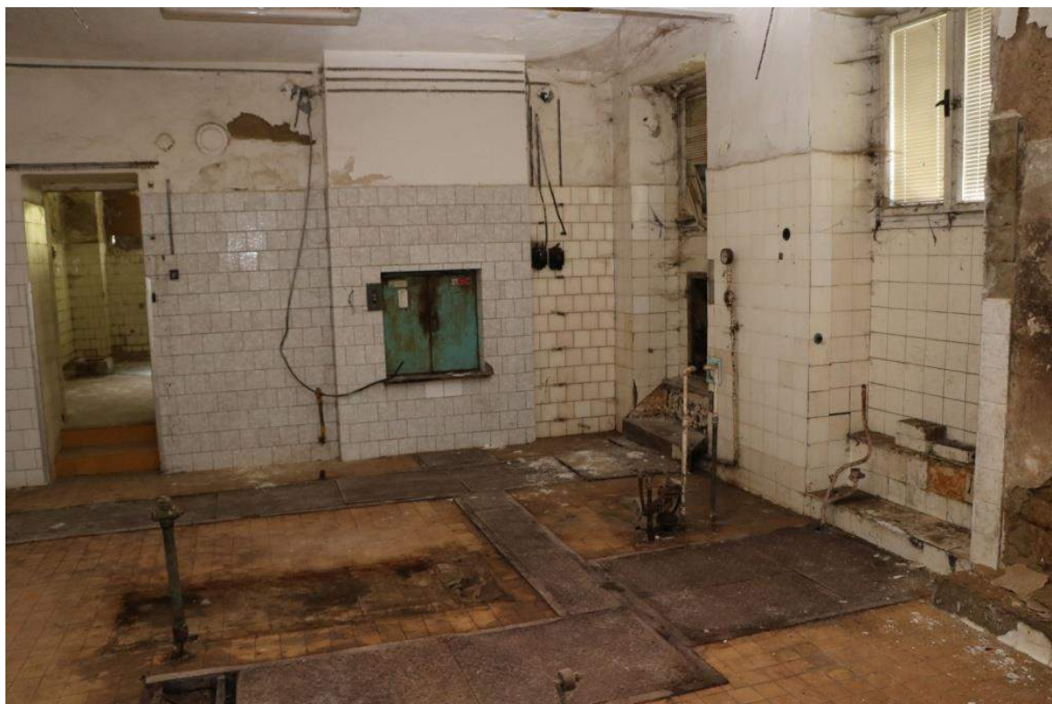
Kuchyň – kanály, vzadu konektor přikrytý plechem, ve zdi výťah na jídlo
