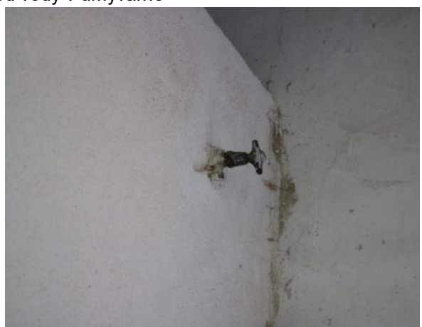
nová voda za přízdívkou v umýárně
