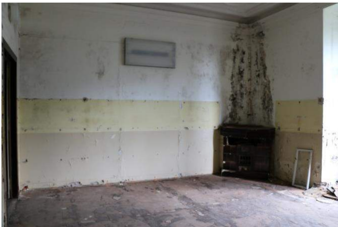
Arkýřový pokoj – jižní stěna , vlevo dveře do chodby
