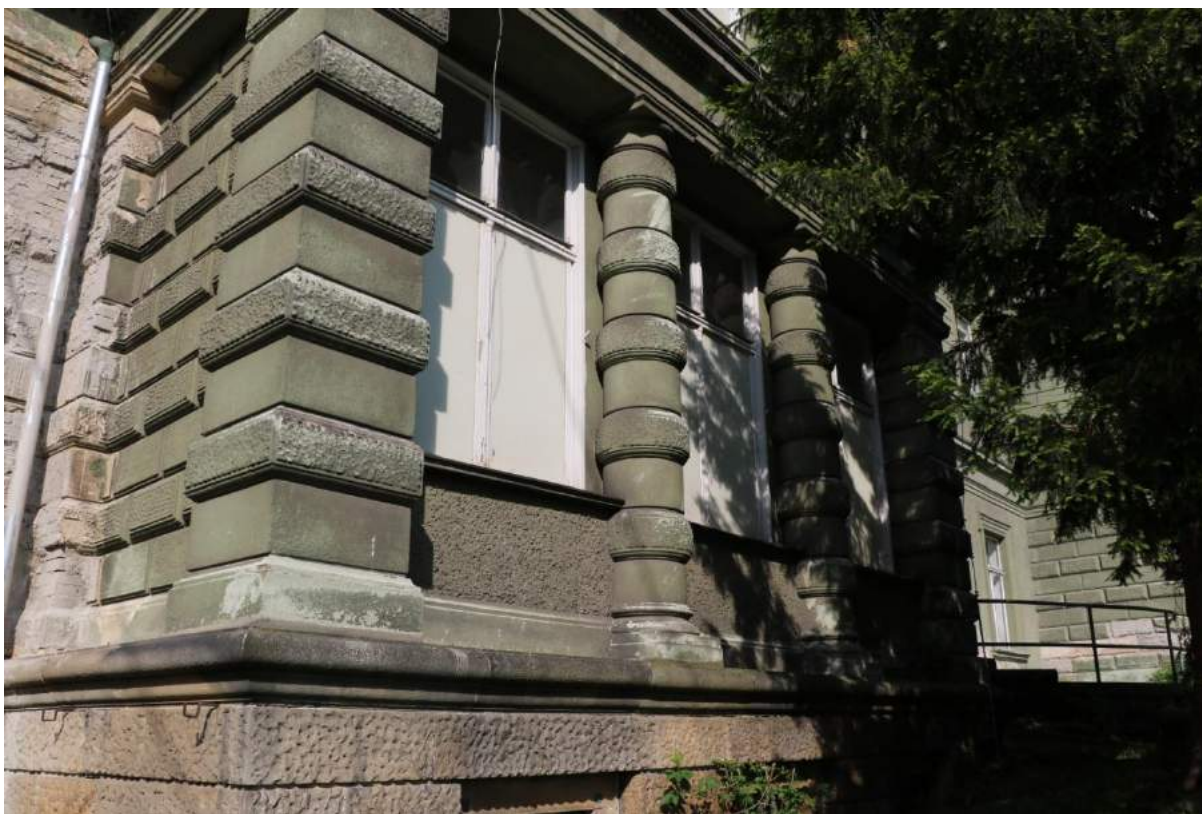
Lodžie - Spodní patro původně sloupové odkryté, dodatečně zazděné a opatřené okny
