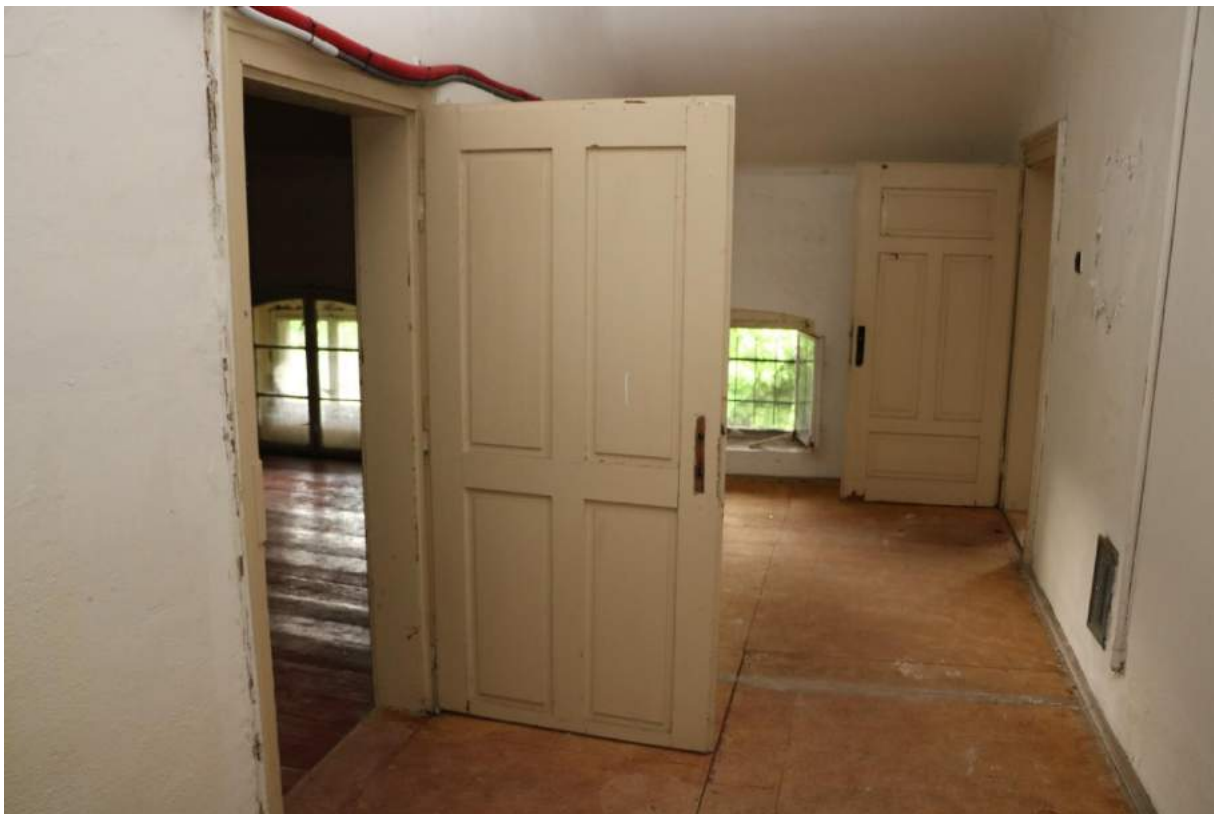
Chodba – vlevo vstup do dvou pokojů na V, vpravo vstup do půdních „kamrlíků“ (J)
