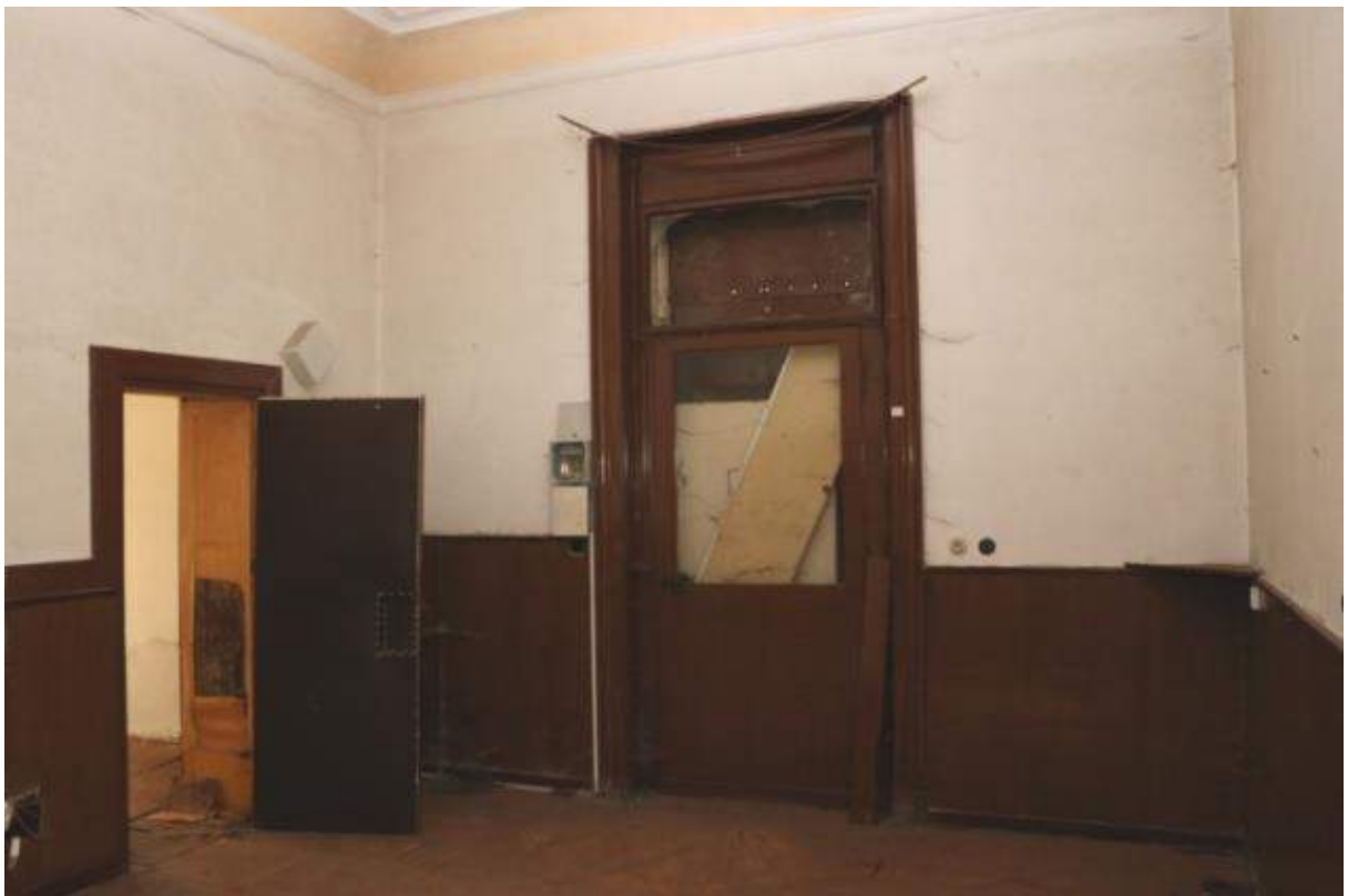
Oblékárna – dveře na terasu a dveře do ložnice
