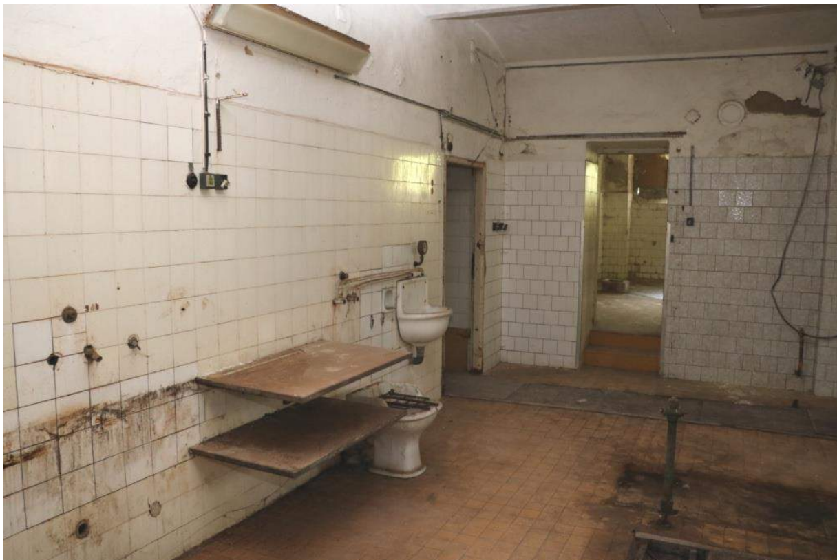
Kuchyň s východem do chodby a do přípravný
