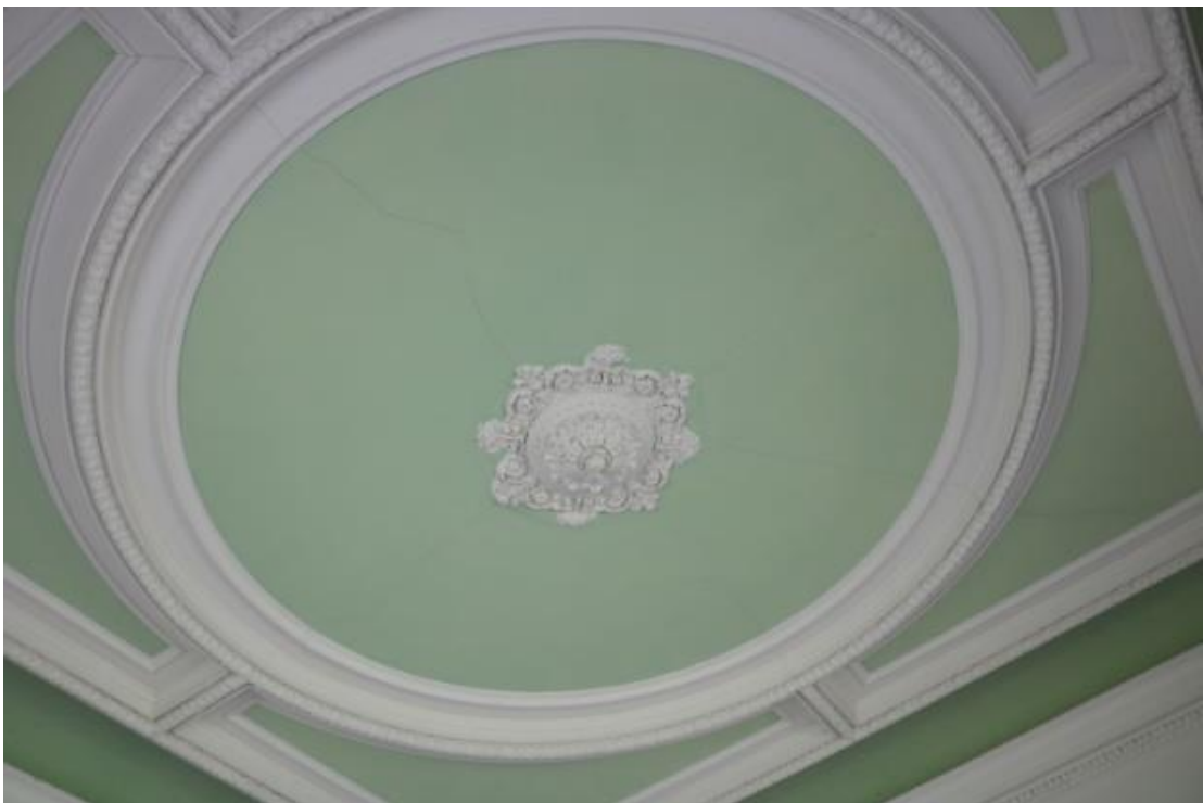
Rohový pokoj – kabinet (V) Štukový strop
