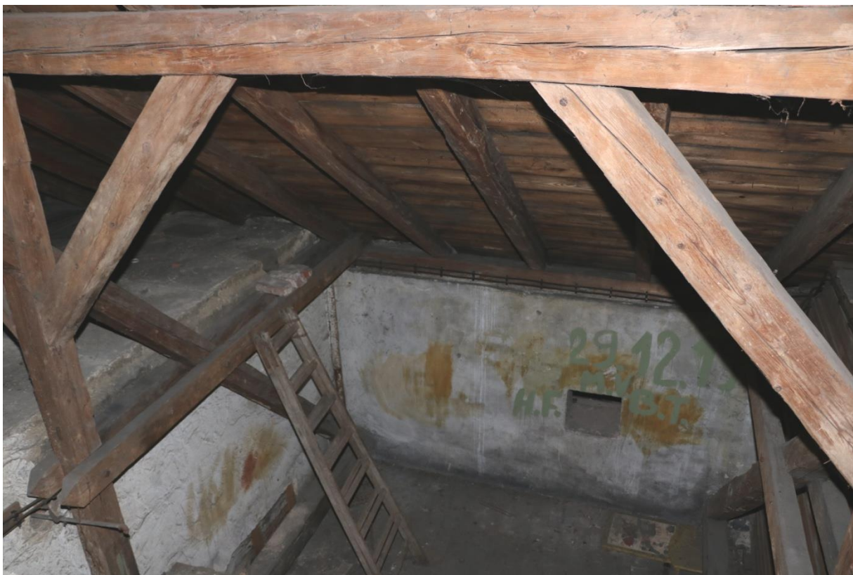
Půda (JZ) s vestavěnou koupennou (vlevo), otvor na půdičku nad balkonem
