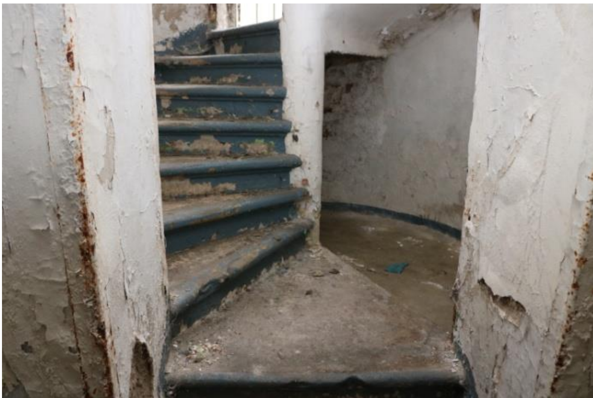
Schody na ssluž.schodiště ze sklepa
