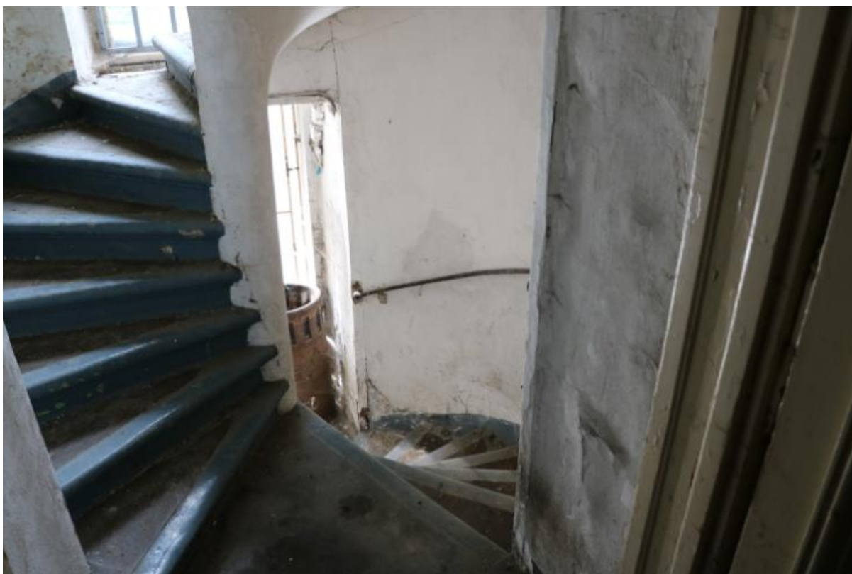
schodiště od dvora k 1.NP a nahoru
