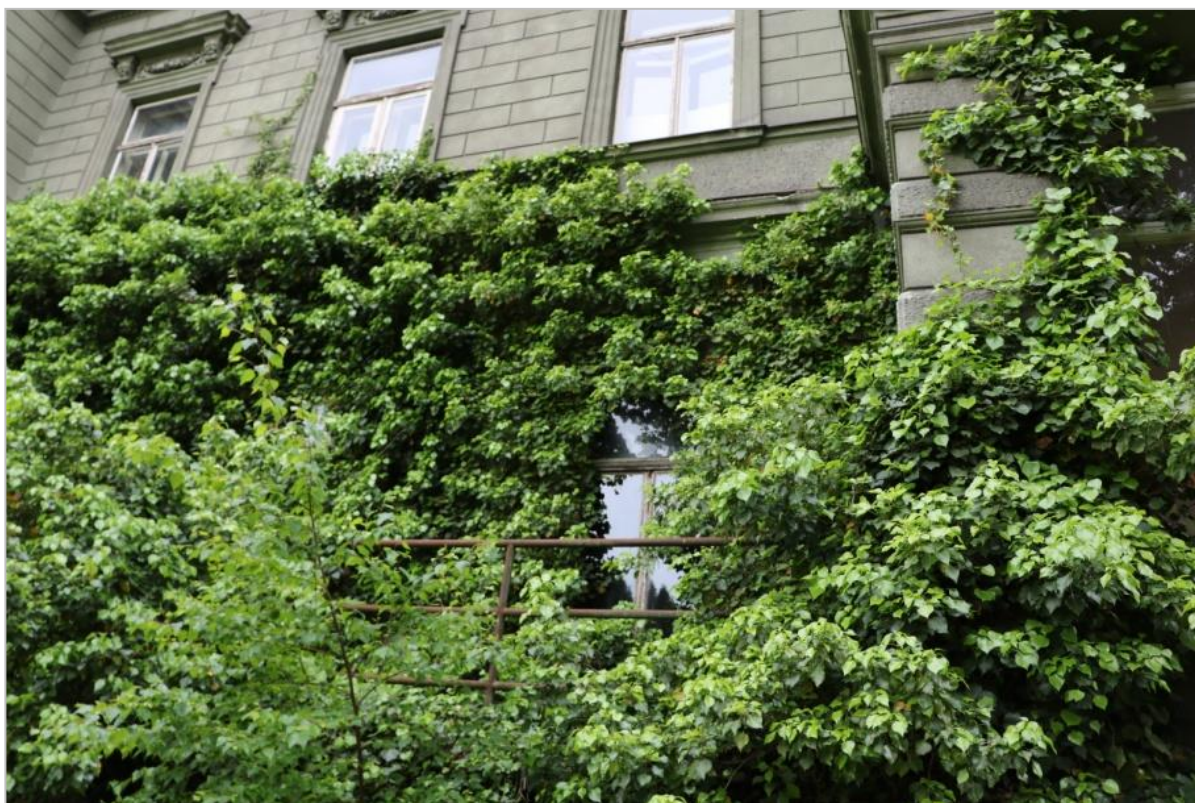
Pod nimi okna a dveře na terasu s novým trubkovým zábradlím
