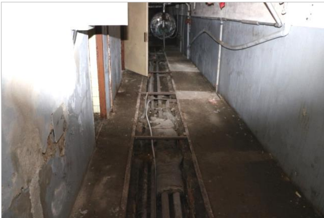
Chodba s kolektorem
