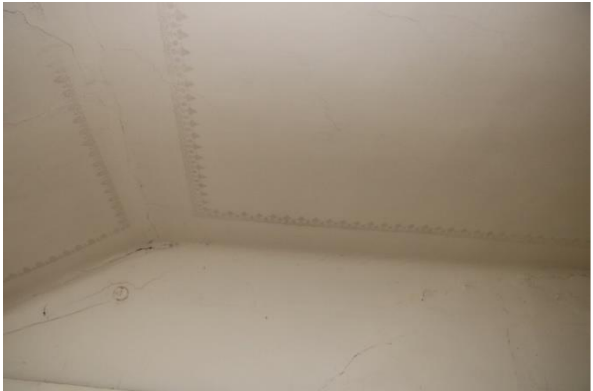
Předpokoj s výmalbou (JV)
