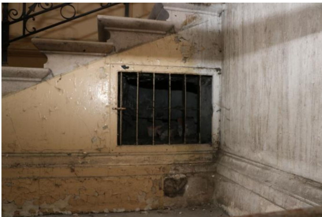
Větrací otvor pod schodištěm
