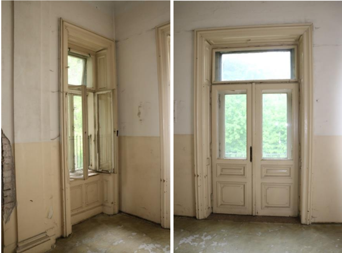
Okno a balkonové dveře osvětlující halu
