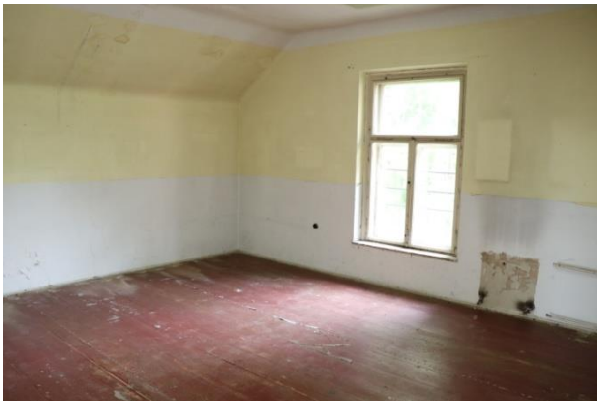
Rohový pokoj (S) - okno do štítu, prkenná podlaha, omítané stěny, původní okno a dveře
