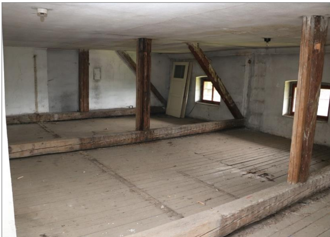
Půda (SV) – prkenná podlaha, odkryté trámy, omítané zdi, jednoduchá okna
