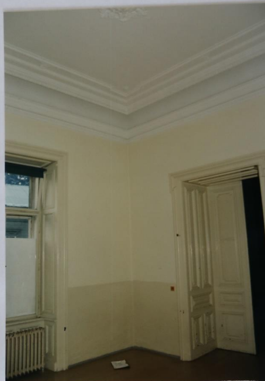
48 - M.Č.210: DVEŘE DO M.Č.211 A JV OKNO
