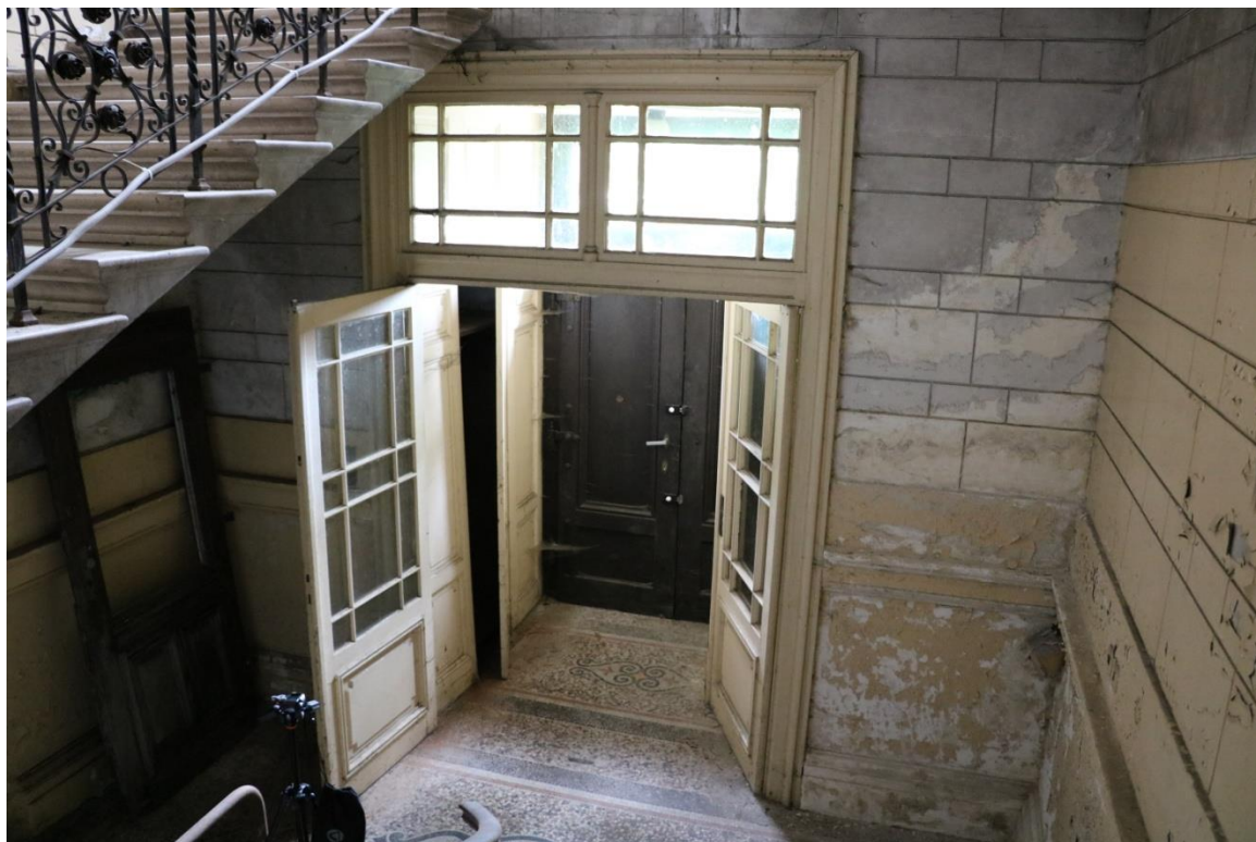
Vstupní prostor – předsíň se šatnami po stranách, prosklené dveře s nadsvětlíkem, teracová a mozaiková podlaha
