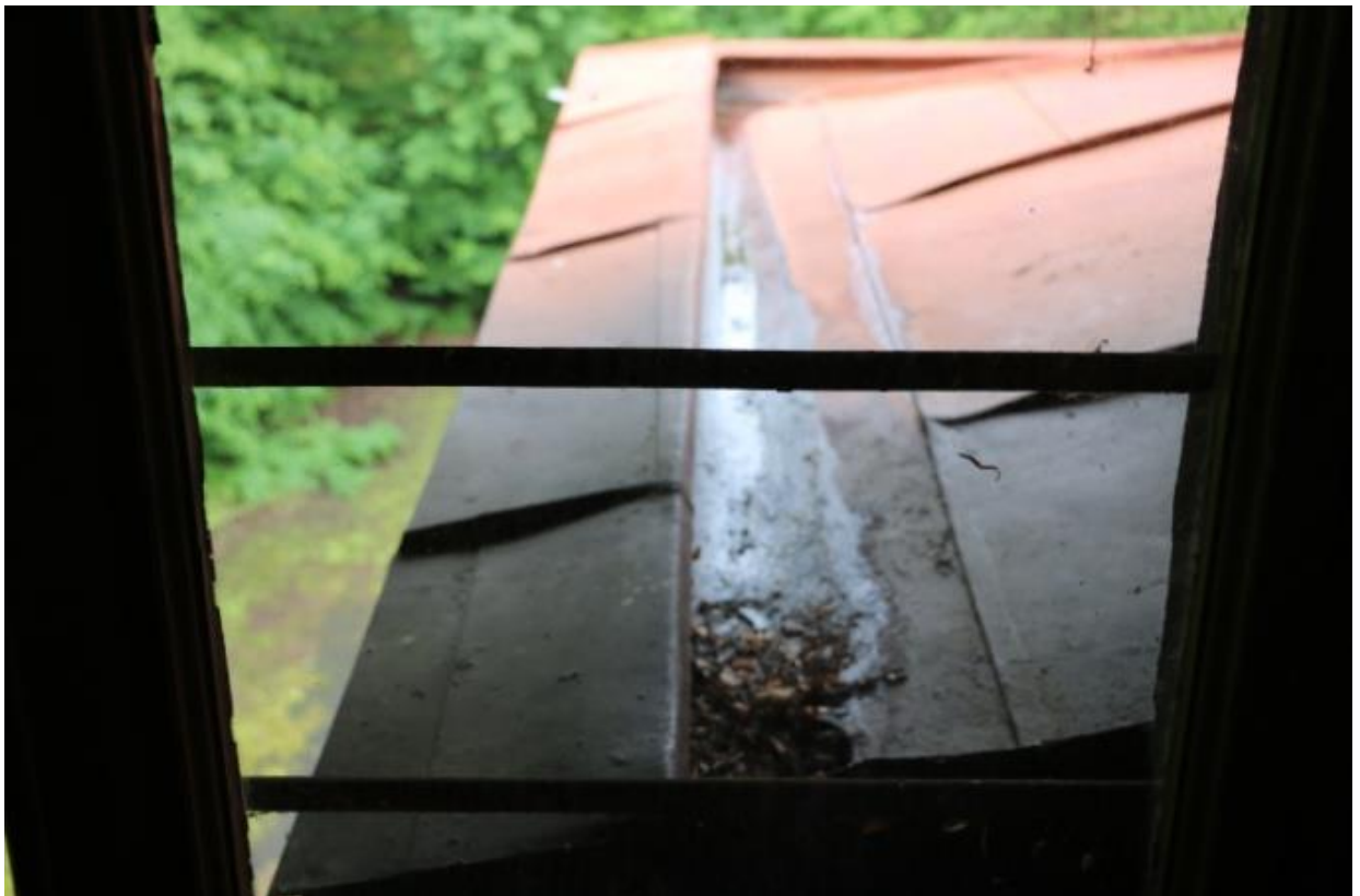
Překrytí okapových žlabů plechem
