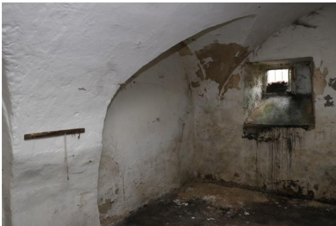
Malá společenská místnost (SZ) - částečně zazděné okno
