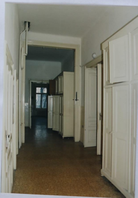
39 - M.Č.202: SZ STĚNA
