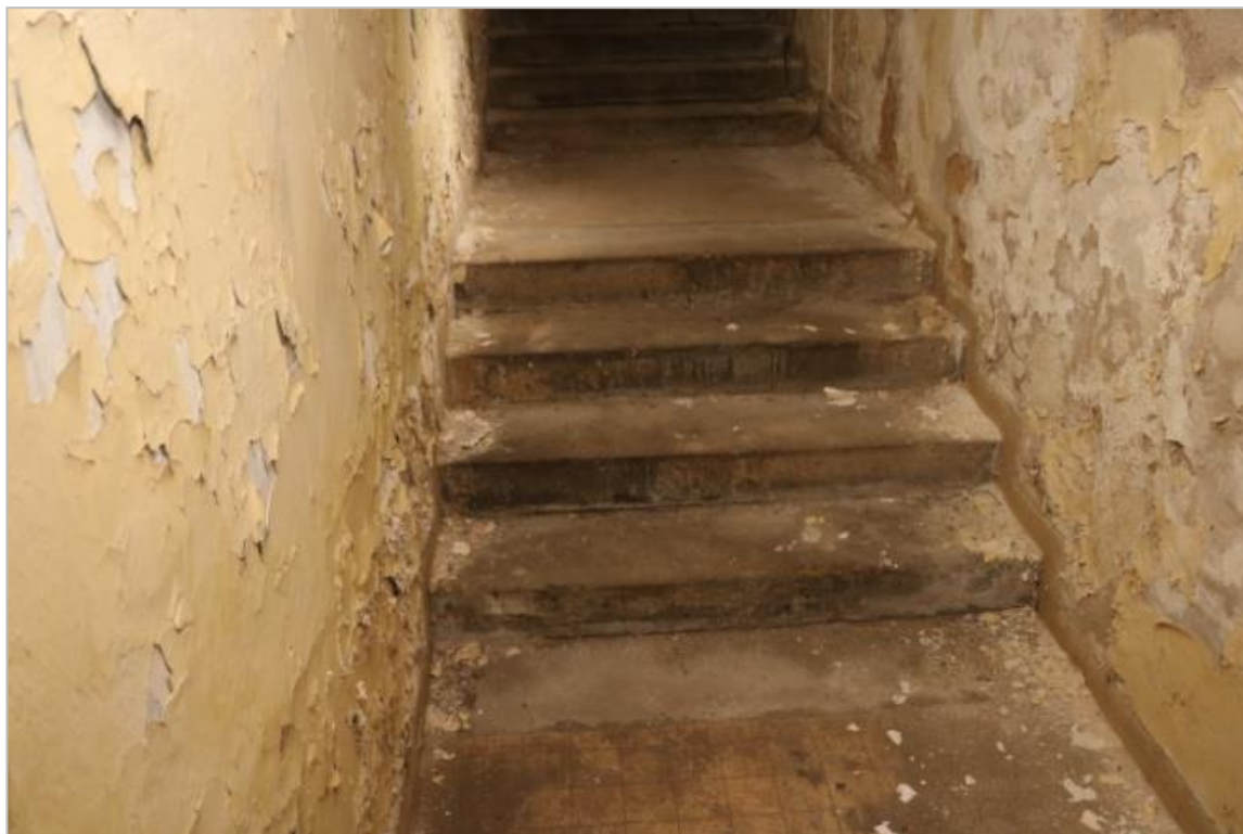
zahradní schodiště – betonové schody
