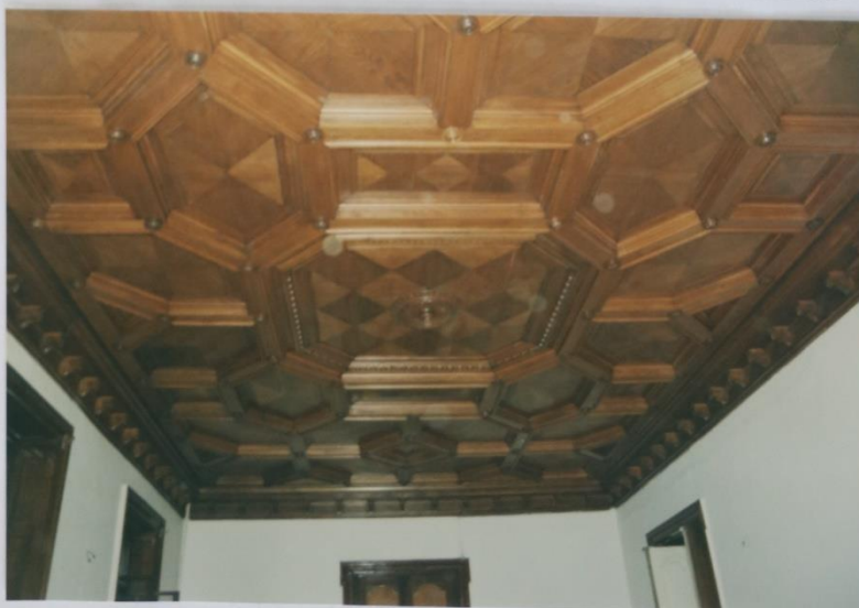
20 - M.Č.113: STROP NAD JV STĚNOU
