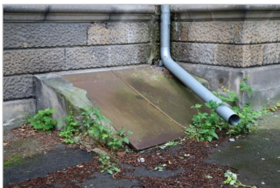
vlevo od vstupu - shoz na uhlí
