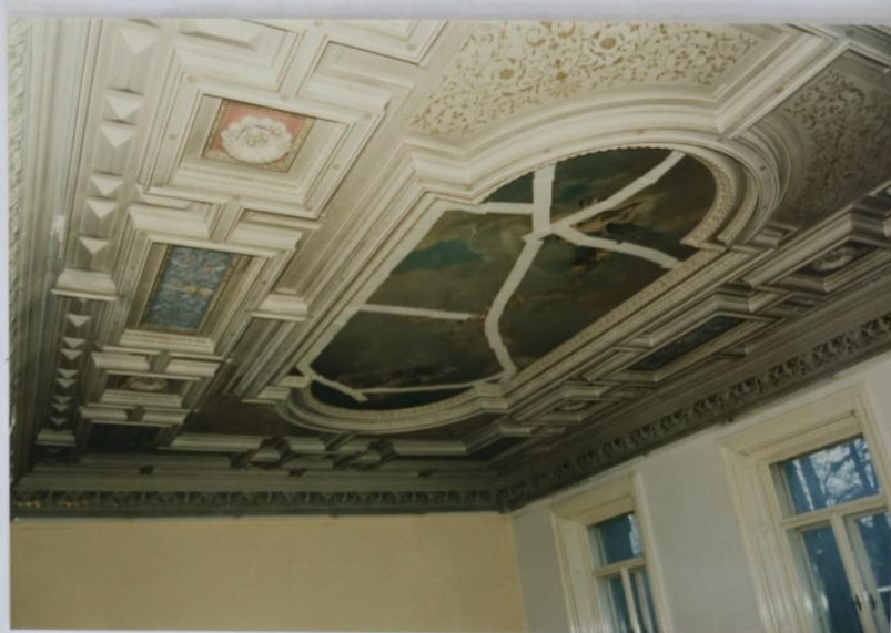
13 - M.Č.112: STROP NAD JZ STĚNOU
