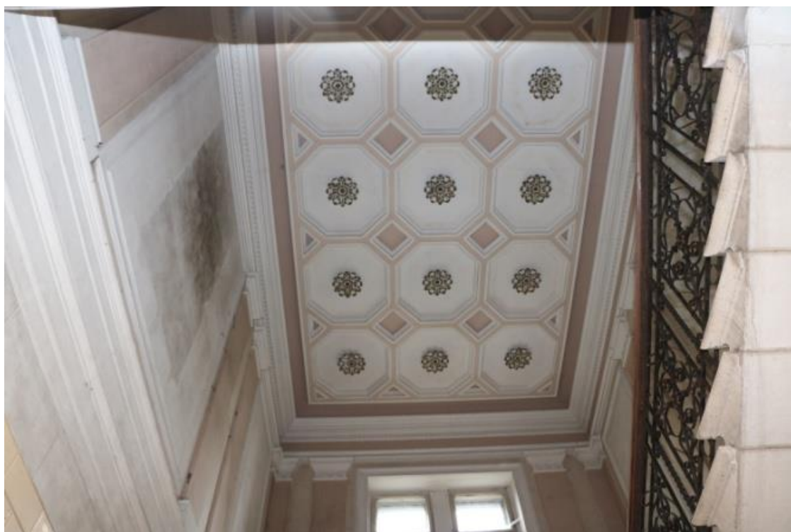
Strop nad schodištěm
