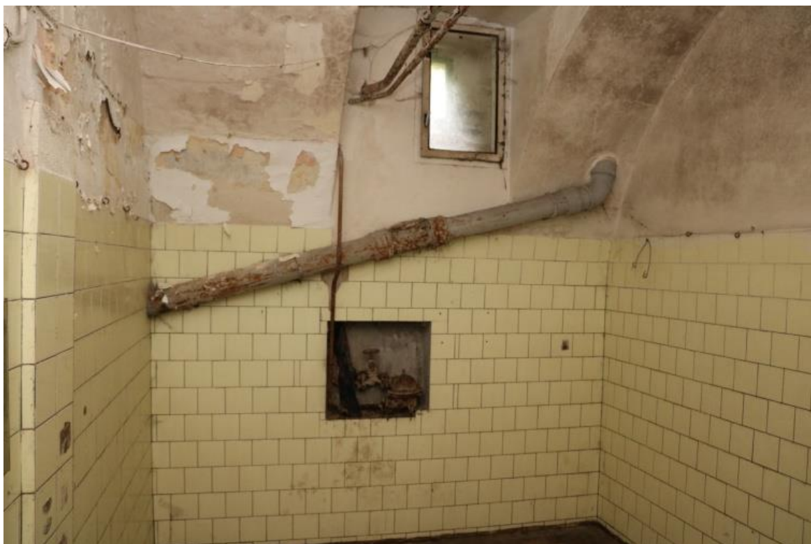
Komora vedle chodby u JZ
