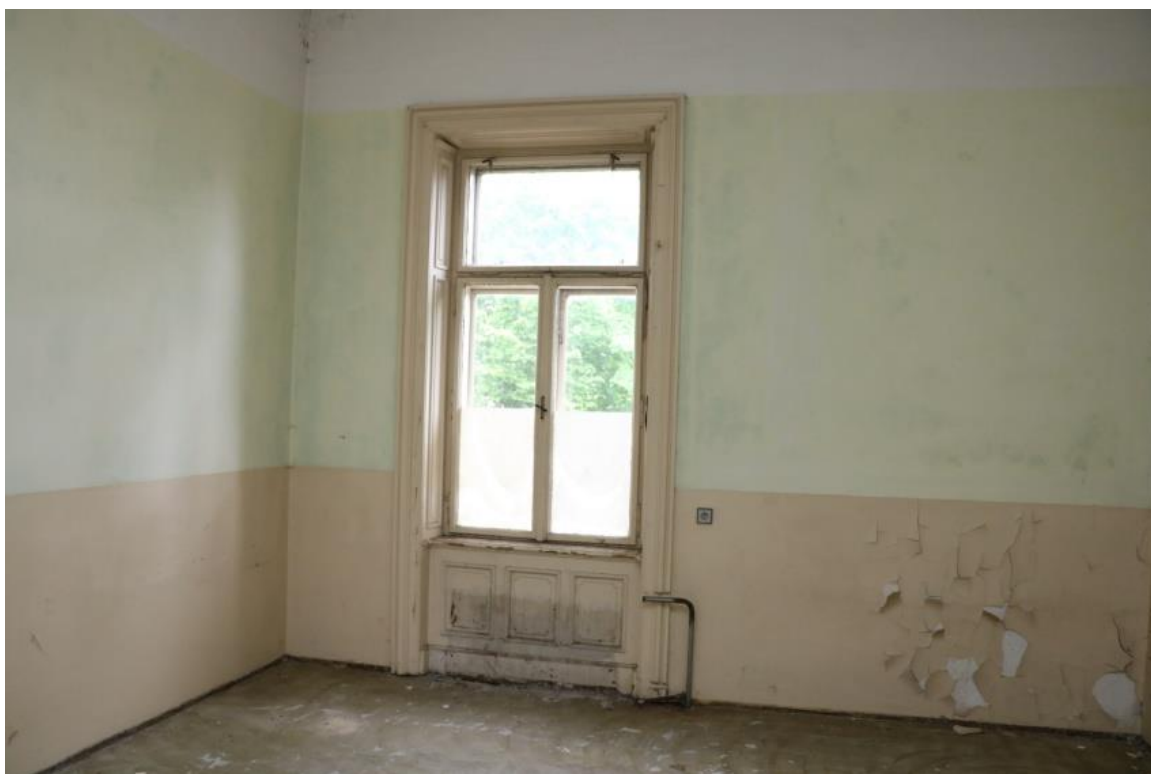
Přístavba – 1.místnost okno s obložkami a parapetem
