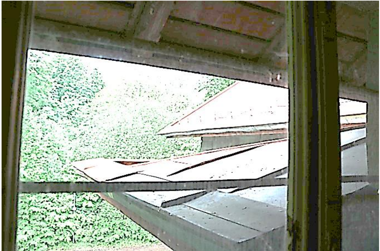
Střecha – plech, původně břidlice a plech po okrajích
