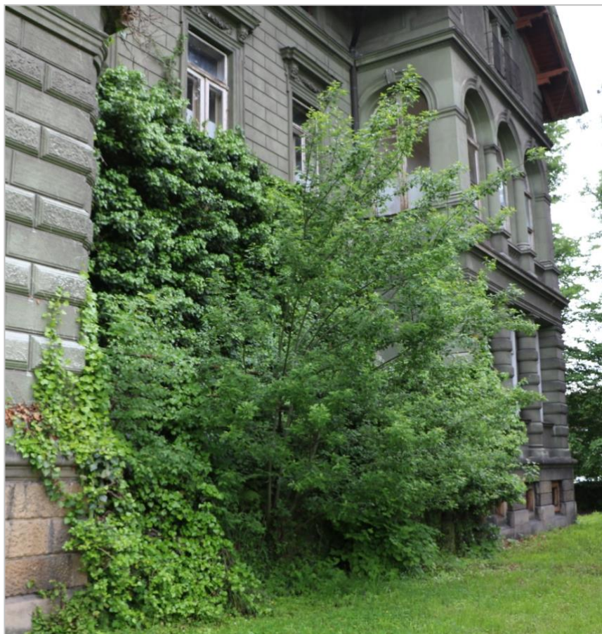
Okna a balkonové dveře ve 2.NP směřovaly na balkon, odstraněný ve 2.pol.20.století
