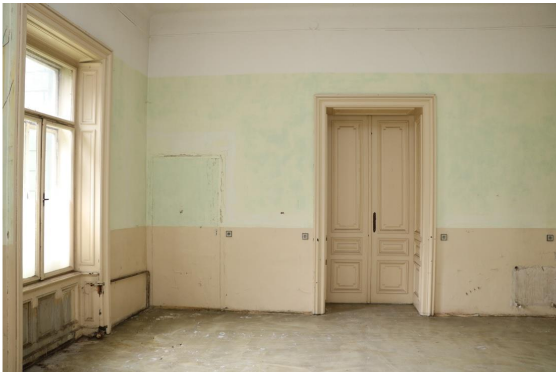
Velký pokoj nad terasou - zazděné malé dveře do tělocvičny, nepožívané dveře do arkýřového pokoje
