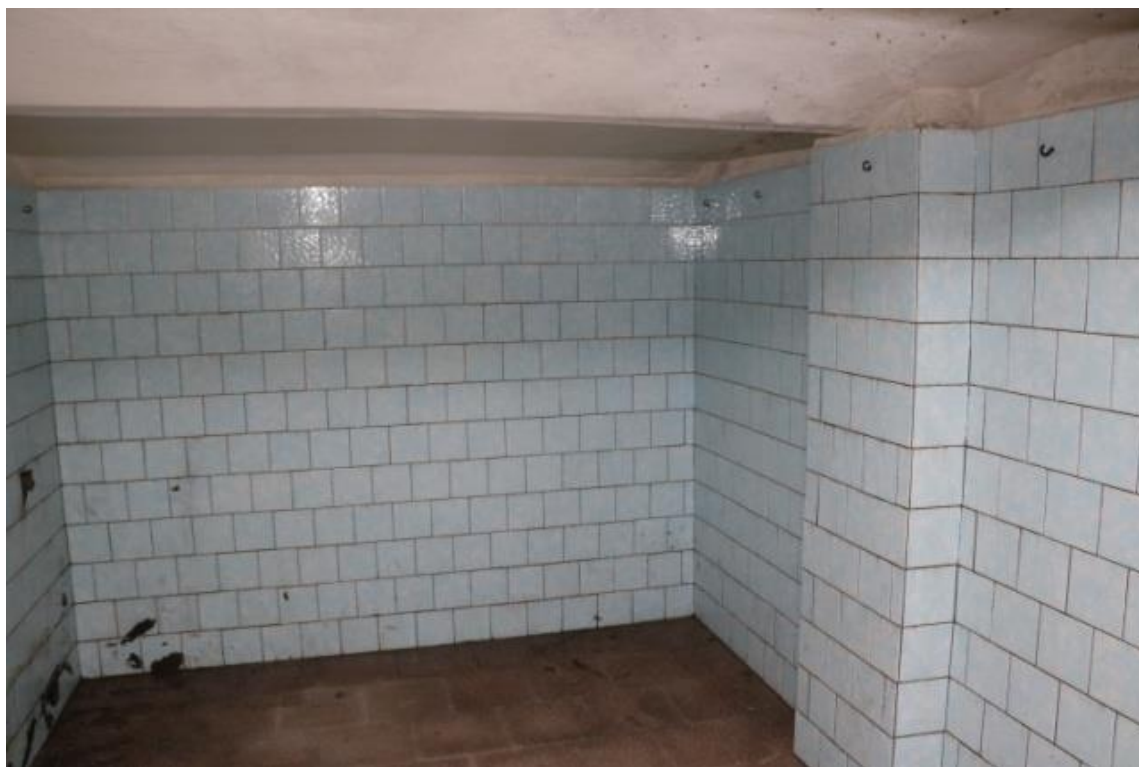
Prostor pod hlavním schodištěm – nové kachličky
