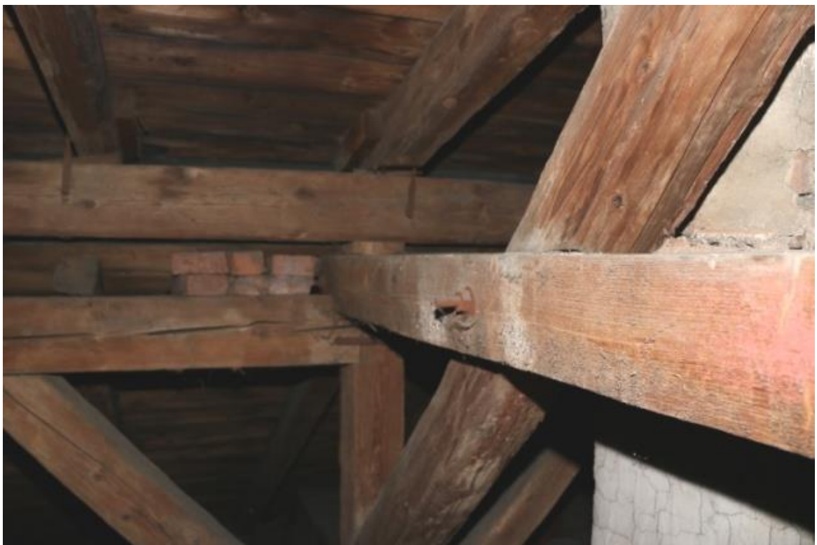
Krov – pozednice, krokve
