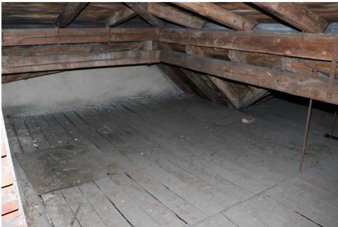
Krov – pozednice, krokve
