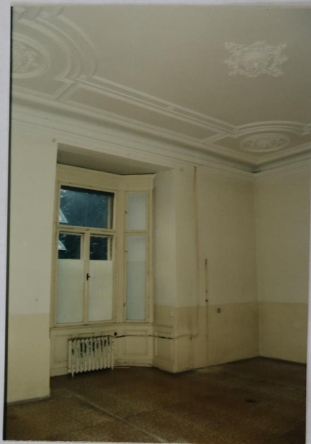
50 - M.Č.211: JV OKNO
