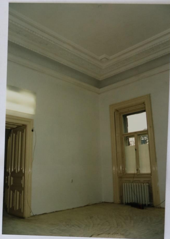
26 - M.Č.116: JV OKNO
