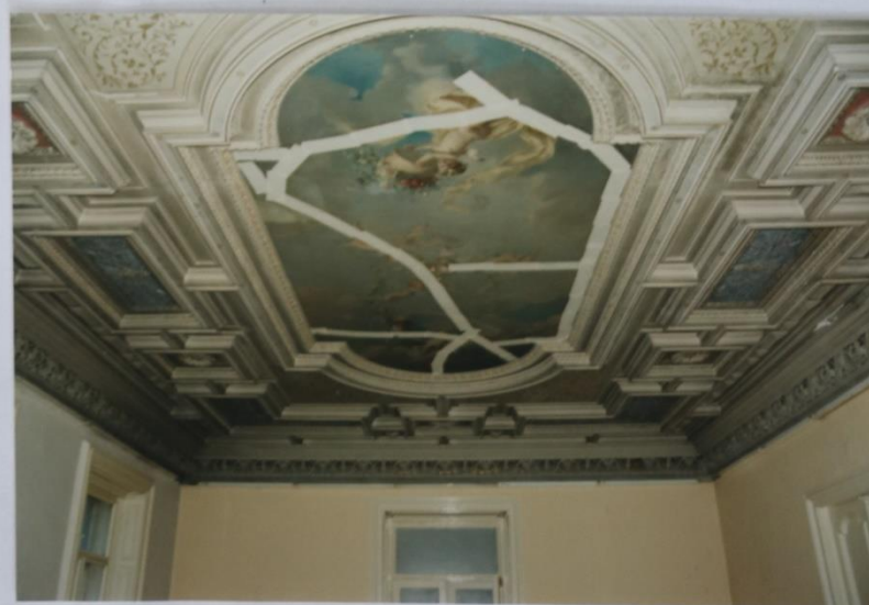
14 - M.Č.112: STROP NAD SV STĚNOU
