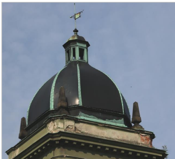
báň s lucernou a korouhví, atika a kamenné jehlany na podstavcích
