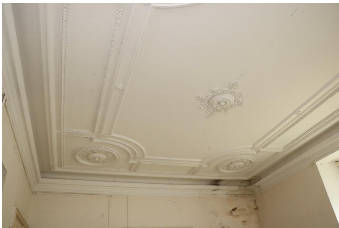
Arkýřový pokoj – výzdoba stropu
