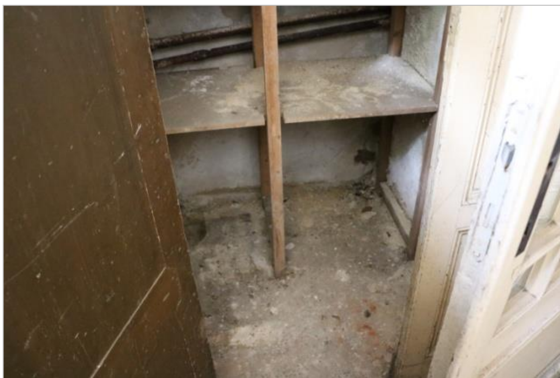
Šatna - nové police a rozvody vody, topení, kanalizace
