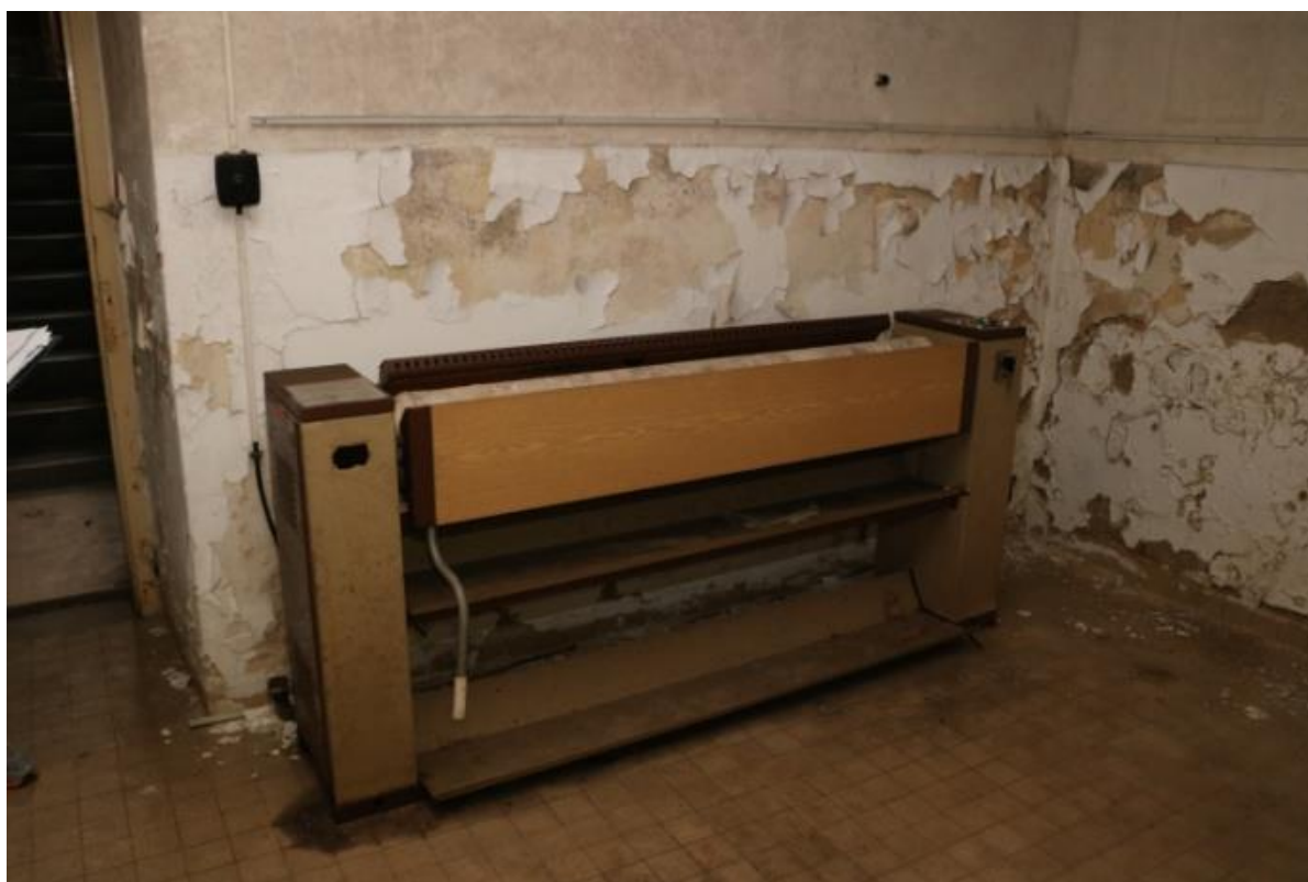
Místnost – mandlovna naproti teracovému schodišti – vstupní dveře, nová dlažba
