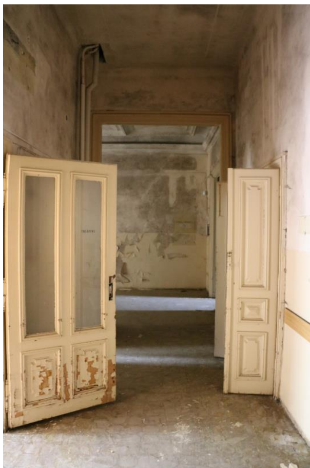
Hala – chodba, oddělená dře.portálem – vpravo vestavěné skříně, vlevo dveře do umývárny a záchodů
