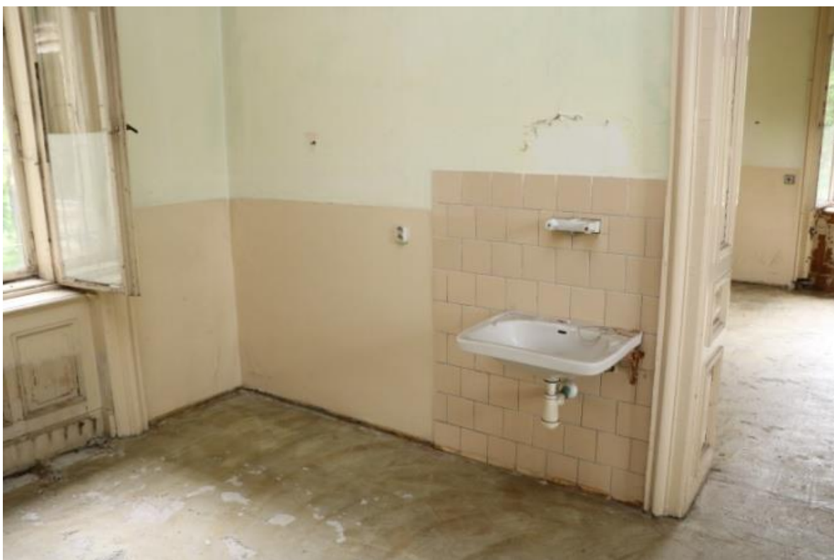
Přístavba – první místnost (u schodiště) - betonové podlahy, nové umyvadlo, dveře do 2.pokoje
