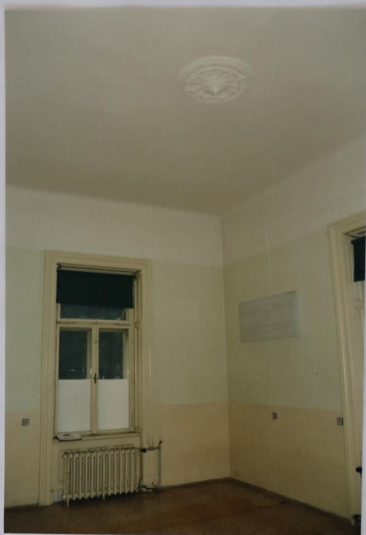
40 - M.Č.203: JV OKNO
