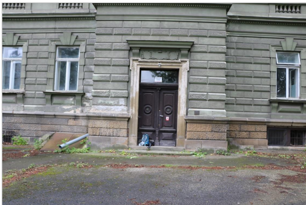
Rizalit hlavního vstupu, členění a zdobené fasády a šambrán nové okno ve štítu asfaltový povrch až k objektu, dešťové vody svedeny na dvůr
