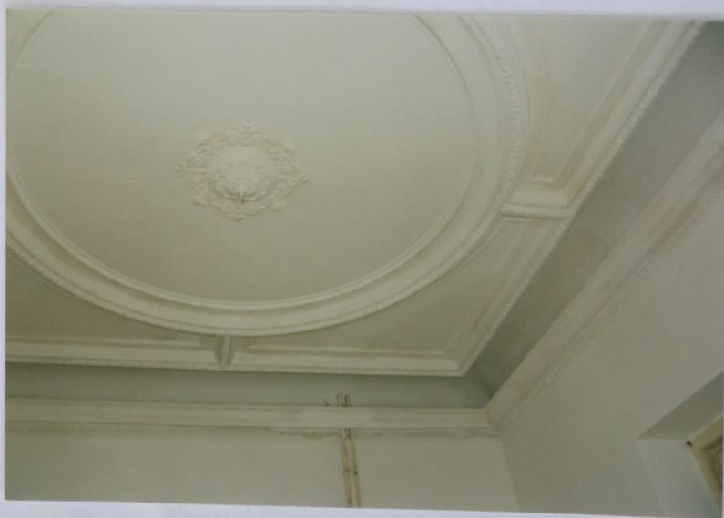
24 - M.Č.115: STROP NAD SV STĚNOU
