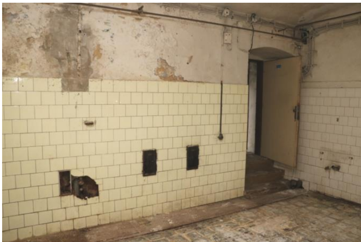
Jižní rohová místnost – dvířka do komínu, dveře po schodech od sl.schodiště
