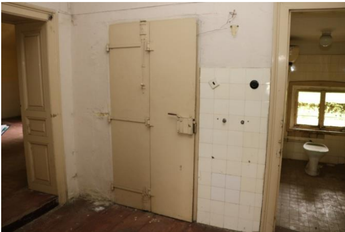
Protipožární dveře na půdu, skládací, krabicový zámek
