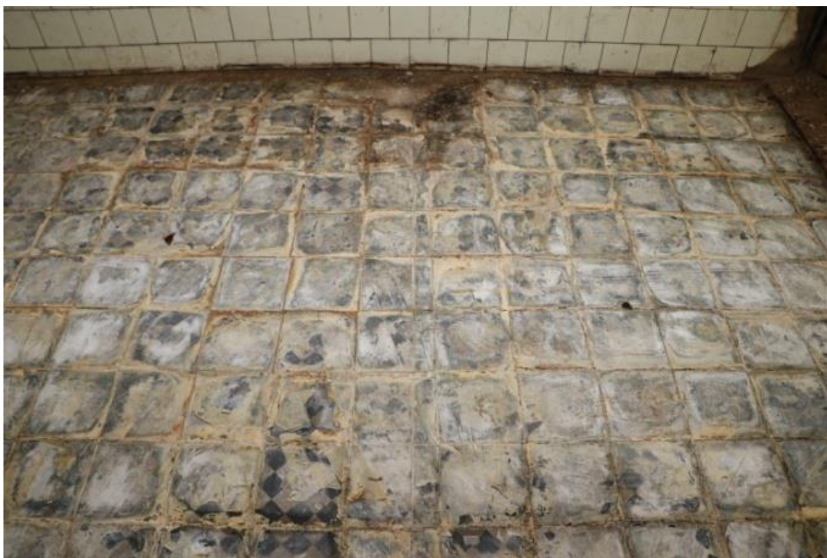
Jižní rohová místnost s původní dlažbou z poč.20.století
