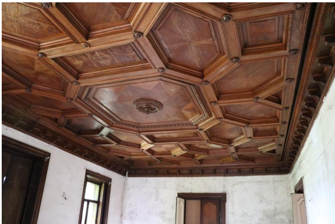
Jídelna – okenice na oknech a dveřích, kazetový strop
