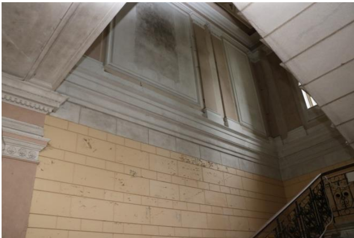
Mramorové obklady schodiště
