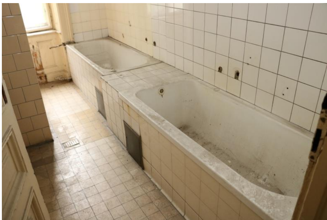
Koupelna vedle služ.schodiště s původní vanou ( v popředí)
