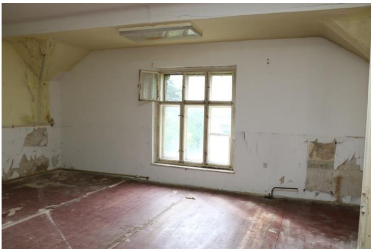
Prostřední pokoj – okno do štítu (SZ), prkenná podlaha, omítané stěny, původní okno a dveře
