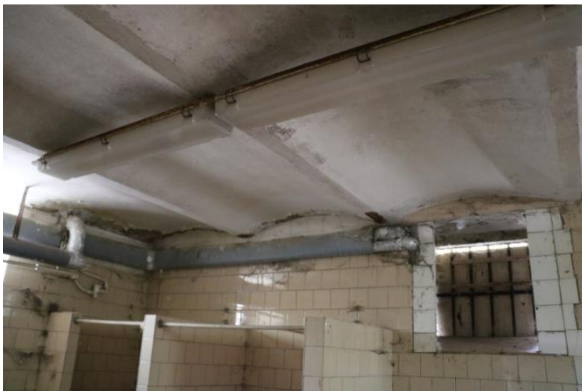
Přístavba – koupelna stropy a rozvody
