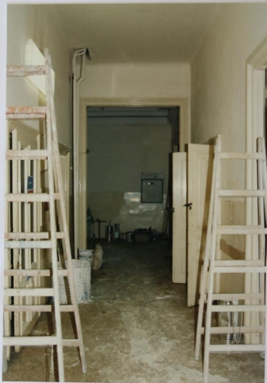
07 - M.Č.103: SZ STĚNA
