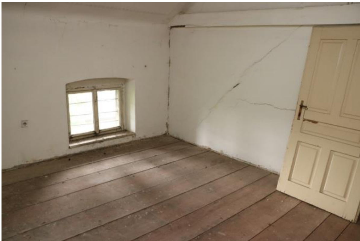
Předpokoj – prkenná podlaha, podkrovní okno, dveře z chodby
