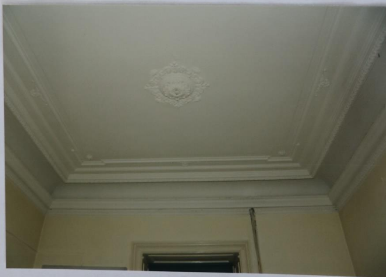
49 - M.Č.210: STROP NAD SV STĚNOU
