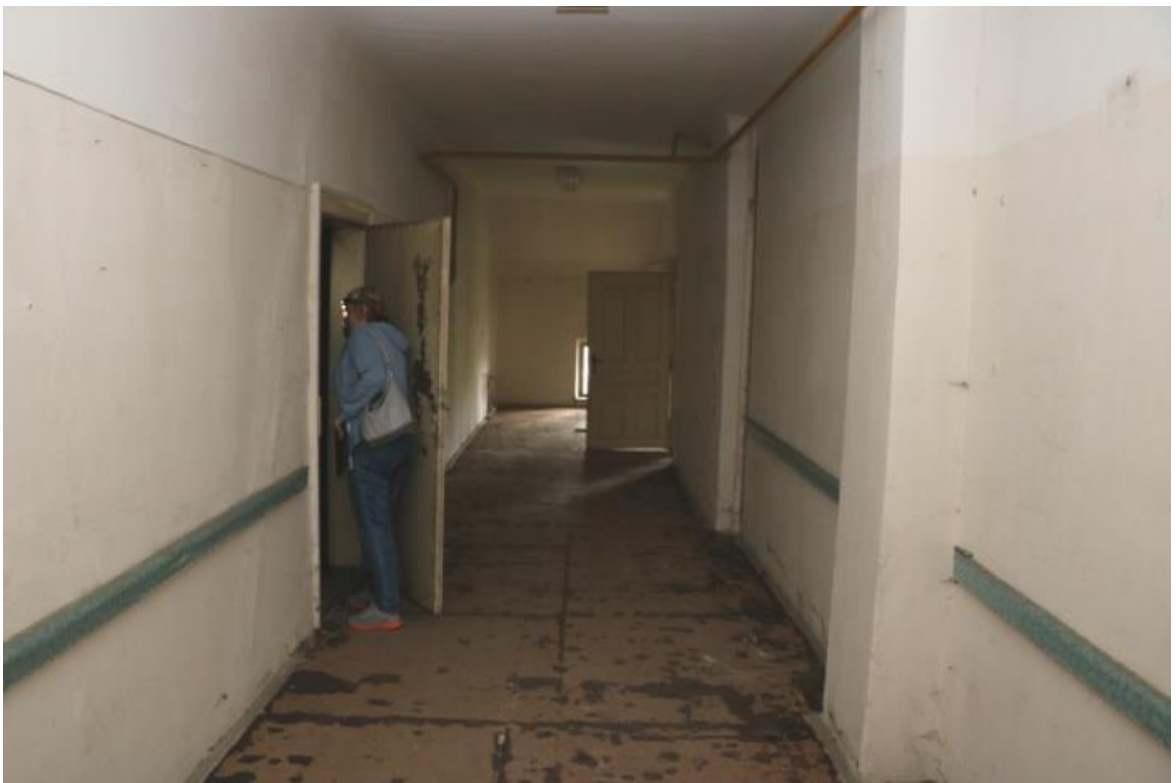
půdní chodba se vstupem na půdu (JZ)
