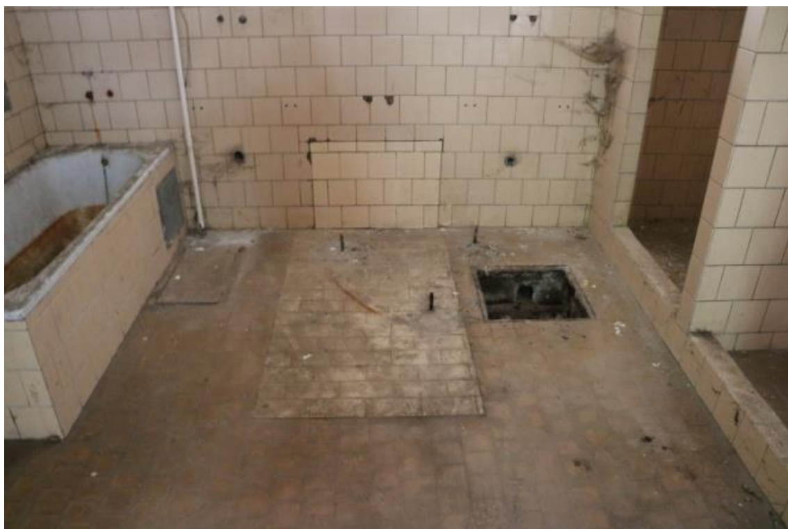
Přístavba – nová dlažba a obklady
