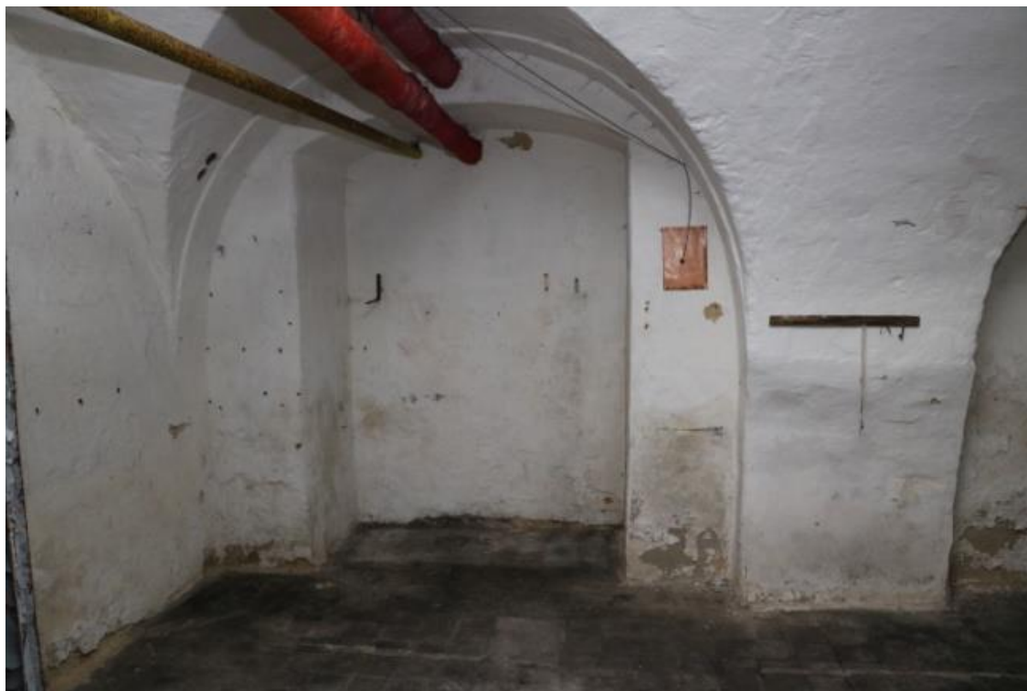
Malá společenská místnost (SZ) – zbytky původní dlažby, rozvody; zazděné dveře
