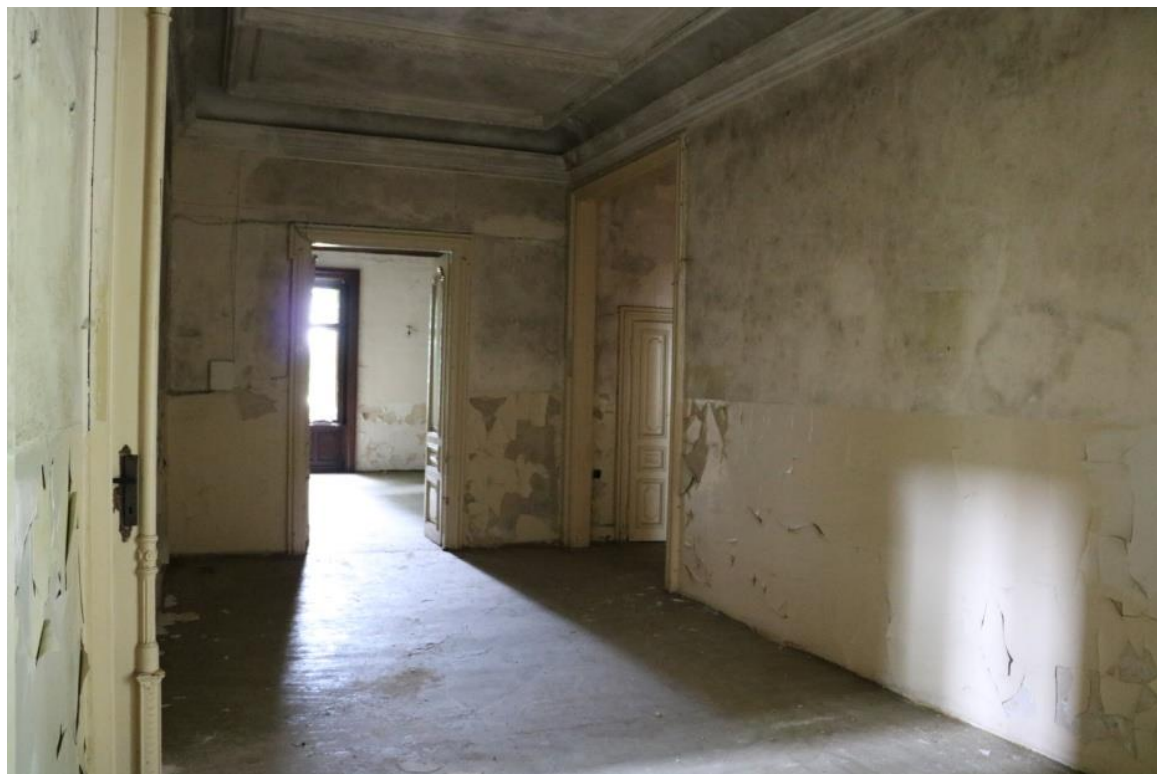
hala – vstup do jídelny a průchod do další části haly
