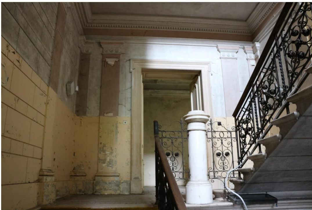
Podesta 1.NP – schodiště se sloupkem,
