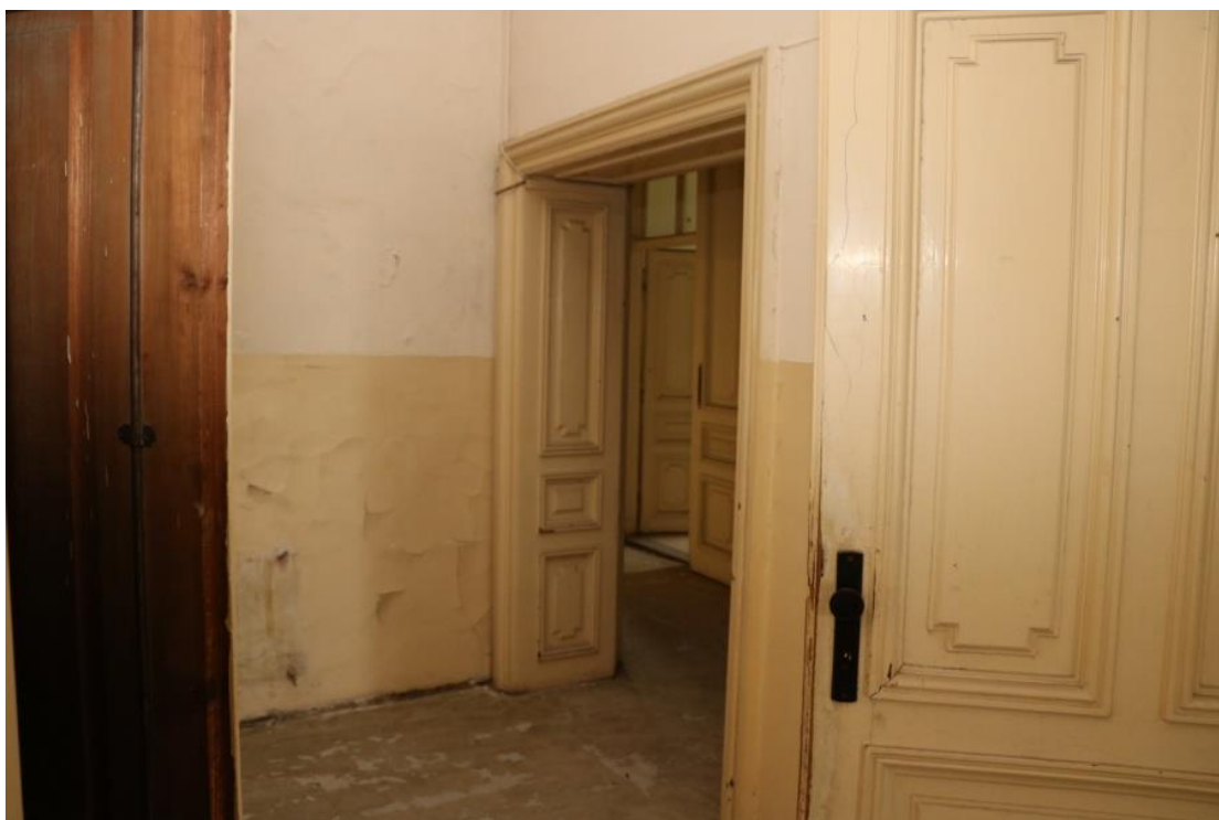
Hala (chodba) zazděné dveře na konci
