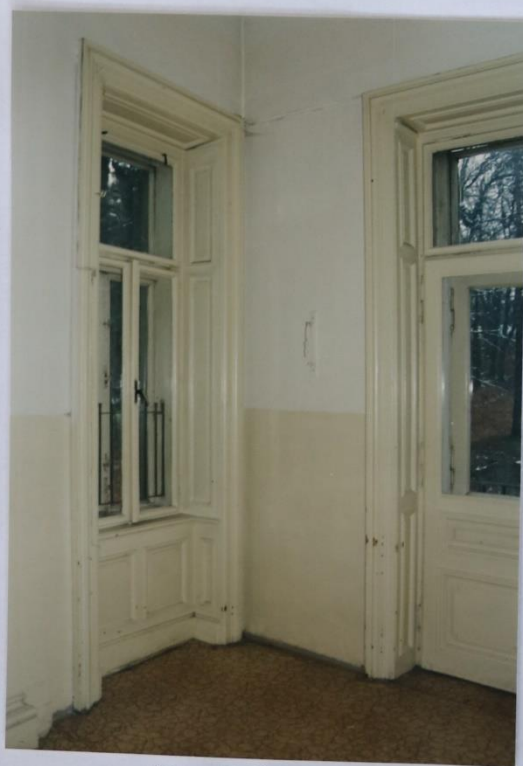
38 - M.Č.202: JV + JZ OKNO
