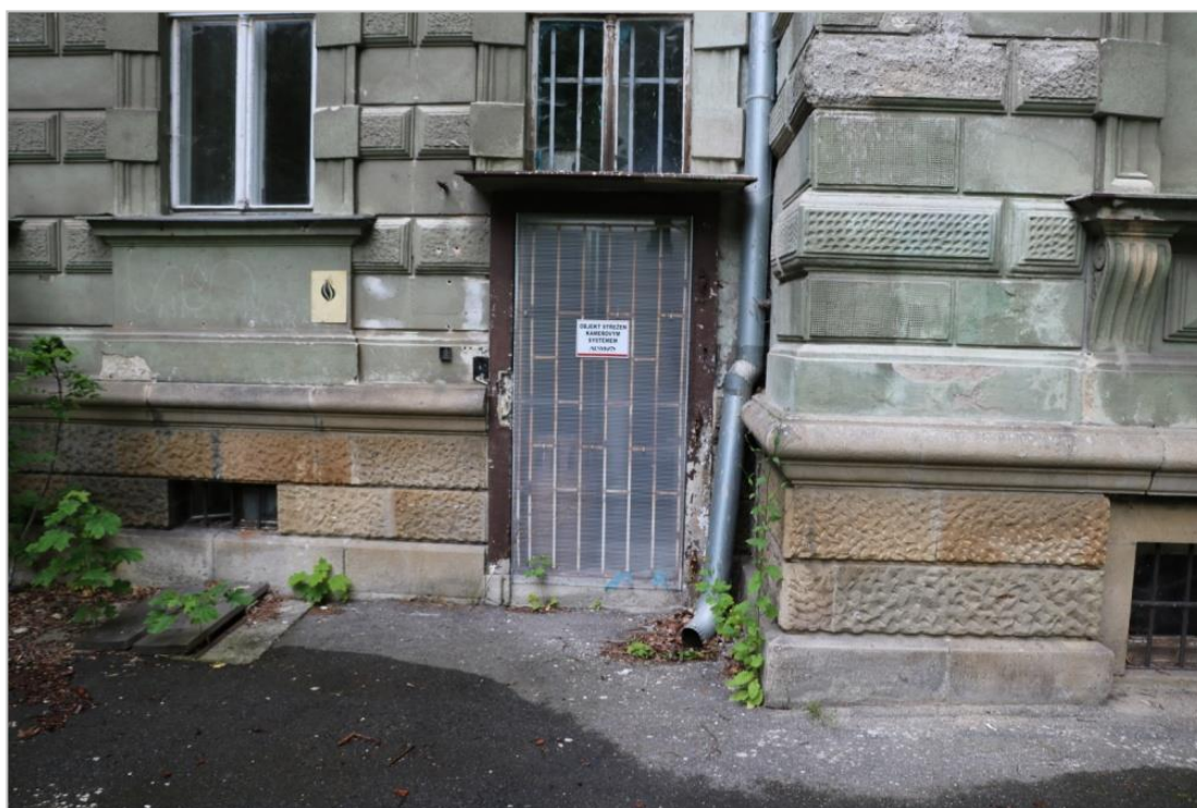
Mříž místo dveří na služební schodiště ze dvora
