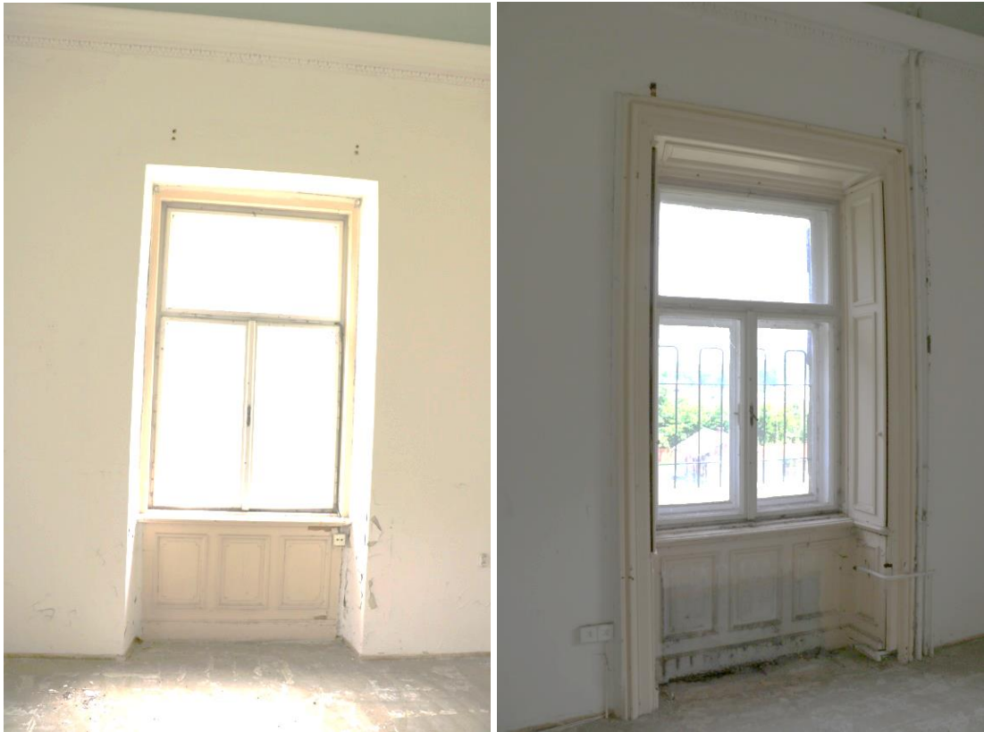
Rohový pokoj (V) tělocvična – okna do dvou stran, betonová podlahy
