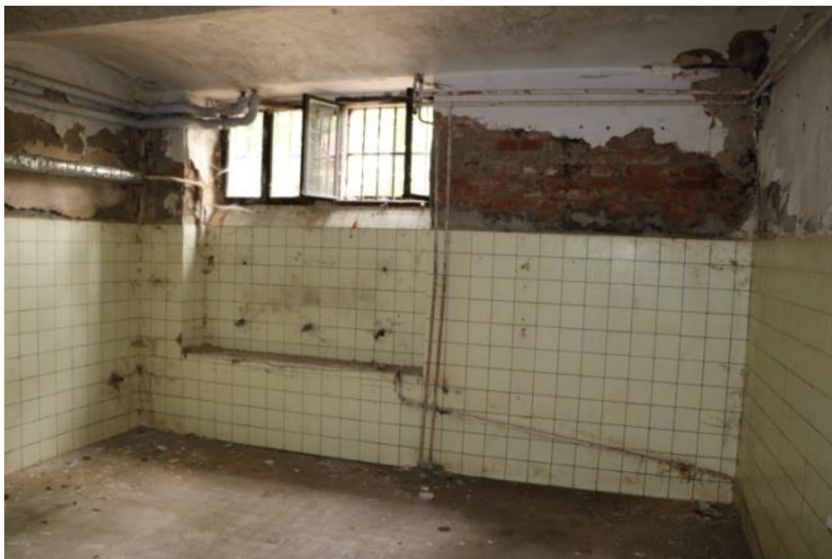
Přístavb šatna – původní okna, nové rozvody
