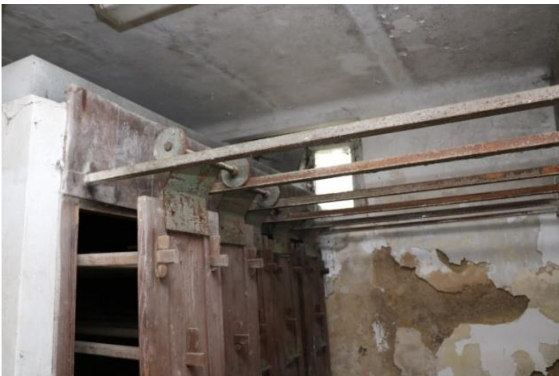
Sušárna – posuvné zařízení na sušení prádla
