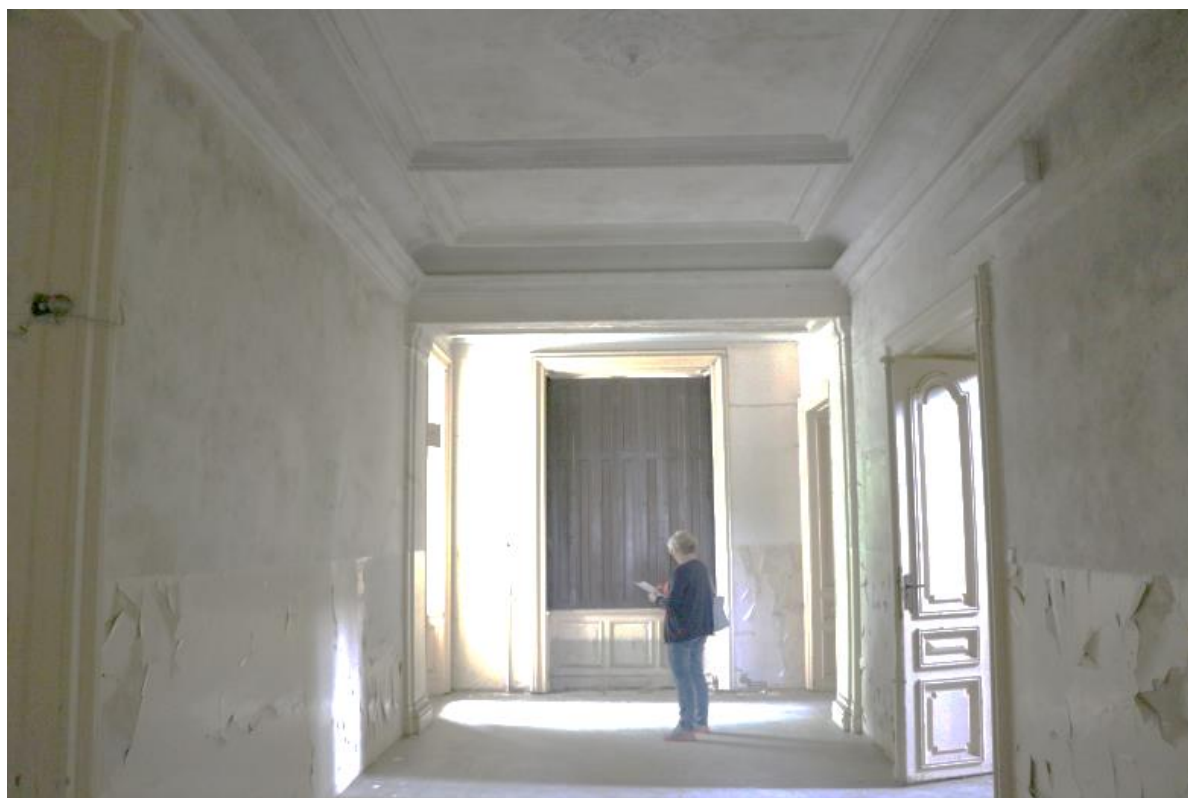
Hala – vpravo hlavní vstup, za překladem přístavba
