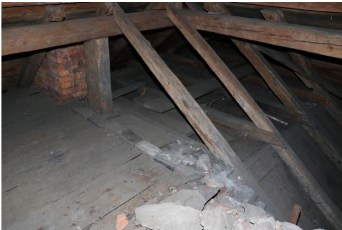
Krov – krokve, bednění chodby, cihlový komín
