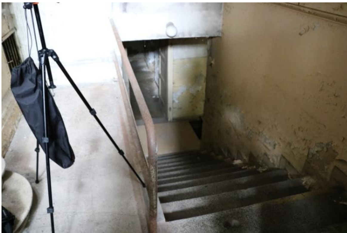
Teracové schodiště do 1.PP z konce 20.let 20.století, trubkové zábradlí z 50.let 20.století
