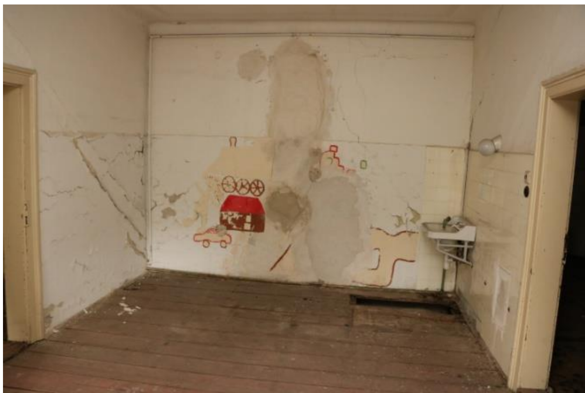
Předpokoj – vlevo dvře do pokoje, vpravo dveře z chodby, umyvadlo
