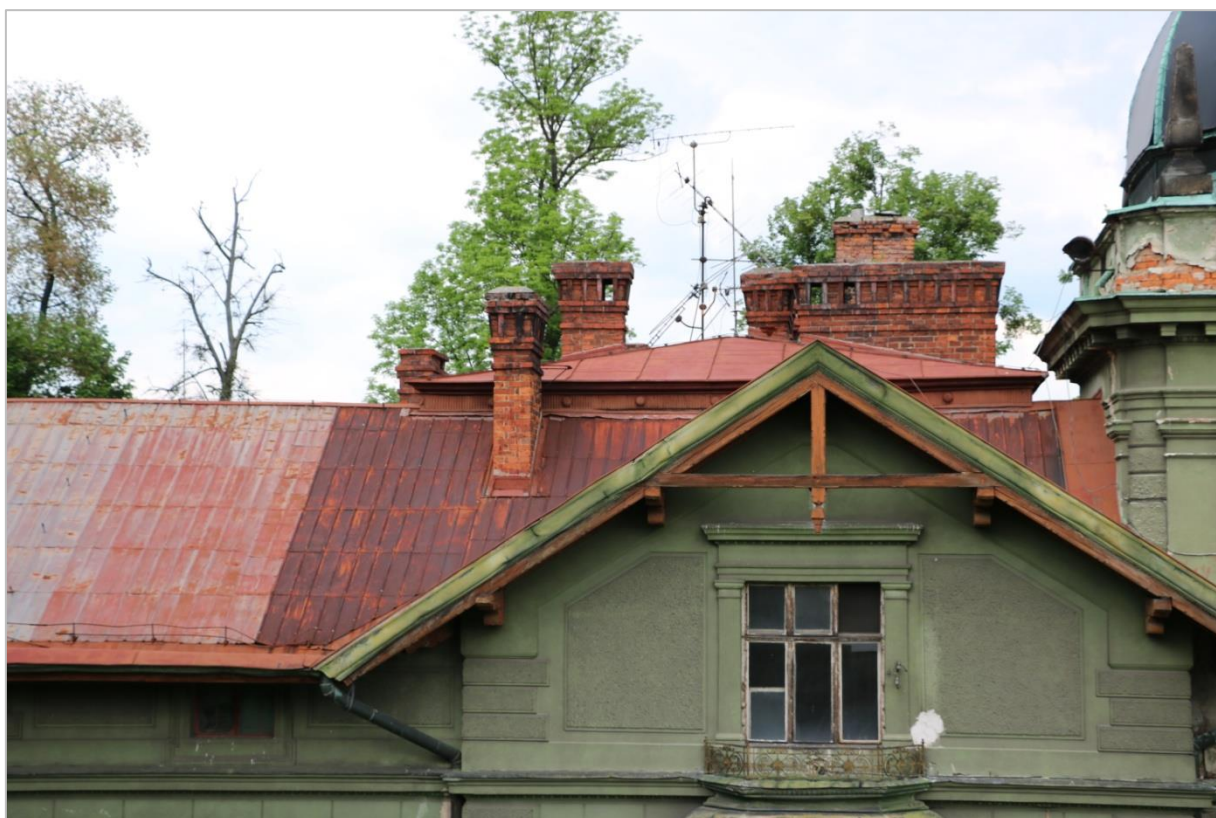
Ztvárnění a výzdoba štítů s podbitím, plechová střešní krytina a režné komínové hlavy
