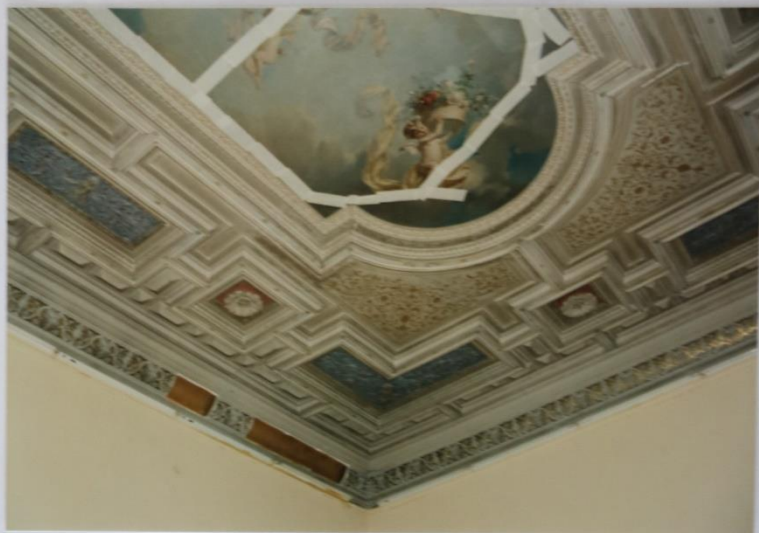
15 - M.Č.112: STROP NAD J STĚNOU
