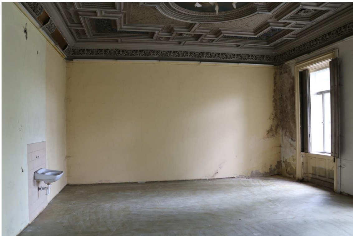
Salon – betonová podlaha, umyvadlo; okenice v okně
