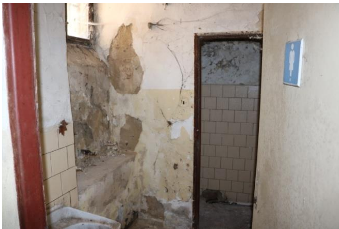
chodbička a záchod v přístavbě
