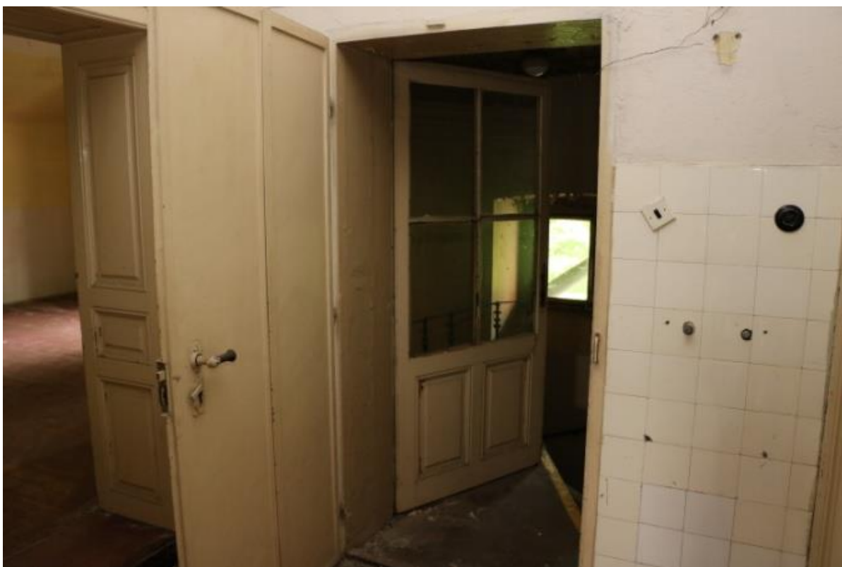
Vstupní dveře na půdu – dřevěné prosklené + kovové protipožární
