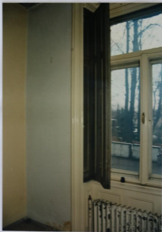
17 - M.Č.112: OKNO SZ STĚNA
