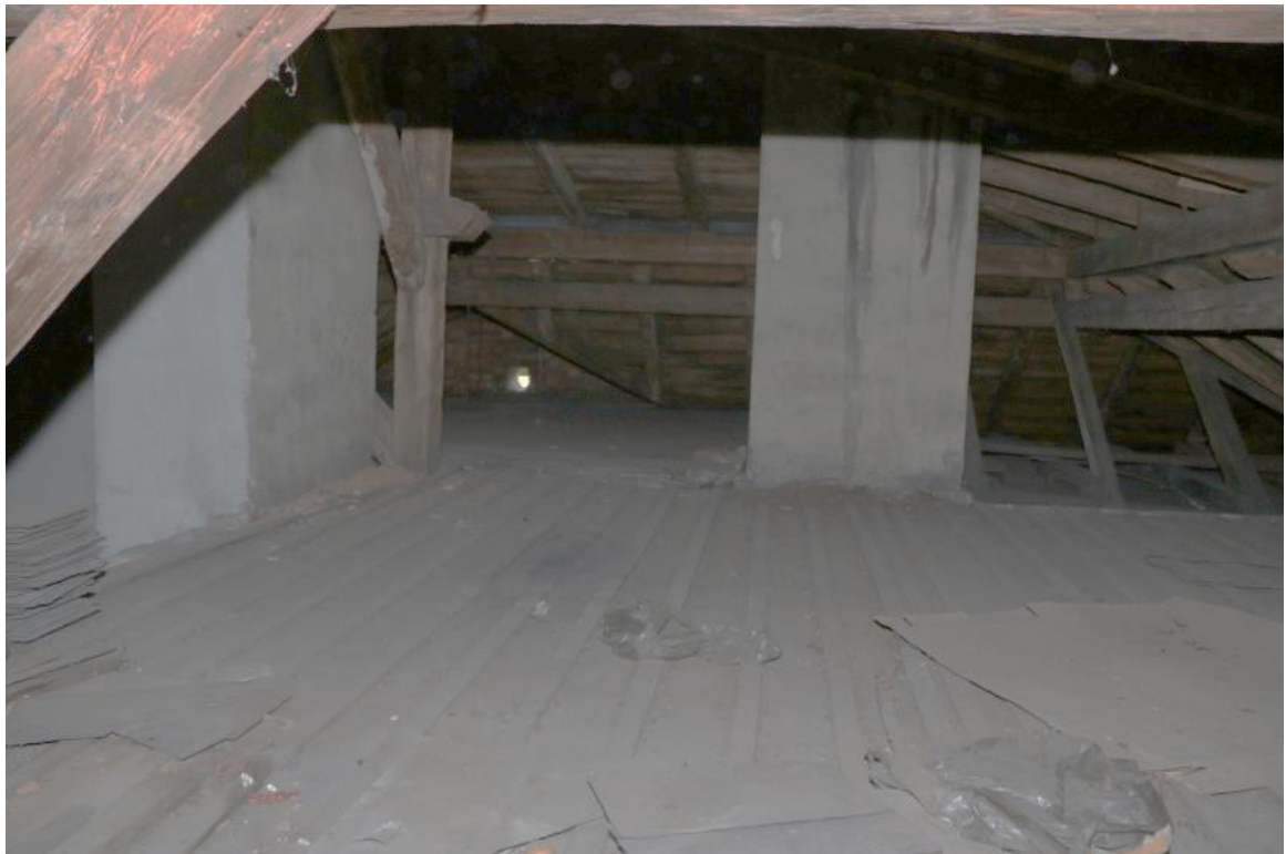
Původní bednění chodby shora
