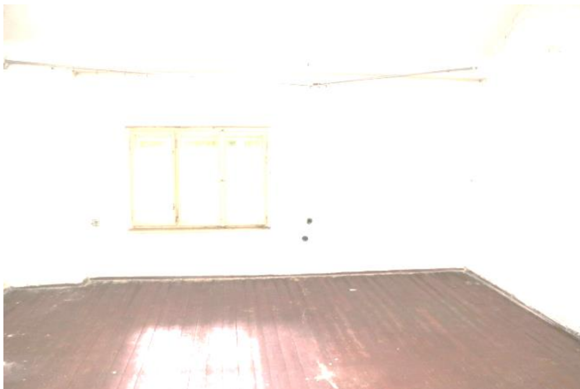
Učebny v SV části 2.místnost s novým oknem místo původního dvoukřídleho
