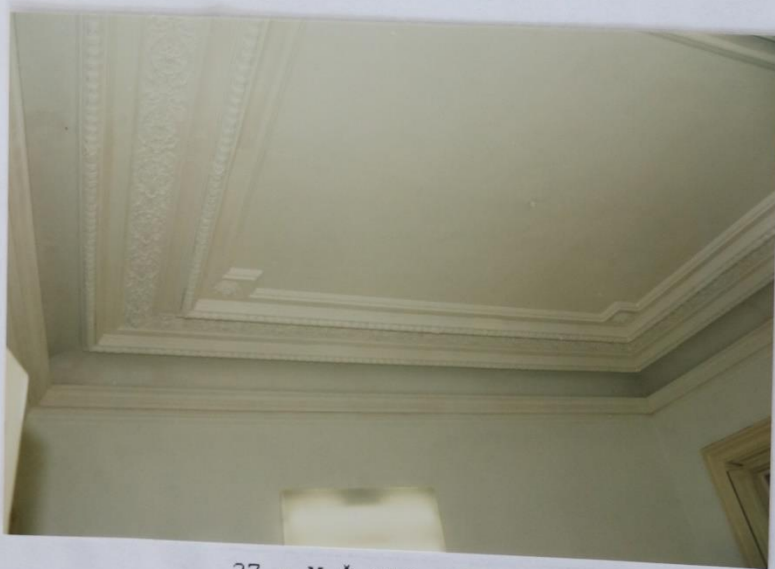
27 - M.Č.116: STROP NAD SV STĚNOU
