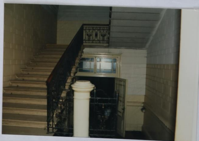
03 - M.Č.102: VSTUP DO 1.PP
