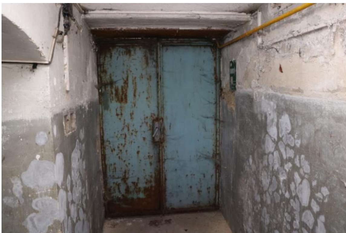
Nové kovové dveře z rampy do chodbičky (S)
