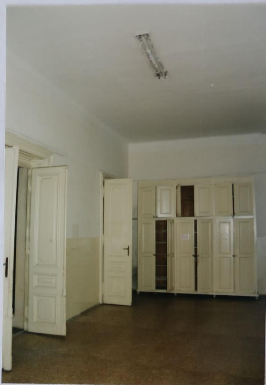
37 - M.Č.202: VSTUP ZE SCHODIŠTĚ
