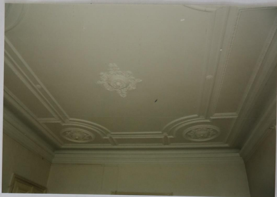
52 - M.Č.211: STROP NAD SV STĚNOU
