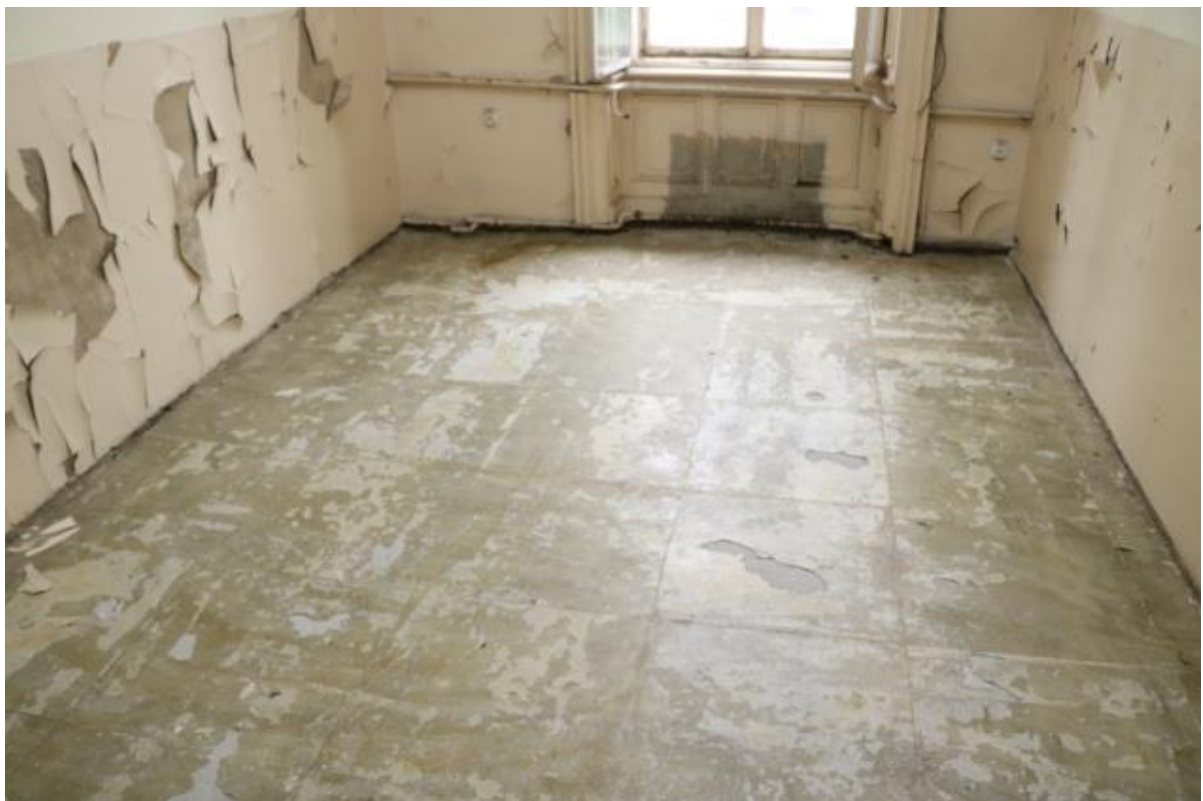
místnost vedle hl.schodiště - holé zdi, betonová podlaha
