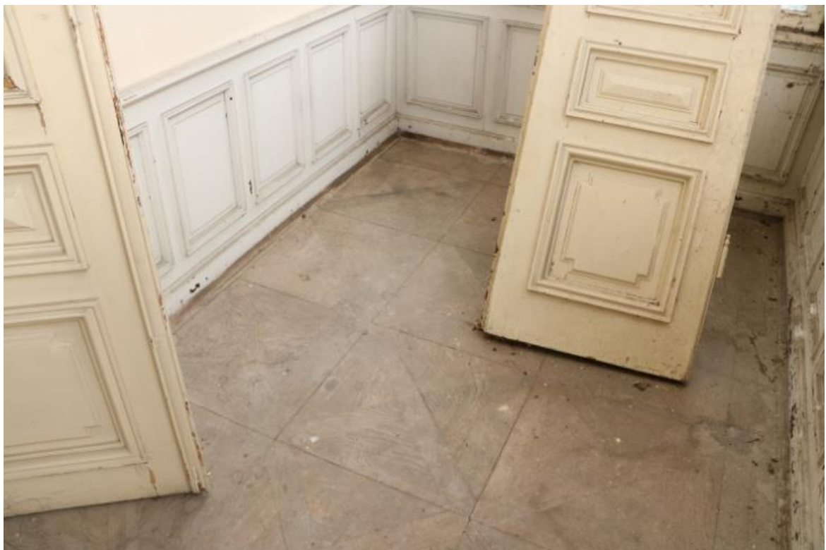
Lodžie – dřevěné obložení, parkety
