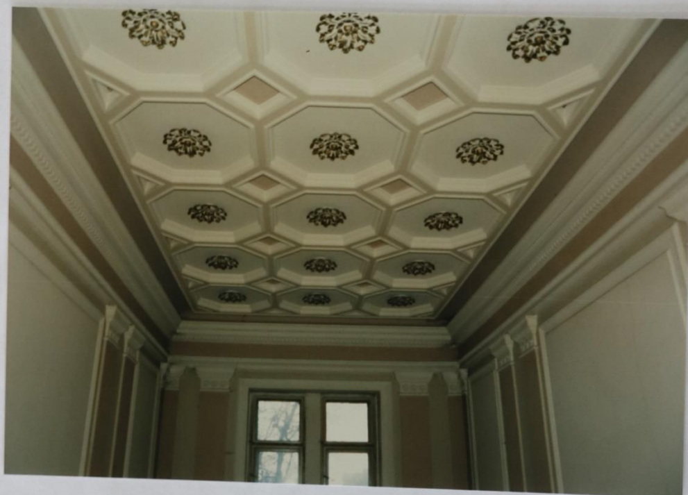
35 - M.Č.201: STROP NAD MEZIPODESTOU
