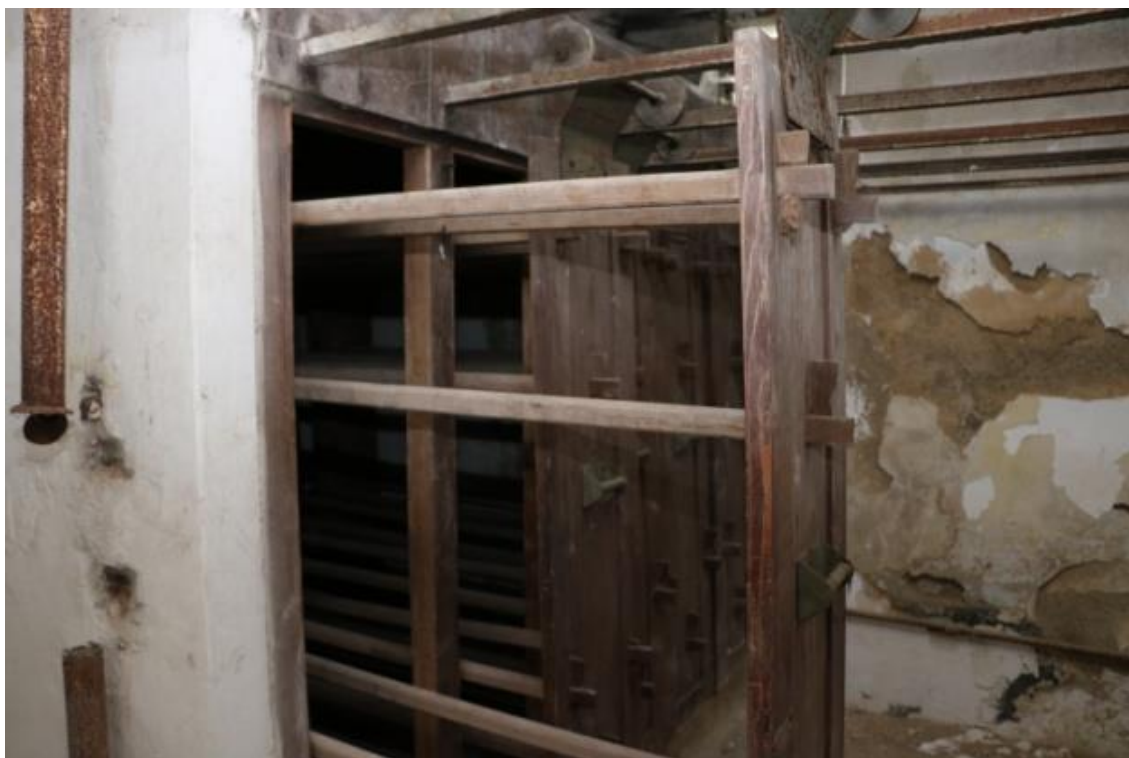
Sušárna – zasouvání jednotlivých dílů do prostoru suš. zařízení
