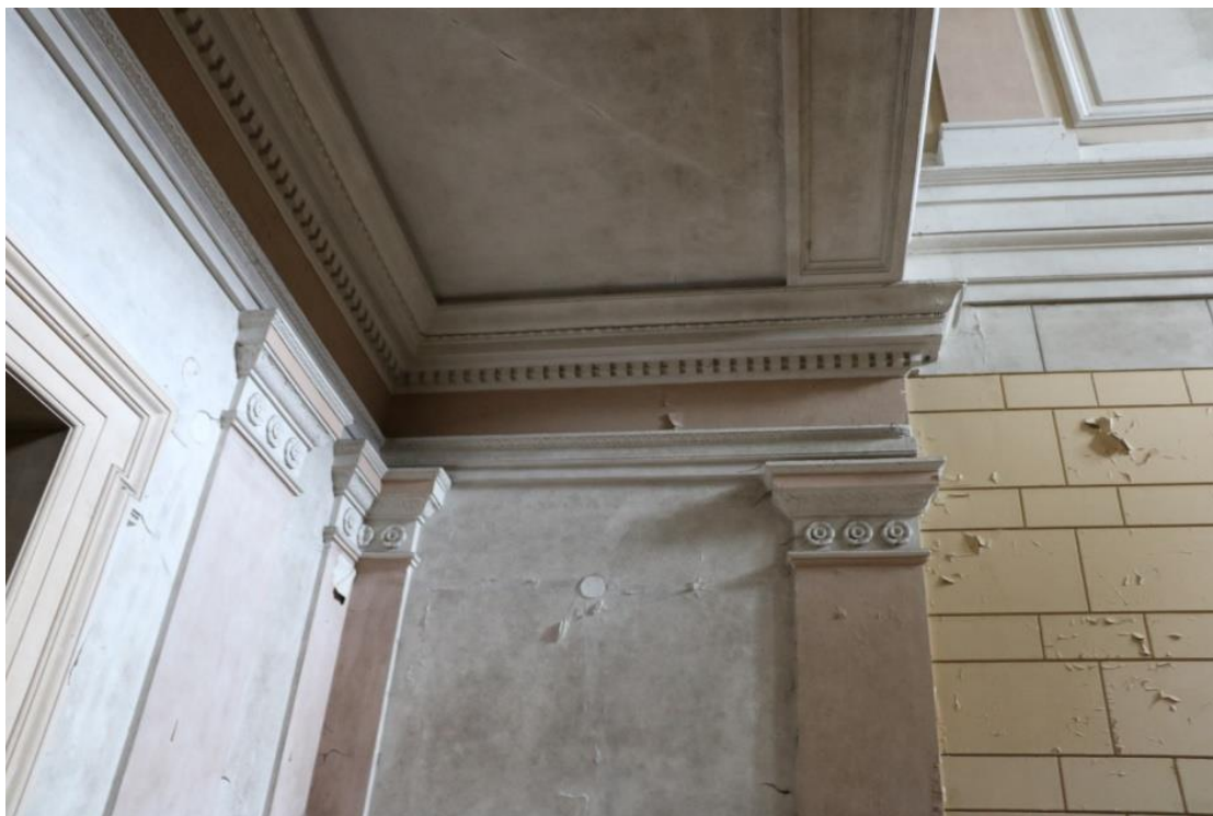
Podesta 1.NP – Mramorové obložení - pilastry s růžicemi, výplně mezi nimi, římsa Podhled mramorové kvádrování stěn
