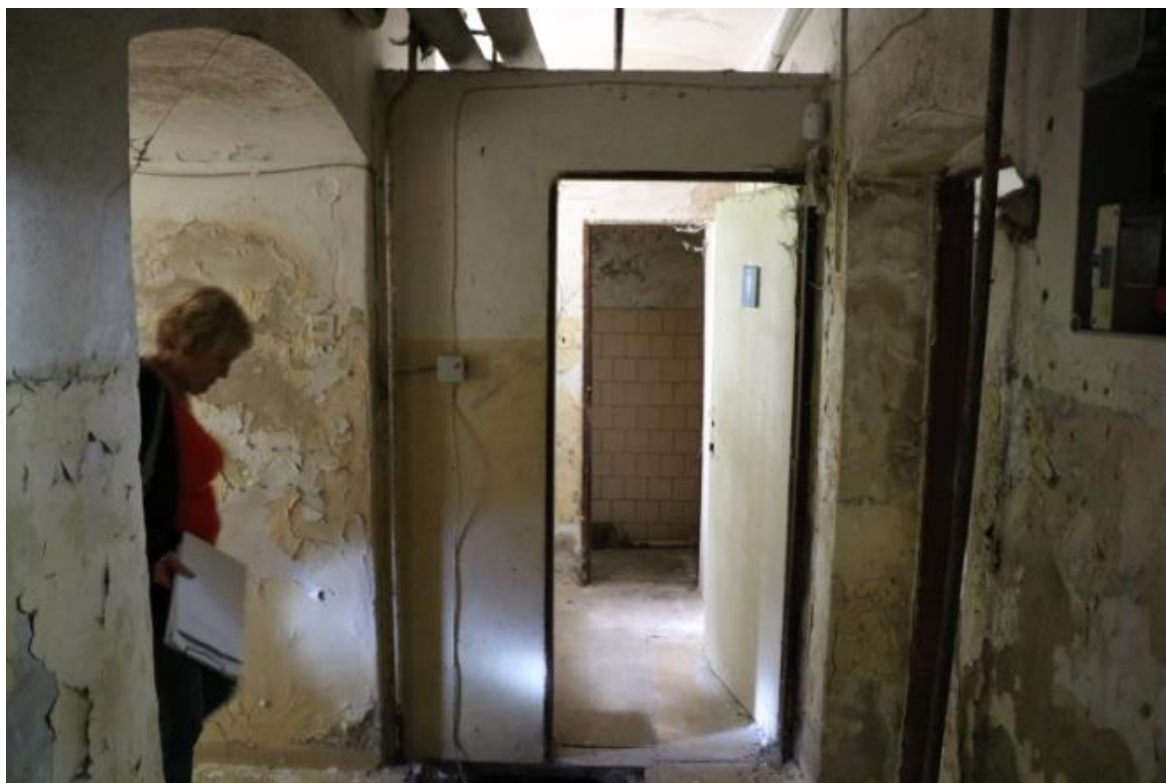
vstup do přístavby
