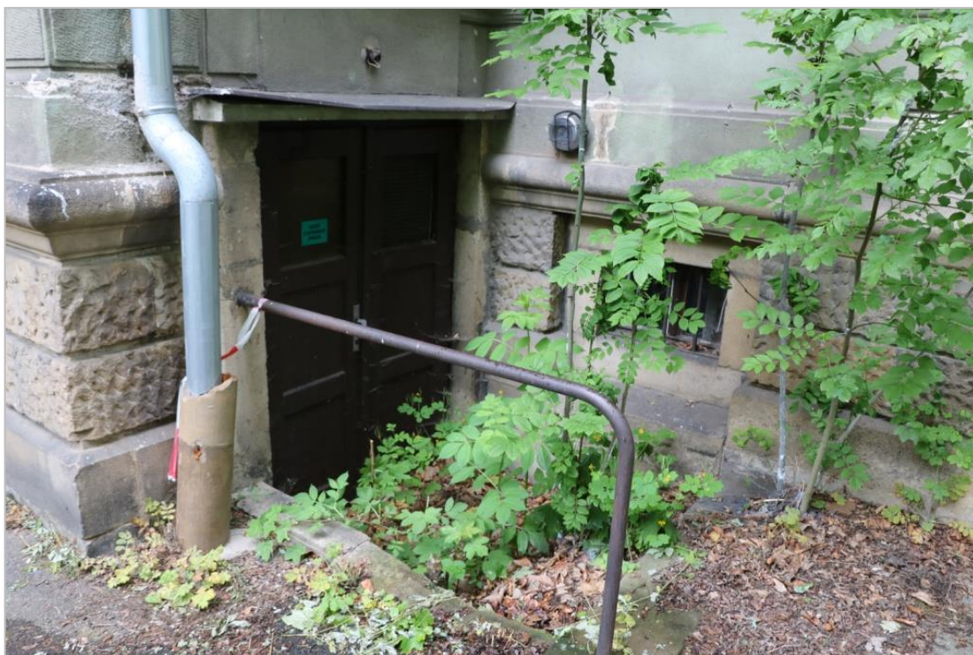
Dveře na zahradní schodiště do sklepa
