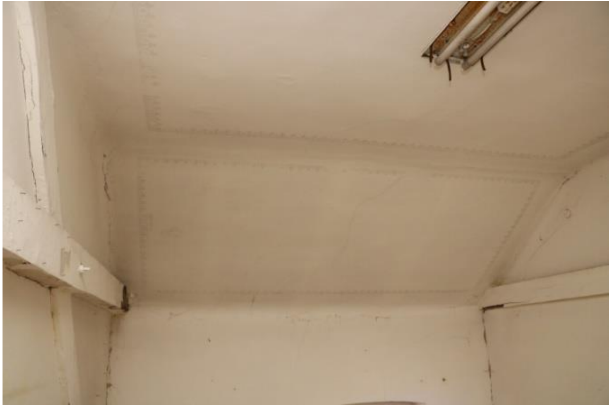
Předpokoj s viditelnými konstrukcemi
