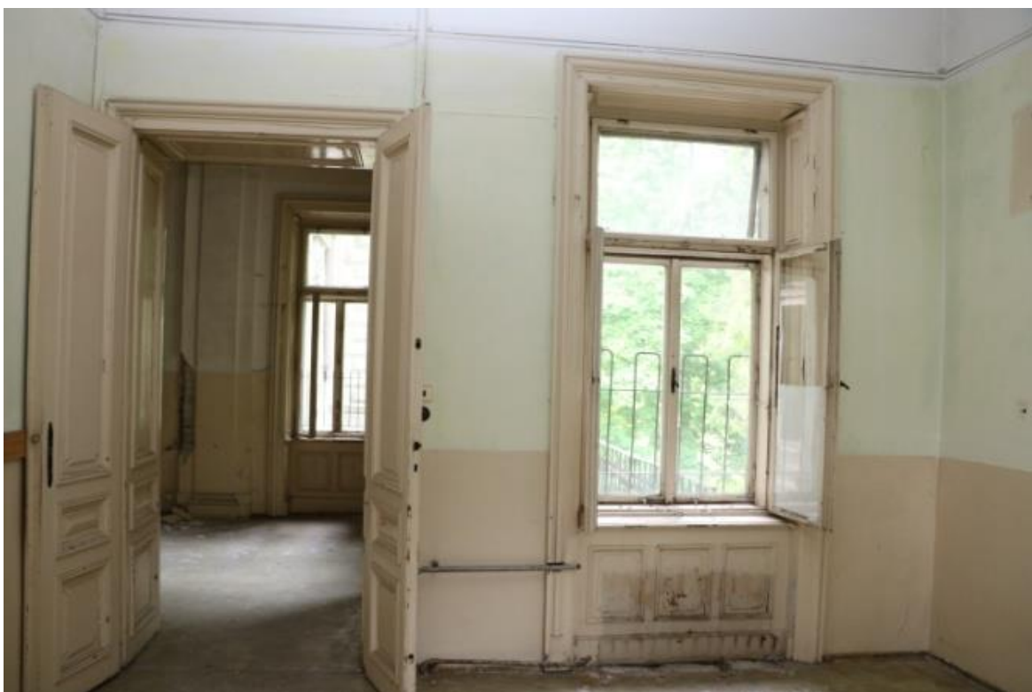
Přístavba – první místnost (u schodiště) - dveře s haly, okno do dvora
